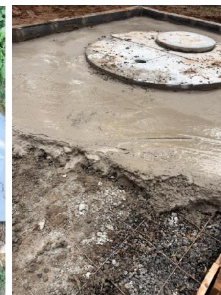
Tela com brita e concretagem
