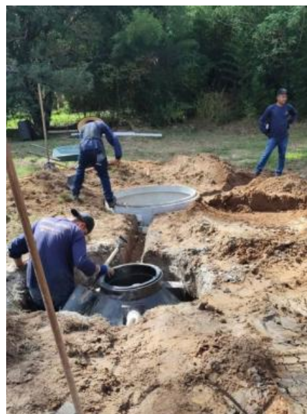
Instalação dos anéis de concreto
