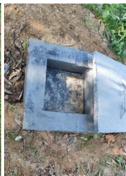
Instalação da CAIXA de gordura
