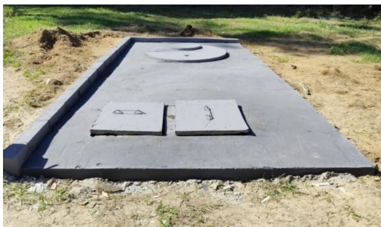
Sistema finalizado com as tampas de concreto prontas e pintura realizada
