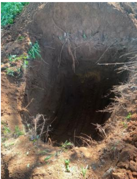
Limpeza do terreno e abertura das valas de instalação
