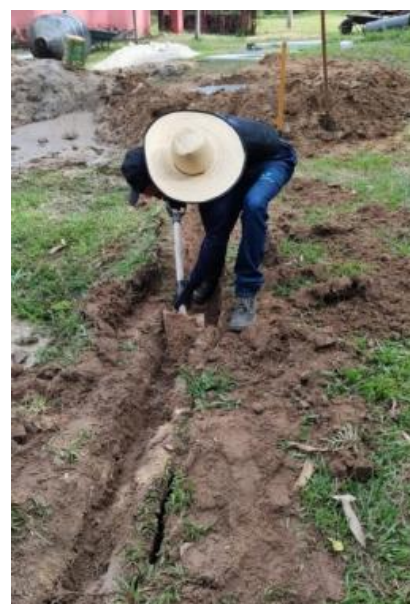
Abertura das valas para fazer a ligação do sistema para a residência
