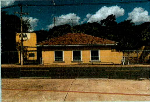
Infraestrutura da captação
