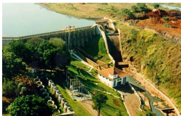
FIGURA 2.4.2.26 Barragem e Usina Hidroelétrica de Cariobinha – Ribeirão do Quilombo – Afluente do rio Piracicaba da margem direita - CPFL.
