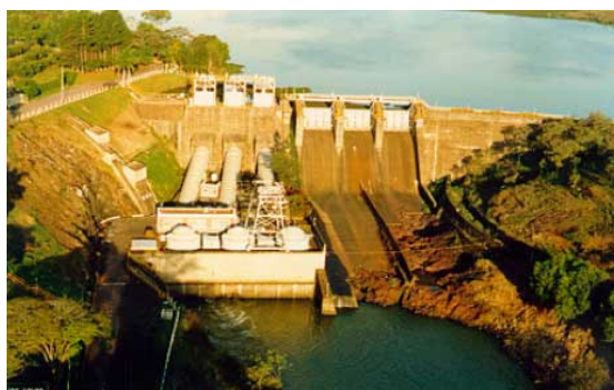
FIGURA 2.4.2.25 – Barragem e Usina Hidroelétrica de Americana – CPFL.
