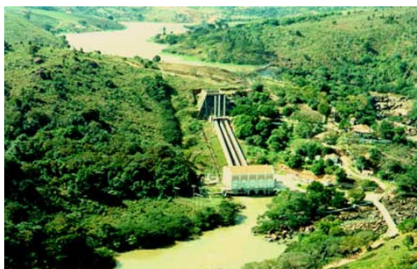
FIGURA 2.4.2.27 Barragem e Usina Hidroelétrica de Jaguari – Rio Jaguari – CPFL.
