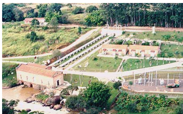
FIGURA 2.4.2.28 Usina Hidroelétrica de Salto Grande – Rio Atibaia – CPFL.
