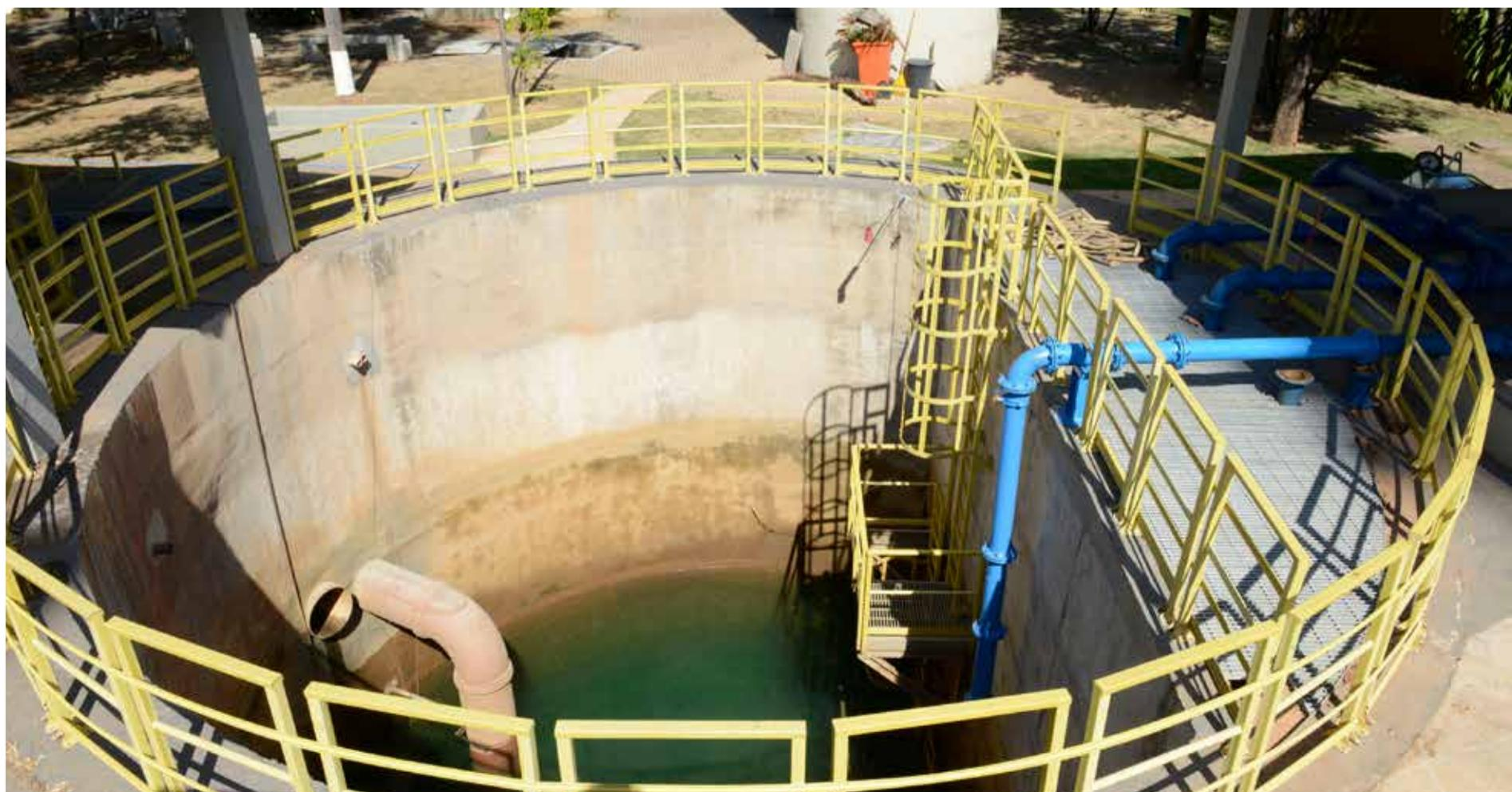
Sistema de coleta e reaproveitamento da água de lavagem dos filtros e decantadores da ETA I de Indaiatuba | Foto: Giuliano Miranda
