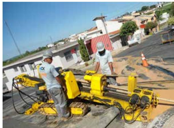
Substituição de redes hidráulicas de água com remanejamento de ligações domiciliares em Capivari | Foto: Saae Capivari
