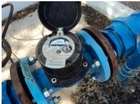
Figura 4.6. Detalhe do macromedidor de vazão instalado no Poço 01
