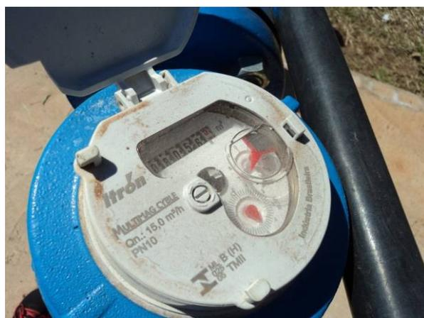
Figura 4.57. Detalhe do macromedidor de vazão instalado
