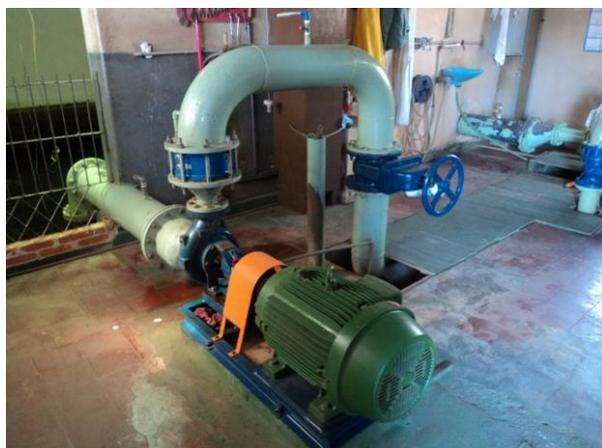
Figura 4.35. Vista do conjunto motor-bomba do recalque da Caixa Mãe.
