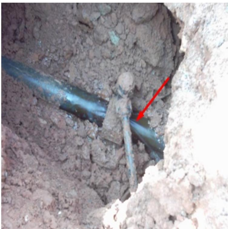
Figura 8.8. Localização do vazamento no ferrule
