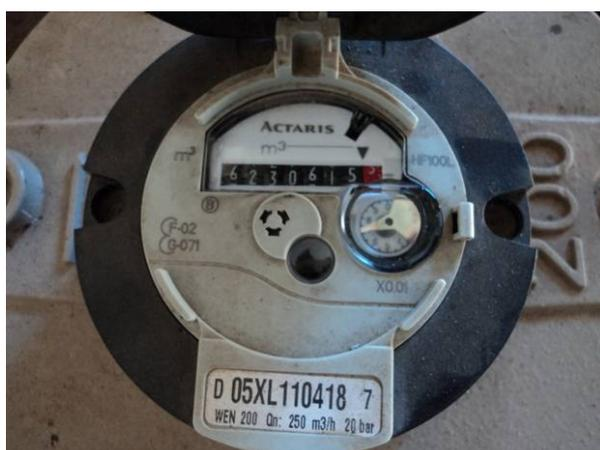
Figura 4.44. Detalhe macromedidor que está instalado na chegada do recalque da Caixa Mãe.
