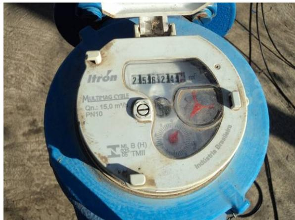
Figura 4.75. Detalhe do macromedidor de vazão instalado no Poço da Fazenda Leopoldina
