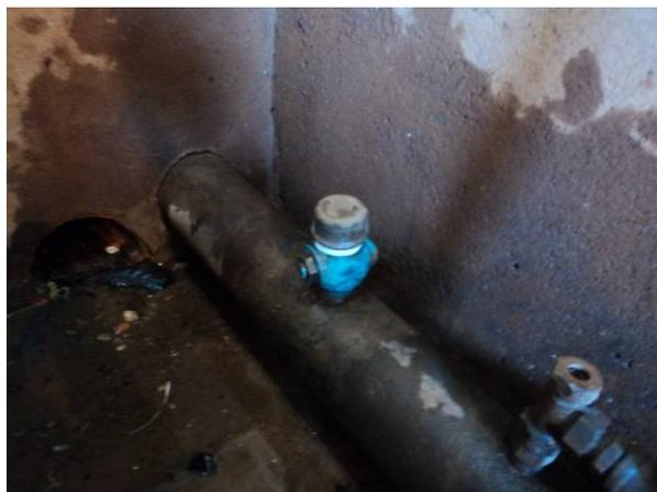
Figura 3.28. Vista da Estação Pitométrica Existente para as medições 06, 07 e 08
