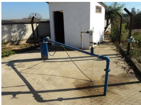
Figura 4.67. Detalhe da aplicação do cloro e do flúor
