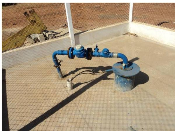
Figura 4.9. Vista geral do Poço 02 sem laje sanitária
