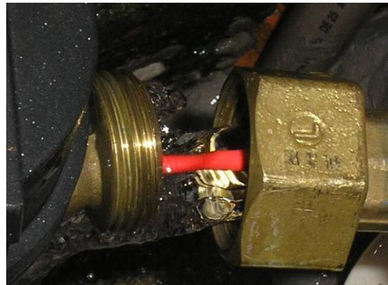
Figura 10.16. Hidrômetro com arame
