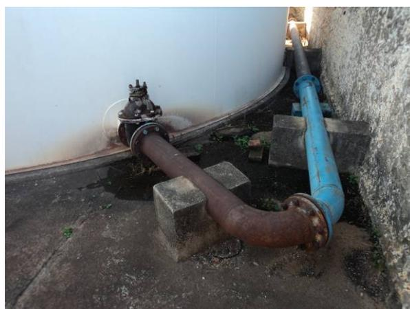
Figura 4.49. Detalhe da tubulação de saída para hidrante
