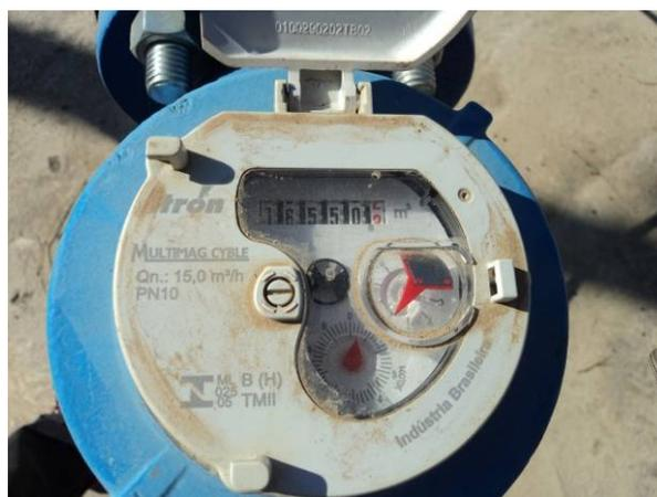
Figura 4.66. Detalhe do macromedidor de vazão instalado
