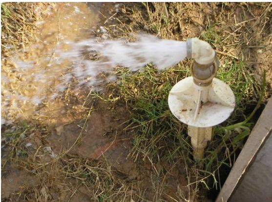
Figura 10.15. Cavalete sem hidrômetro
