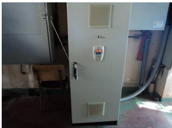
Figura 4.37. Vista externa do painel contendo inversor de frequência em bom estado de conservação dos conjuntos motor-bombas do recalque da Caixa Mãe
