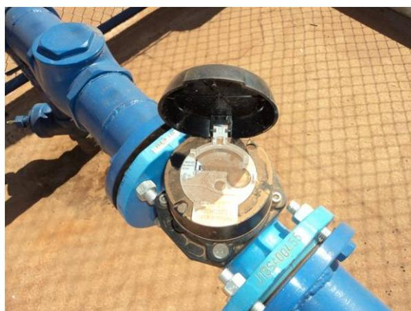
Figura 4.19. Detalhe do macromedidor de vazão instalado do Poço 04.
