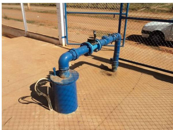
Figura 4.18. Vista geral do Poço 04 sem laje sanitária
