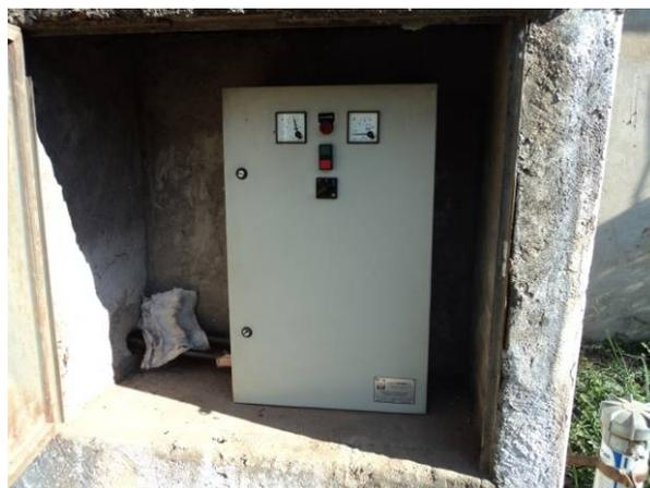
Figura 4.77. Vista externa do painel elétrico do Poço da Fazenda Leopoldina
