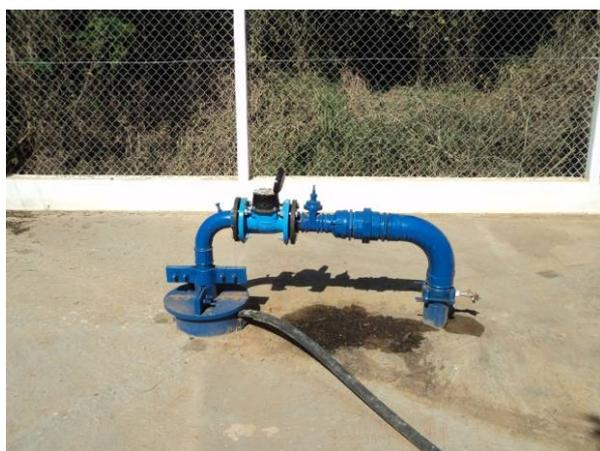
Figura 4.14. Vista geral do Poço 03 sem laje sanitária
