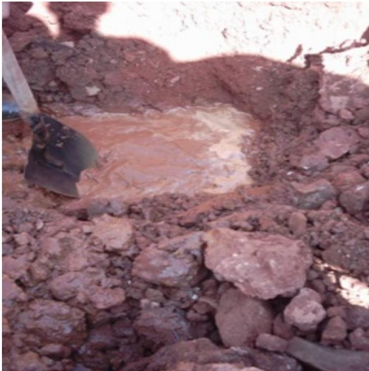
Figura 8.7. Localização do vazamento não visível
