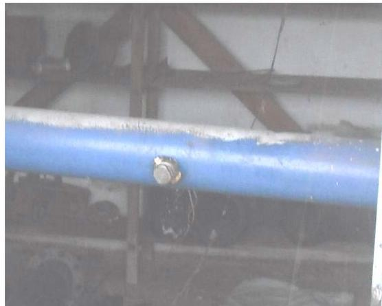
Figura 1.10. Vista do TAP instalado na tubulação
