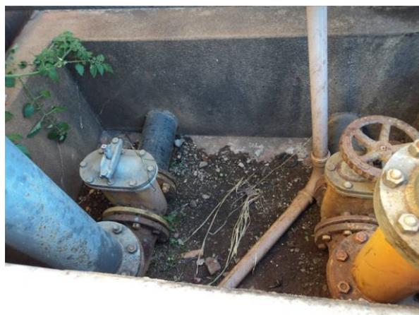
Figura 4.47. Detalhe das tubulações de saída para o recalque
