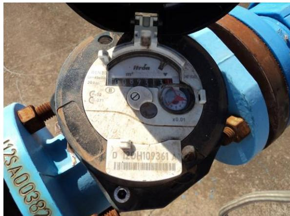
Figura 4.29. Detalhe do macromedidor de vazão instalado no Poço 06.
