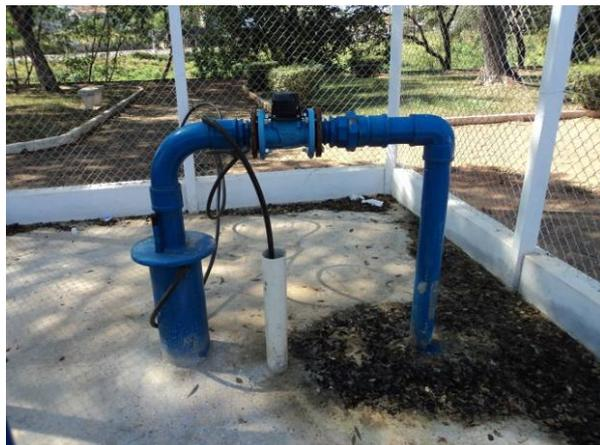
Figura 4.5. Vista geral do Poço 01 sem laje sanitária
