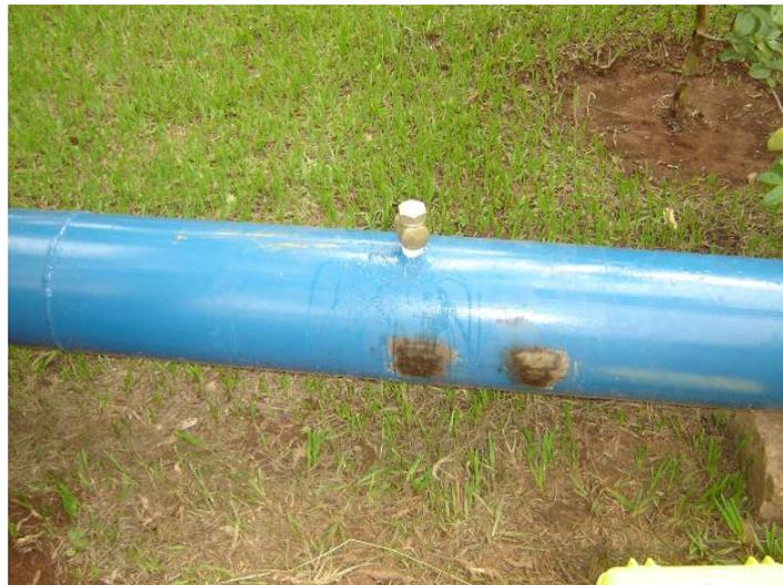
Figura 3.15. Estação Pitométrica (EP) instalada em uma tubulação de água
