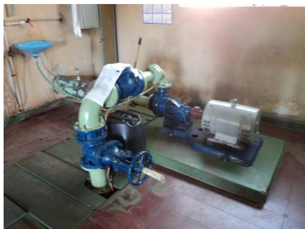
Figura 4.36. Vista do conjunto motor-bomba do recalque da Caixa Mãe.
