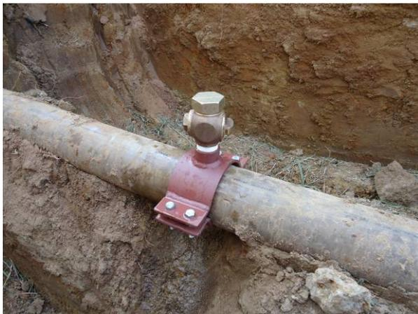
Figura 3.32. Vista da Estação Pitométrica Instalada para a Medição 10
