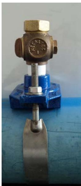
Figura 1.11. Vista do TAP Instalado na tubulação
