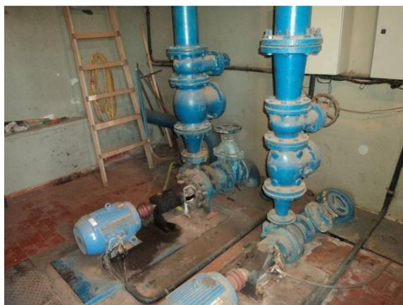
Figura 4.51. Detalhe dos conjuntos motor-bombas do reservatório Central Metálico
