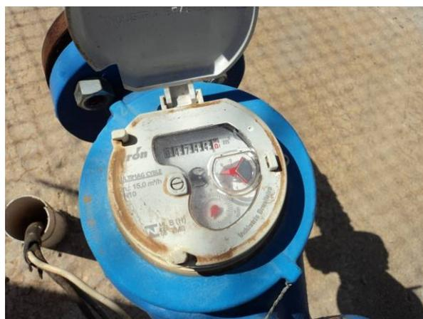
Figura 4.10. Detalhe do macromedidor de vazão instalado no Poço 02.
