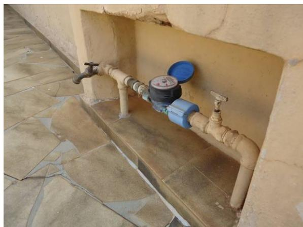
Figura 11.2. Cavalete existente em uma residência no município de Rafard.
