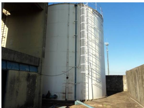
Figura 4.48. Vista Geral do Reservatório Central Metálico e tubulação de entrada
