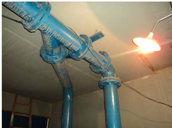
Figura 4.53. Detalhe da tubulação de entrada do Reservatório Central Elevado
