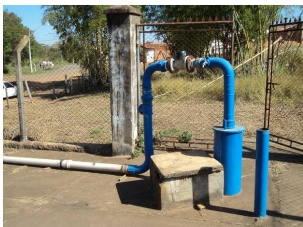
Figura 4.24. Vista geral do Poço 05 sem laje sanitária
