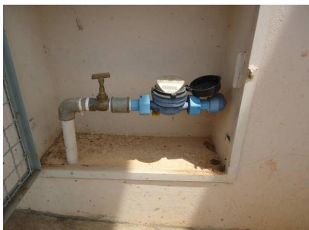
Figura 11.3. Cavalete existente em uma residência no município de Rafard.
