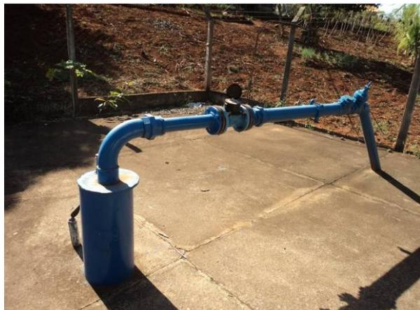
Figura 4.28. Vista geral do Poço 06 sem laje sanitária
