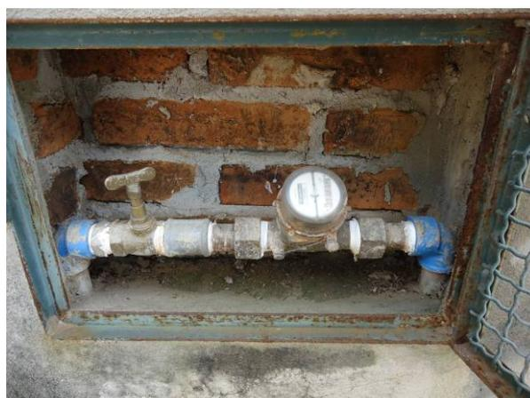
Figura 11.4. Caixas de proteção utilizadas nos cavaletes de duas residências do município de Rafard.
