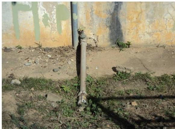
Figura 4.72. Detalhe da tubulação de saída do Reservatório
