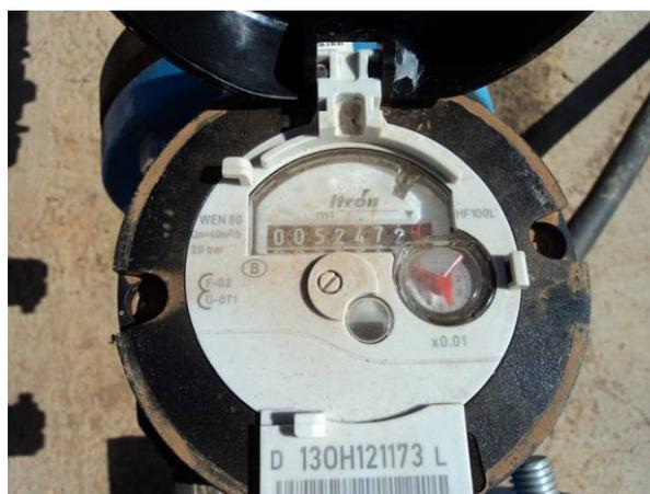
Figura 4.15. Detalhe do macromedidor de vazão instalado no Poço 03.
