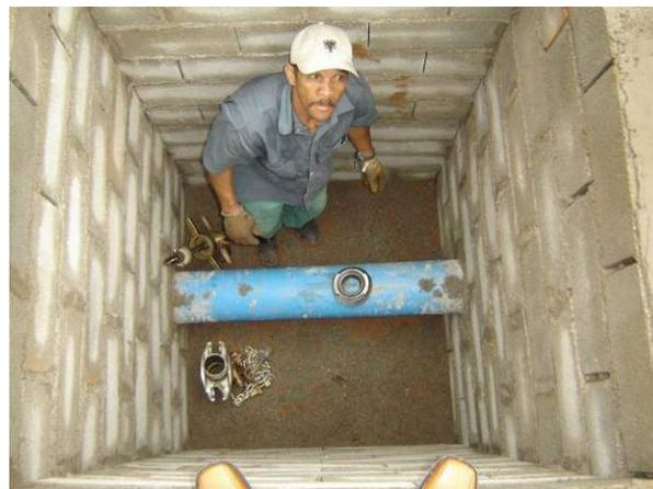
Figura 3.7. Colocação do anel de borracha
