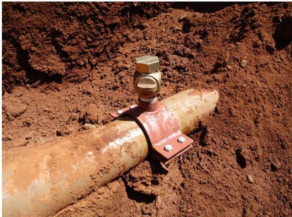
Figura 3.36. Vista da Estação Pitométrica Instalada para a Medição 12
