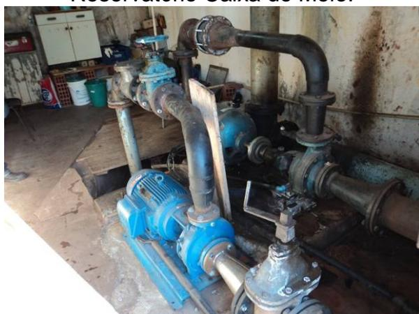
Figura 4.42. Detalhe das bombas de recalque do Reservatório Caixa do Meio.
