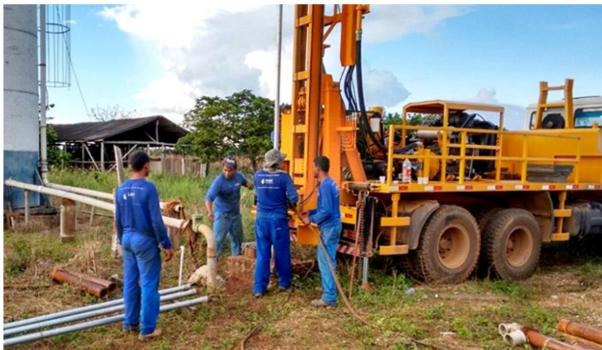
Figura 4.84. Ilustração de manutenção de poço tubular profundo
