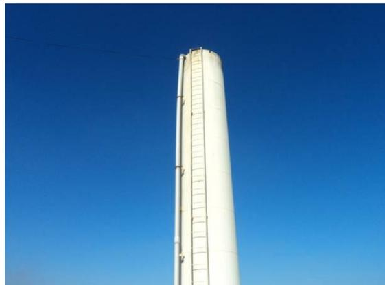
Figura 4.80. Detalhe da tubulação de entrada do Reservatório da Fazenda Leopoldina
