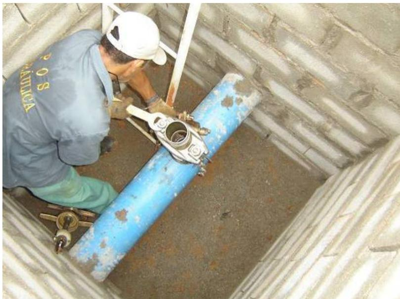
Figura 3.8. Colocação do suporte da máquina Miller
