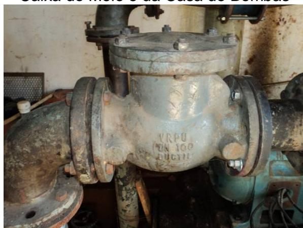
Figura 4.43. Detalhe da válvula de retenção existente no recalque.
