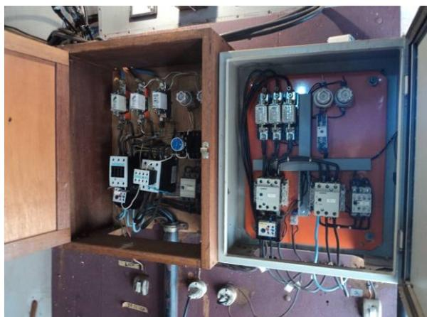
Figura 4.46. Vista interna do painel elétrico em bom estado
