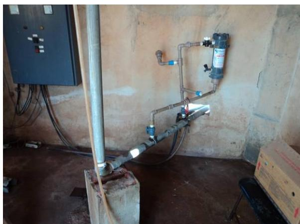
Figura 4.58. Detalhe da aplicação do cloro e do flúor
