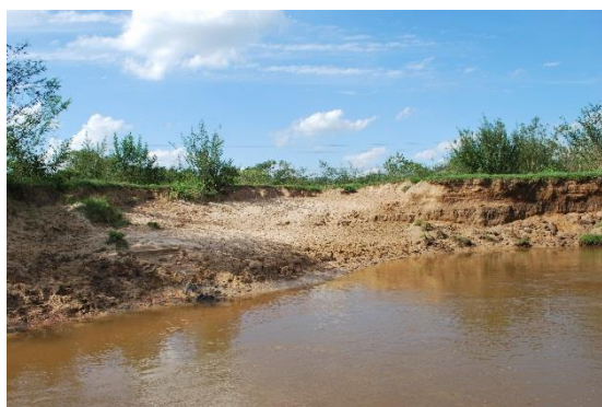
Figura 3.13 – Processos erosivos nas margens e assoreamento no Rio Passa Cinco, trecho correspondente ao município de Ipeúna
