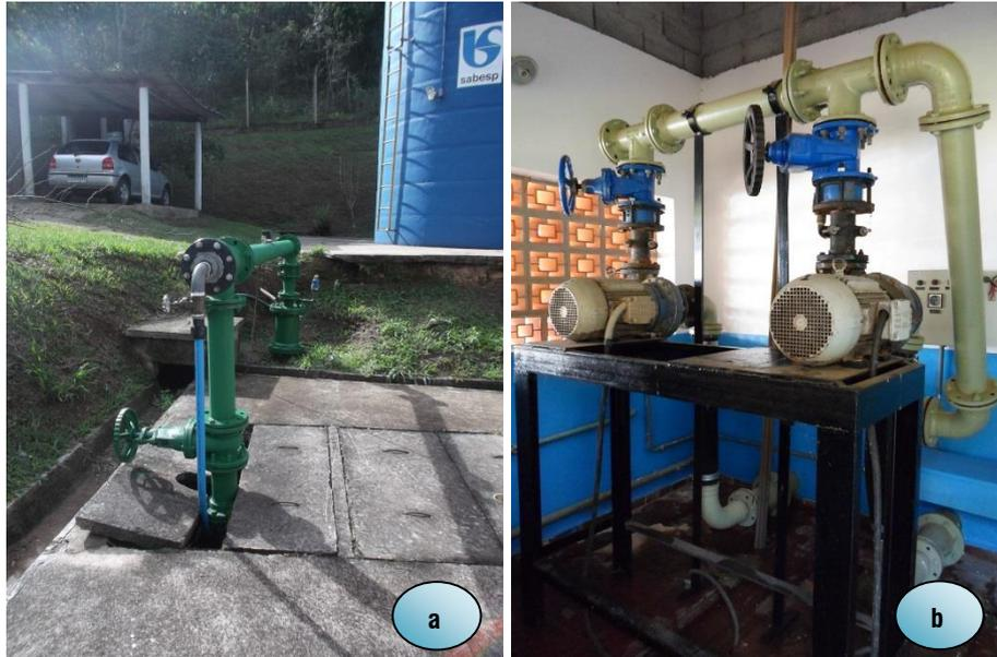
**Figura 31 - EEAT ETA: a) bombas submersas em funcionamento ; b) bombas reserva.**
