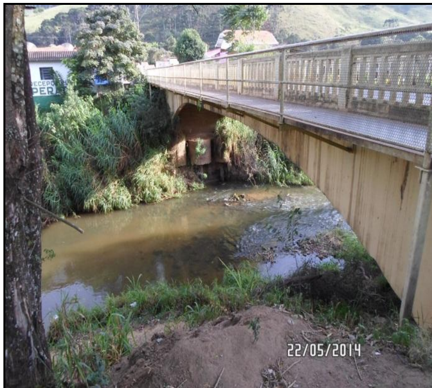
Figura 75 - Detalhe da ponte sobre o rio Sapucaí. Nota o nível d'água e a altura da ponte
