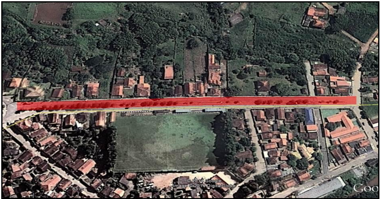
Figura 90 - Diagnóstico do Sistema de Microdrenagem em Sapucaí-Mirim, na Rua Jaguari
