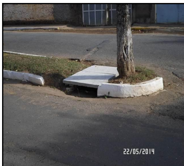
Figura 93 - Vista de uma Boca-de-lobo localizada no canteiro central
