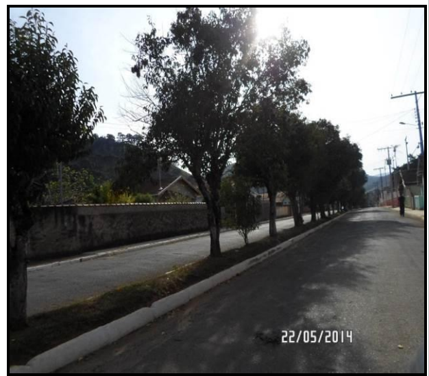
Figura 92 - Vista da Rua Jaguari, Existência de sistema de microdrenagem na via
