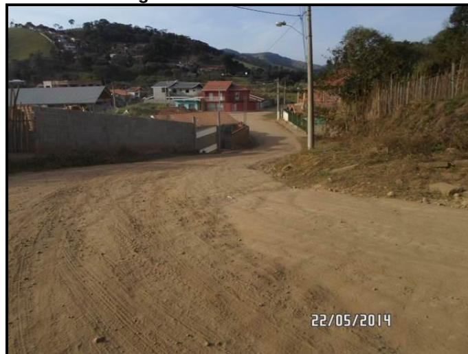
Figura 97 - Via sem pavimentação. Sistema de microdrenagem inexistente
