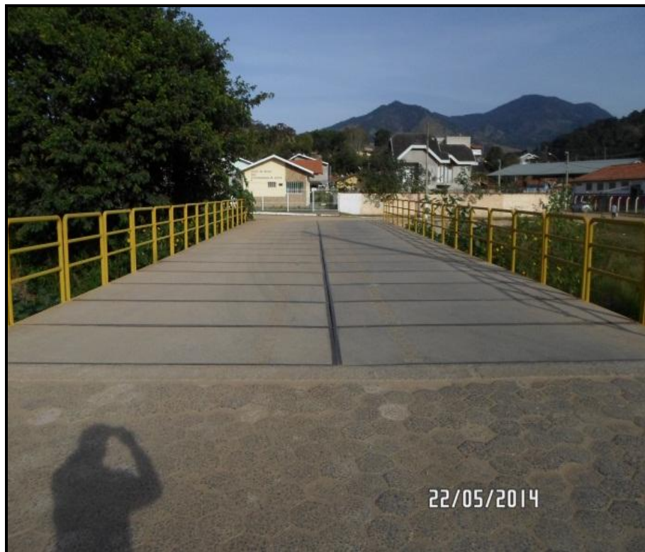
Figura 73 - Vista da ponte recém-construída
