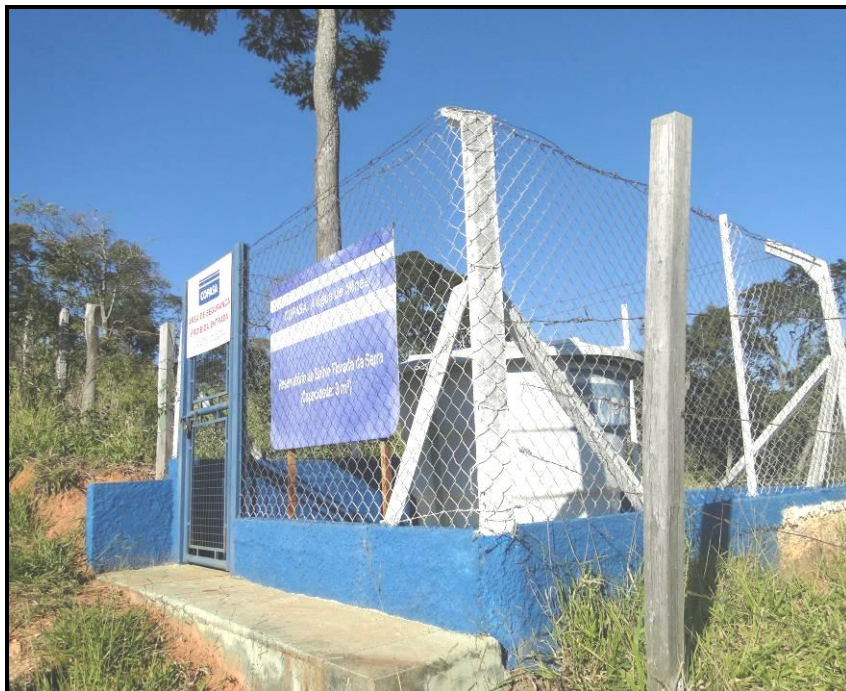
Figura 55 - Reservatório R3 - Florada da Serra - Capacidade: 3 m³
