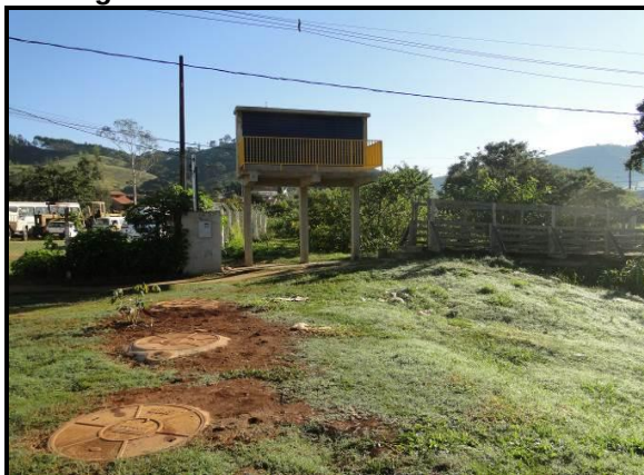
Figura 56 - Estação Elevatória de Esgoto 1
