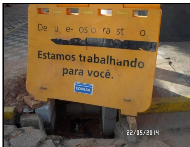
Figura 89 - Manutenção na boca-de-lobo localizada na Avenida Tancredo Neves
