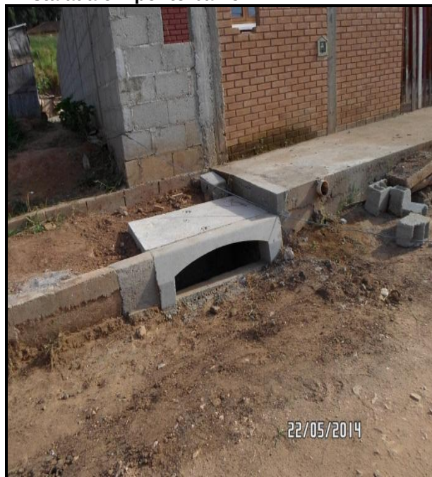
Figura 101 - Vista de uma Boca-de-lobo recém-instalada em ponto baixo
