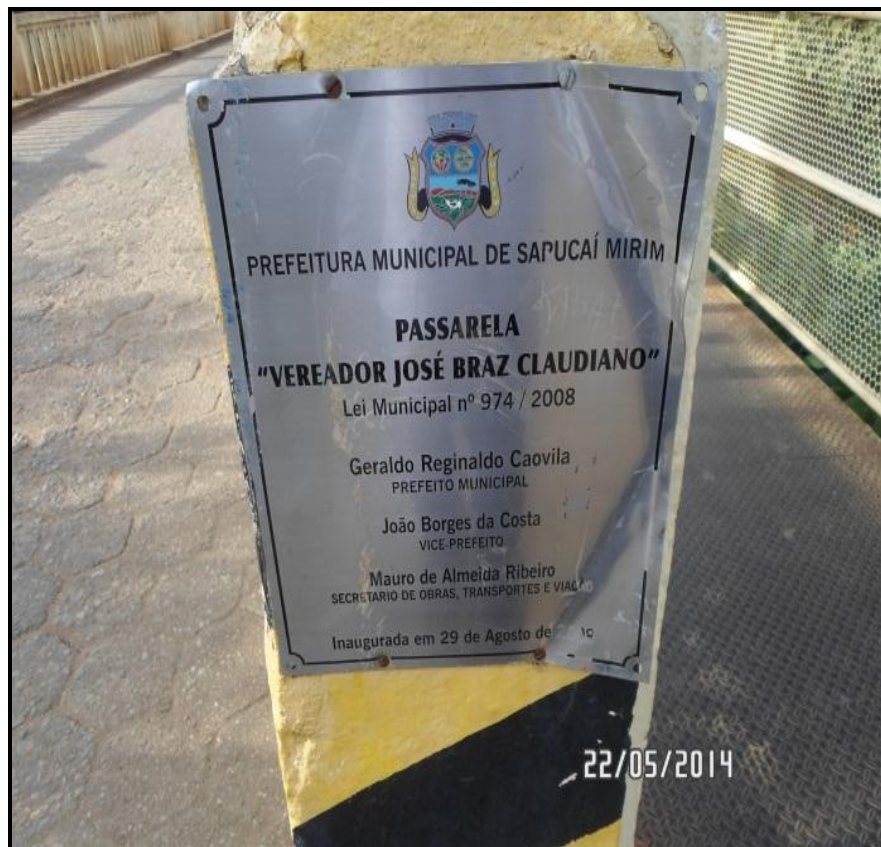
Figura 77 - Vista de placa de inauguração da ponte em 2008
