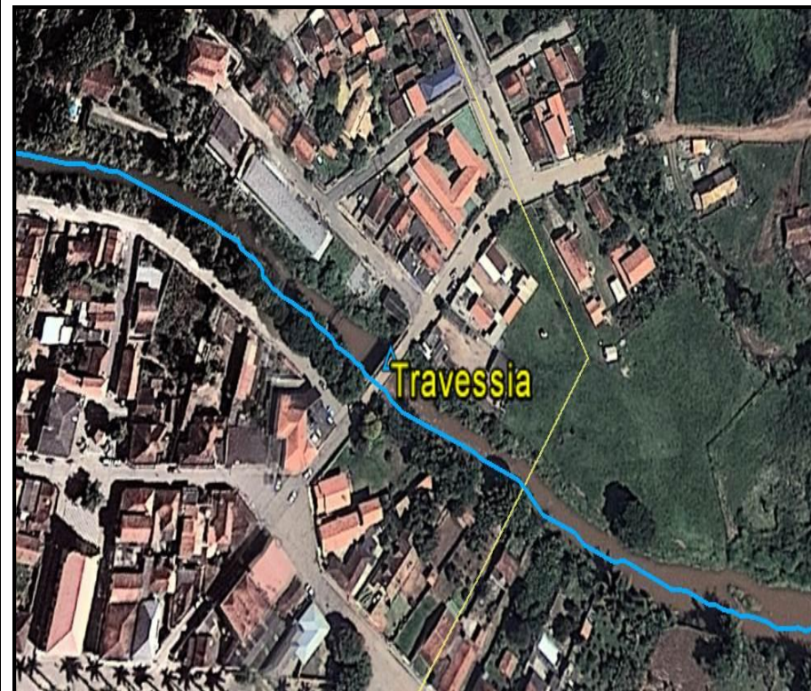
Figura 74 - Travessia 02 sobre o Rio Sapucaí
