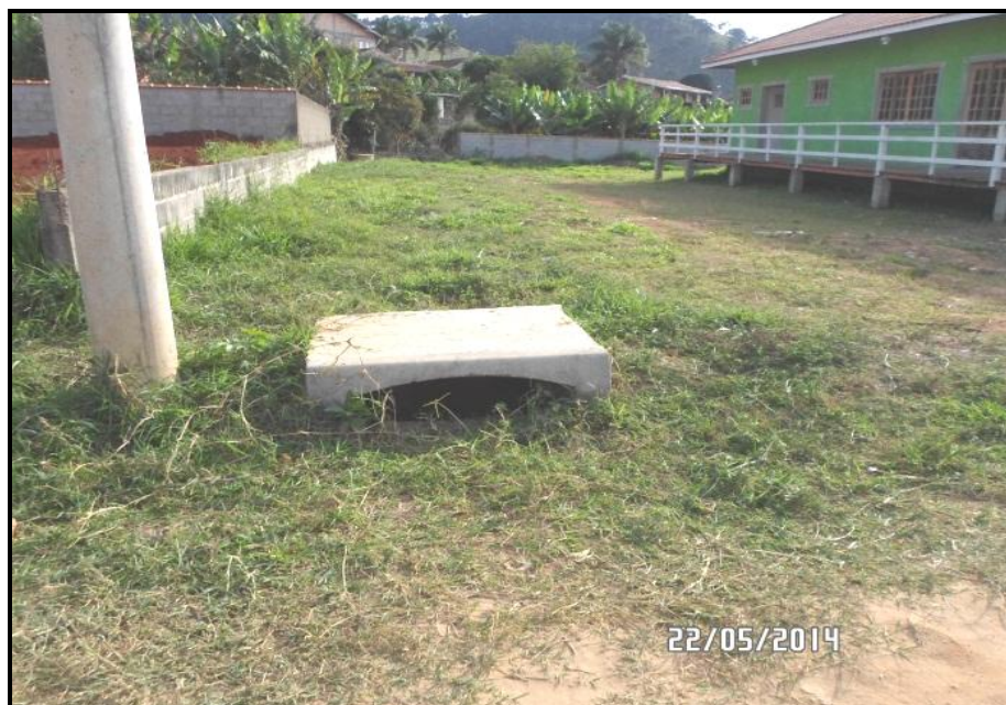
Figura 102 - Vista de uma Boca-de-lobo recém-instalada em ponto baixo. Local tinha problemas de alagamentos
