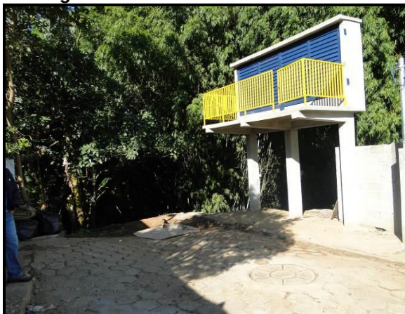
Figura 59 - Estação Elevatória de Esgoto 4
