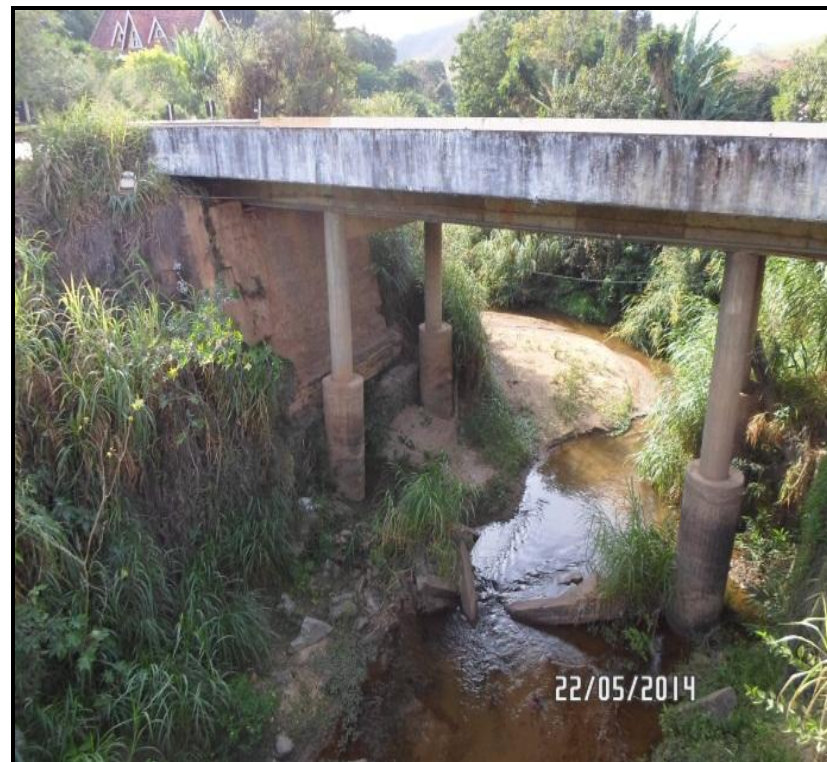
Figura 80 - Detalhe da ponte sobre o Ribeirão do Baú. Nota o nível d'água e a altura da ponte
