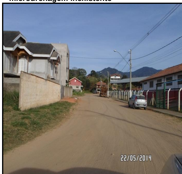
Figura 98 - Via sem pavimentação. Sistema de microdrenagem inexistente
