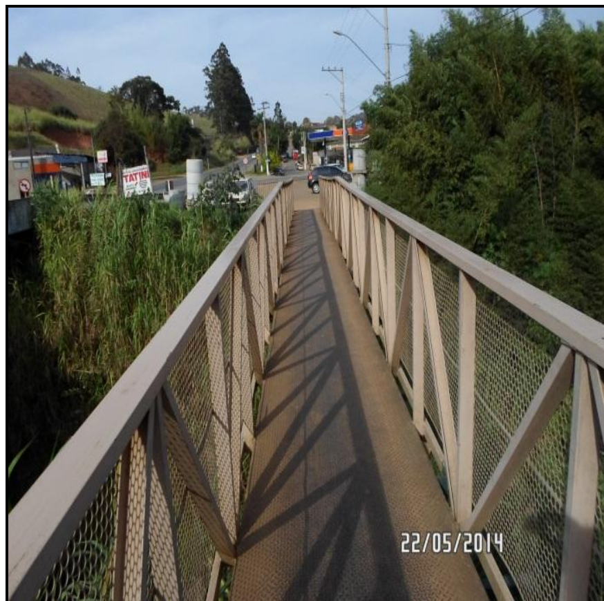
Figura 81 - Detalhe da passarela sobre o Ribeirão do Baú
