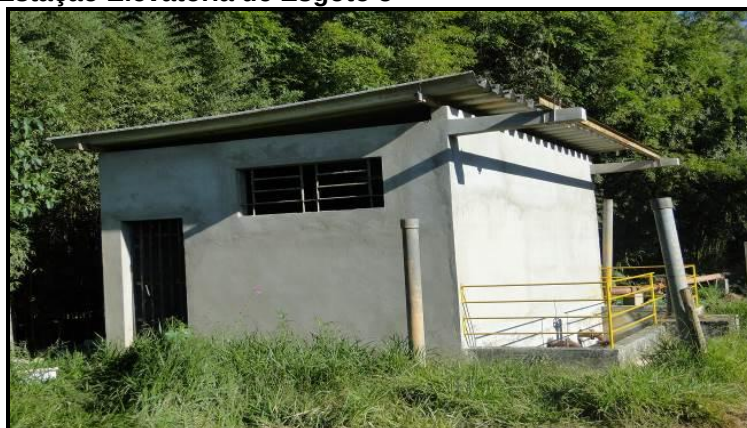
Figura 60 - Estação Elevatória de Esgoto 5
