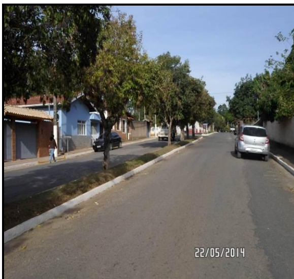
Figura 91 - Vista da Rua Jaguari, Existência de sistema de microdrenagem na via
