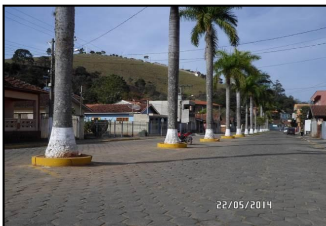
Figura 88 - Vista da Avenida Tancredo Neves. A via possui sistema de microdrenagem com bloquetes
