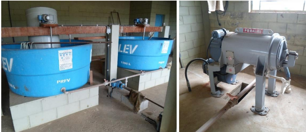
Figura 48 – Equipamento para dragagem do lodo da ETE.
