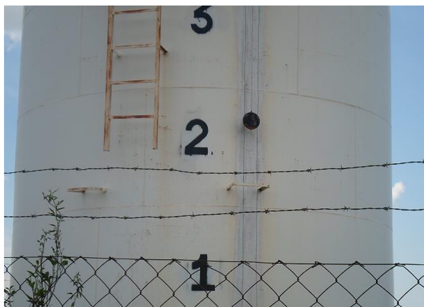
Figura 32 - Régua de medição de nível do reservatório.
