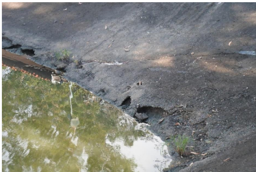
Figura 45 - Danos na estrutura do decantador.
