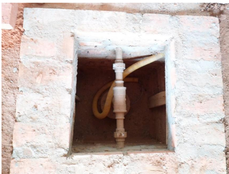
Figura 33 - Captação subterrânea para abastecimento de água na área rural do município de Saltinho.
