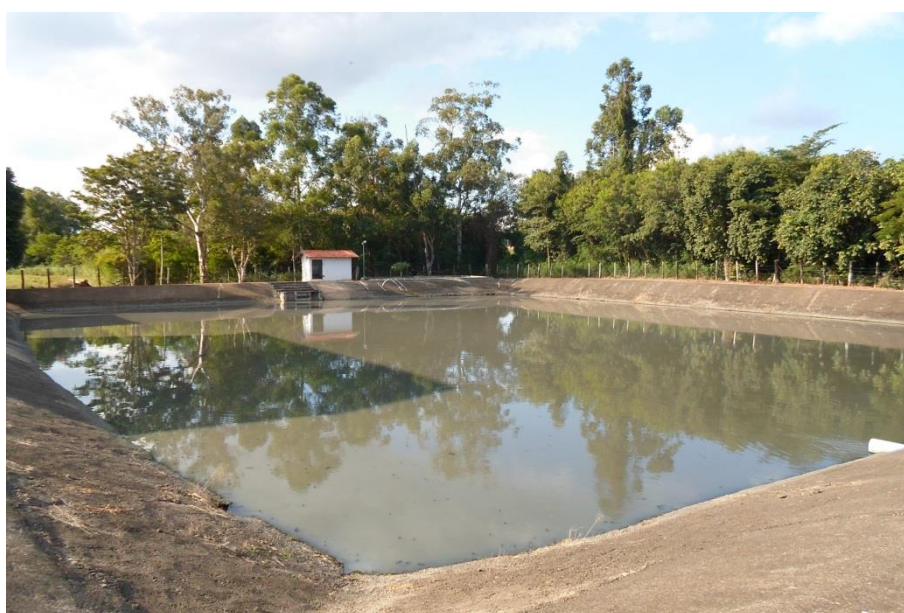
Figura 44 - Decantador da ETE.
