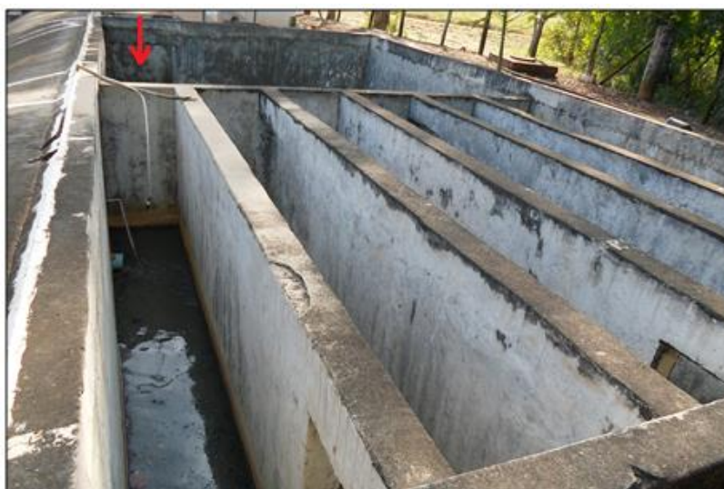
Figura 46 - Adição de cloro e tanque de contato.
