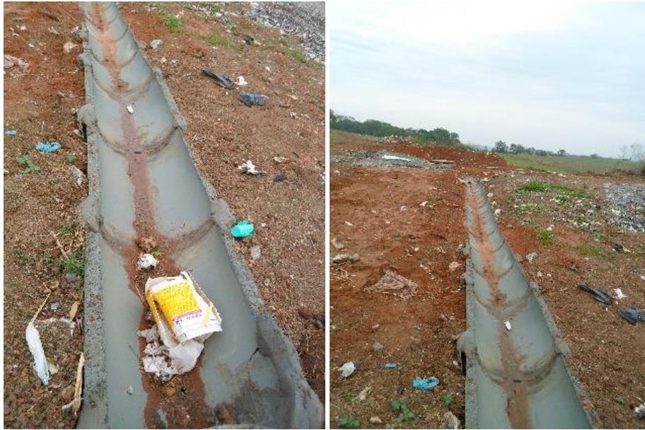
Figura 61 - Canaleta de escoamento.
