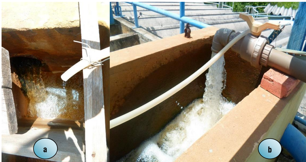
Figura 21 - Tratamento preliminar na chegada de água bruta. a) Módulo 1 b) Módulo 2.
