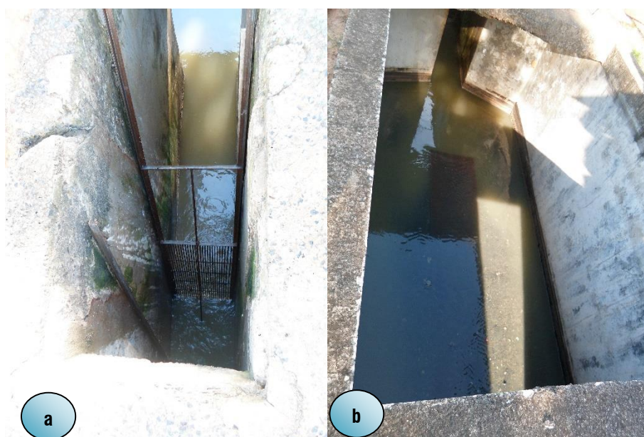
Figura 40 - (a) Gradeamento; (b) Caixa de areia.
