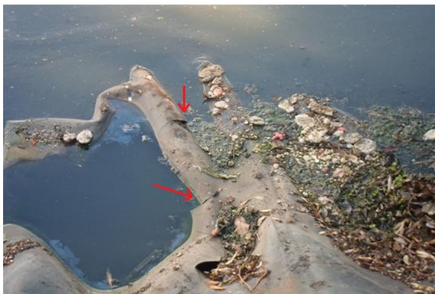
Figura 43 - Fissuras na manta de impermeabilização da lagoa de aerção.
