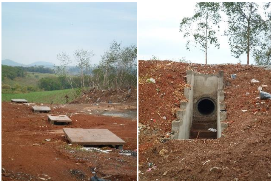
Figura 62 - Galerias para escoamento de águas pluviais.
