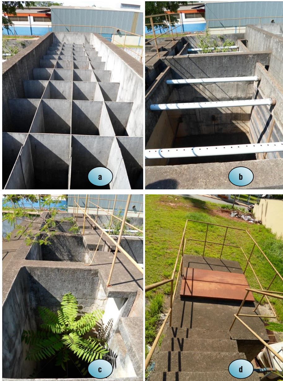
Figura 25 - ETA: a) floculador tipo chincana; b) decantadores; c) filtros; d) caixa de contato.
