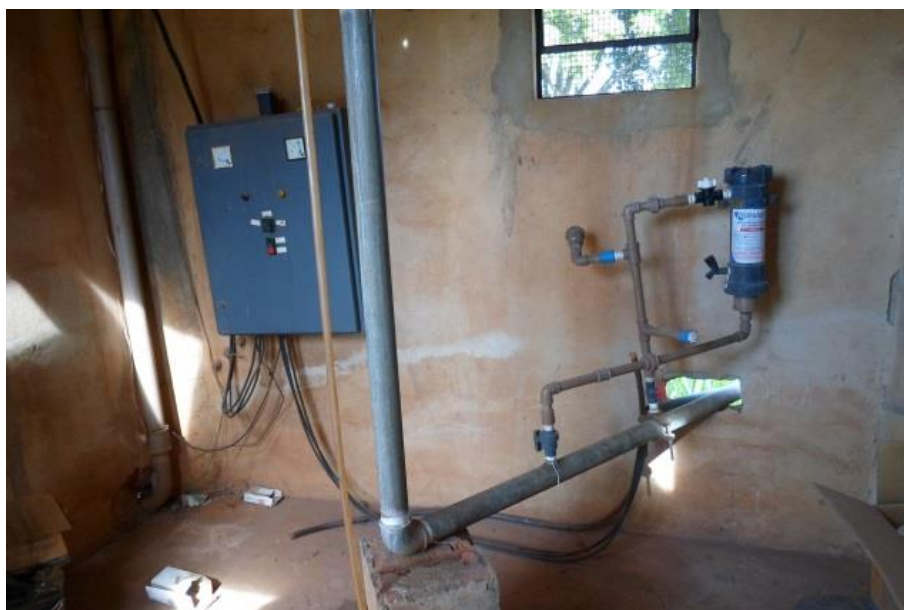
Figura 22 - Sistema de Fluoretação e Cloração do Poço Distrito.
