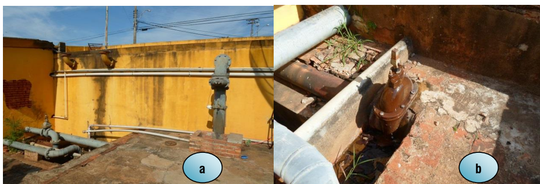
Figura 30 - Reservatório 1: a) vista frontal do reservatório; b) presença de vazamento na tubulação de entrada.
