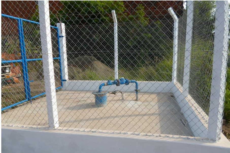
Figura 14 - Poço de Captação de 2 – Sistema Principal.
