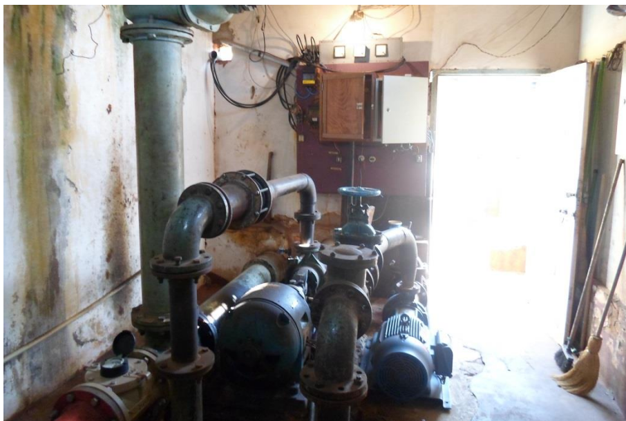
Figura 34 - Bombas de recalque do Reservatório 1 para a distribuição.
