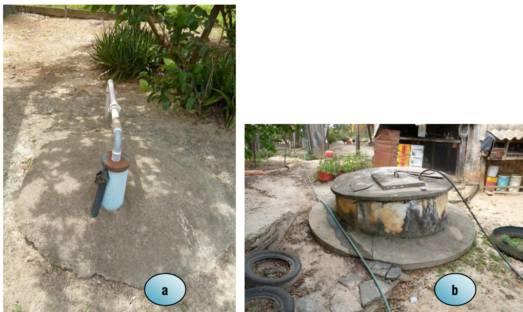
Figura 35 - Captação subterrânea para abastecimento de água na área rural do município de Rafard: a) poço tipo artesiano; b) poço tipo cacimba.
