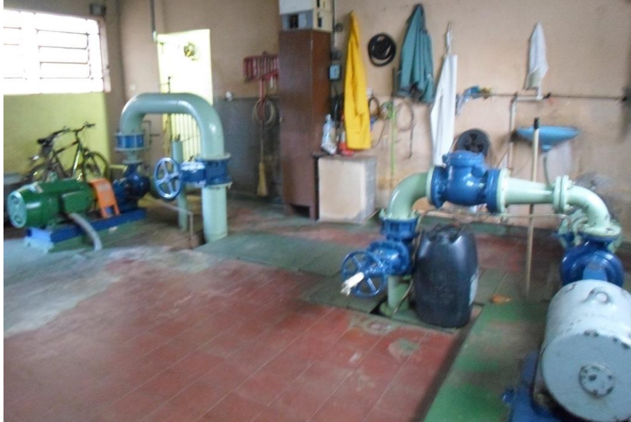
Figura 33 - Bombas de recalque do poço de sucção para a o Reservatório 1.
