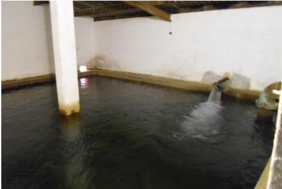
Figura 20 - Poço de sucção – com capacidade de 90m 3 .
