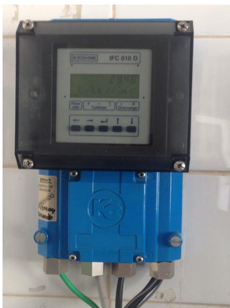
Figura 39 - Medidores de Vazão de Saída da ETA Kachel.
