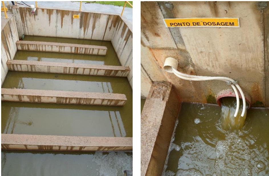
Figura 48 – Dosagem no Tanque de contato.
