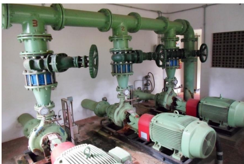
Figura 30- EEAT ETA: Conjunto moto bomba.
