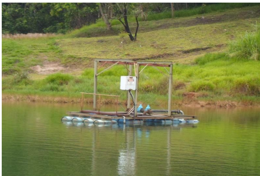
Figura 16 – Balsa de captação na represa do Atibainha.
