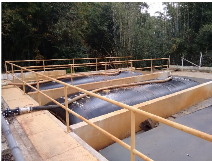
Figura 26 - Bags existentes na ETA do Município de Morungaba.
