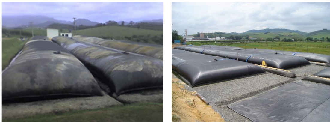
Figura 55 – Exemplos de Desidratação por secagem em bolsas de geossintéticos – Bags.
