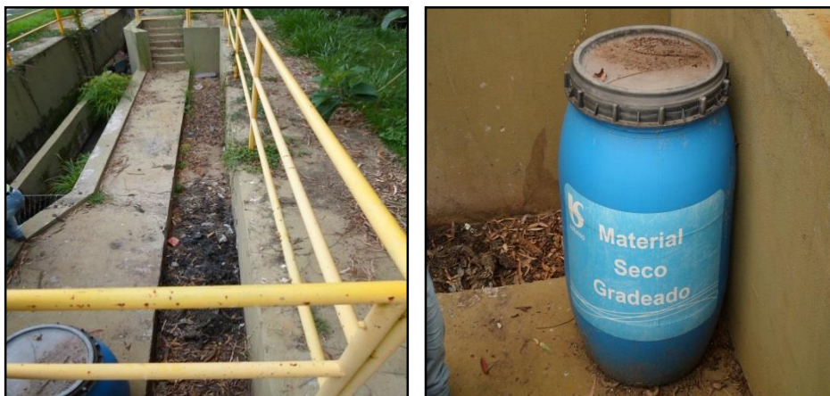
Figura 50 - Leito de secagem e bombona para acomodamento do material seco gradeado na ETE Morungaba.
