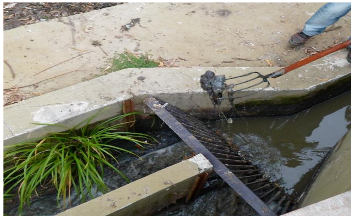
Figura 49 - Tratamento preliminar existente na ETE Morungaba.
