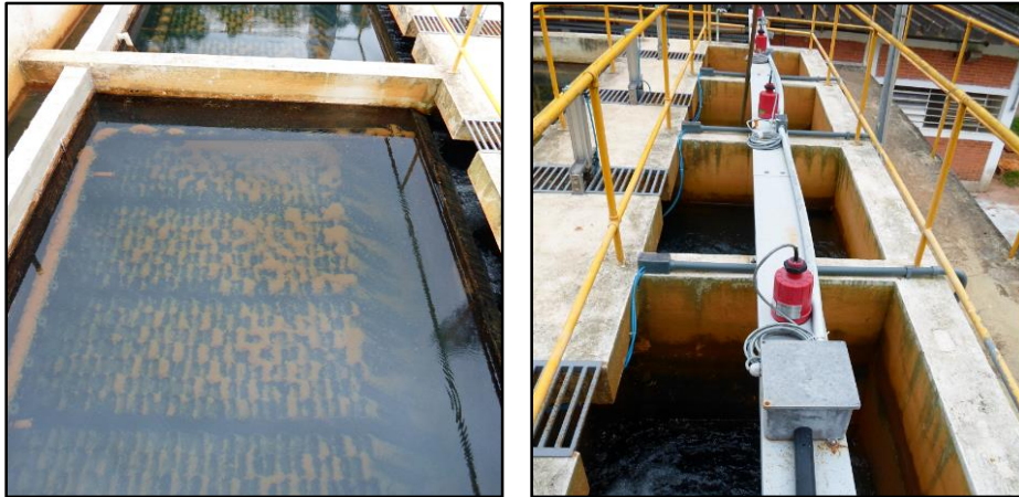
Figura 24 - ETA: Decantador e Filtros existentes na ETA do Município de Morungaba.
