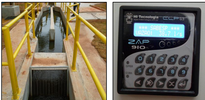
Figura 22 - ETA: Tratamento preliminar – Gradeamento e o Painel do Macromedidor de Entrada existentes na ETA do Município de Morungaba.
