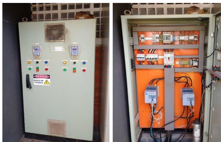
Figura 29 – Painel Elétrico Bomba G2 e G3 existente na ETA do Município de Morungaba.
