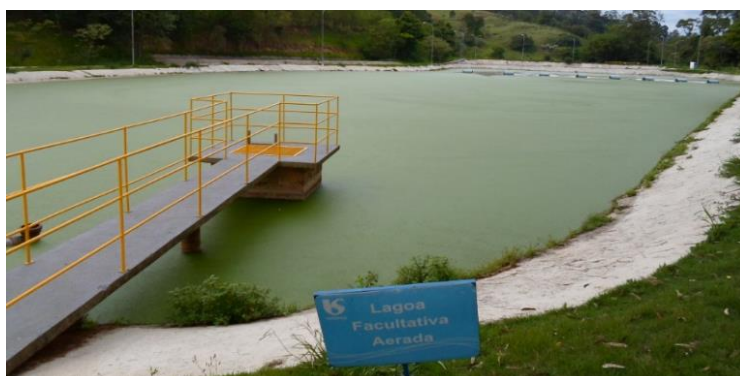
Figura 54 - Lagoa Facultativa Aerada existente na ETE Morungaba.
