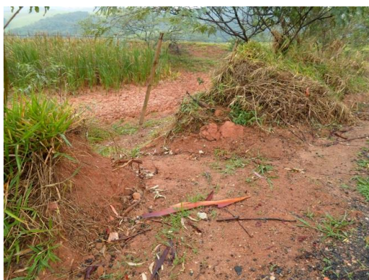
Figura 78 - “Ladrão” natural para escoamento lateral – Morungaba – Vias Rurais.
