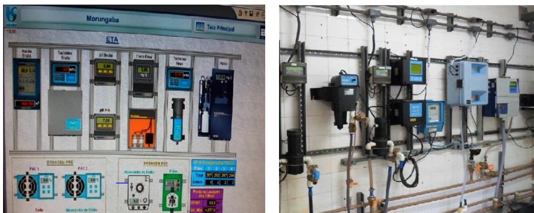
Figura 25 - Tela do Computador mostrando os resultados obtidos pelo sistema de automação e a Parede do laboratório com os aparelhos existentes na ETA do Município de Morungaba.
