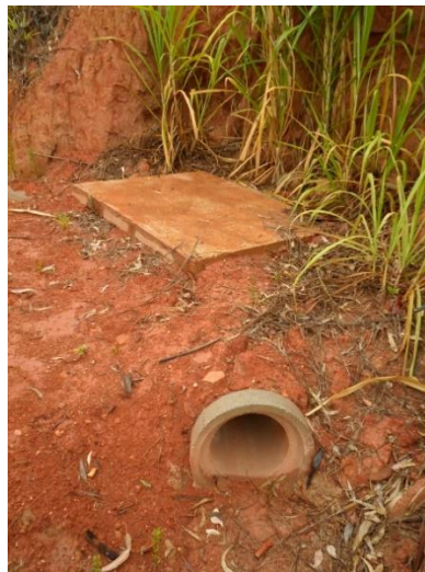
Figura 81 - Caixa de Contenção no Município de Morungaba.
