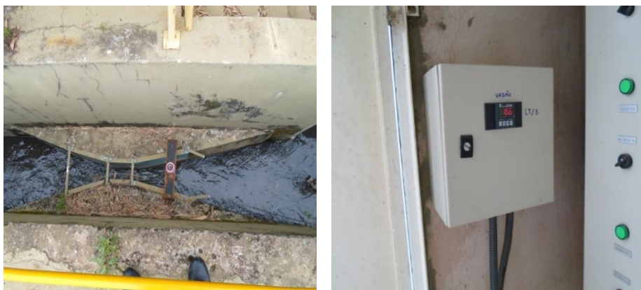
Figura 51 - Medidor de vazão Calha Parshall e o painel com o display existentes na ETE Morungaba.
