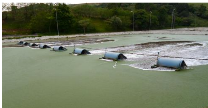
Figura 53 - Lagoa Facultativa Aerada – Aeradores Existentes na ETE Morungaba.
