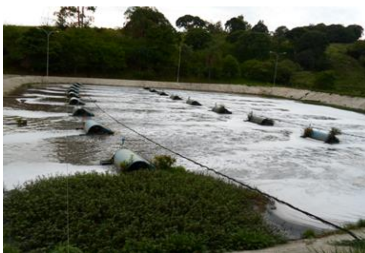
Figura 52 - Lagoa Aerada - ETE Ribeirão da Barra Mansa.
