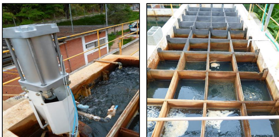
Figura 22 - ETA: Tratamento preliminar – Gradeamento e o Painel do Macromedidor de Entrada existentes na ETA do Município de Morungaba.
