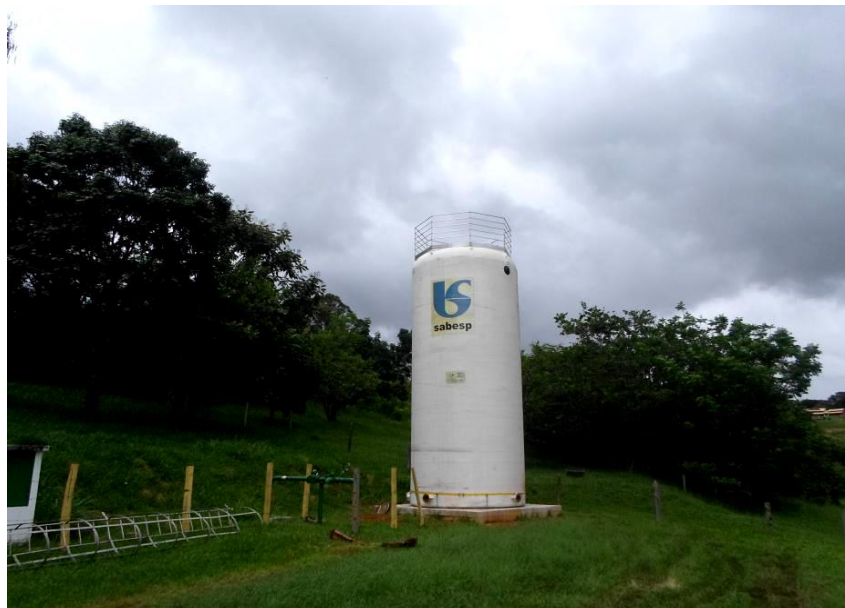
Figura 22 – Reservatório – Sistema Isolado, 100m 3 .
