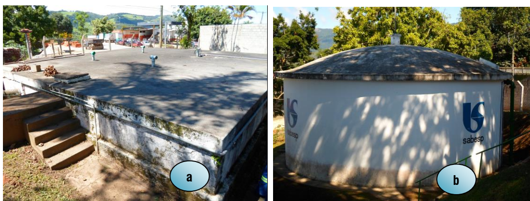
Figura 20 – Reservatórios: a) R1 semi enterrado 110m 3 ; b) R2 apoiado 300m 3 .
