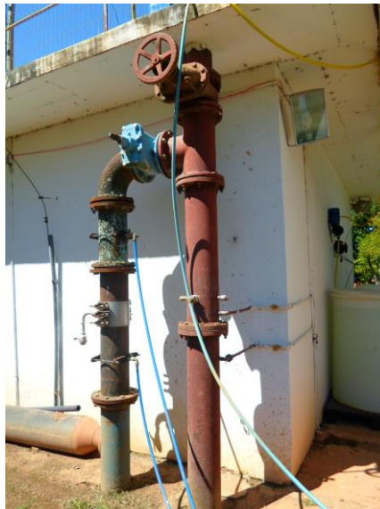
Figura 18 - ETA Compacta Torrezan: adutora de água bruta, chegada da água no processo de floculação.
