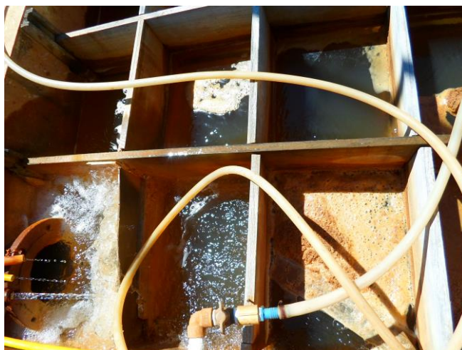
Figura 19 – ETA Compacta Torrezan: processo de adição barrilha (alcalinizante) e sulfato de alumínio (coagulante) na etapa de floculação.
