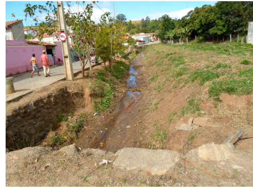
A Rua Lair Tuci (imagem acima), em períodos de alto índice pluviométrico sofre com a ocorrência de alagamentos no setor.
