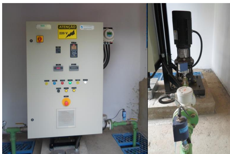
Figura 23 – Quadro de comando e bomba do booster Santo Amaro.
