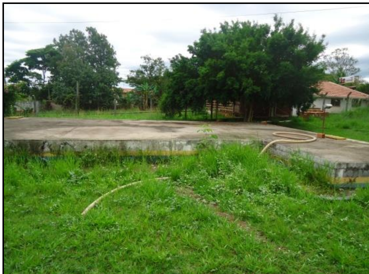
Figura 36 - Reservatório Enterrado ETA Ana Helena (200 m³).
