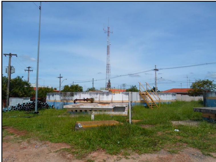
Figura 26 - Reservatório Semi-enterrado R4 - ETA Central.
