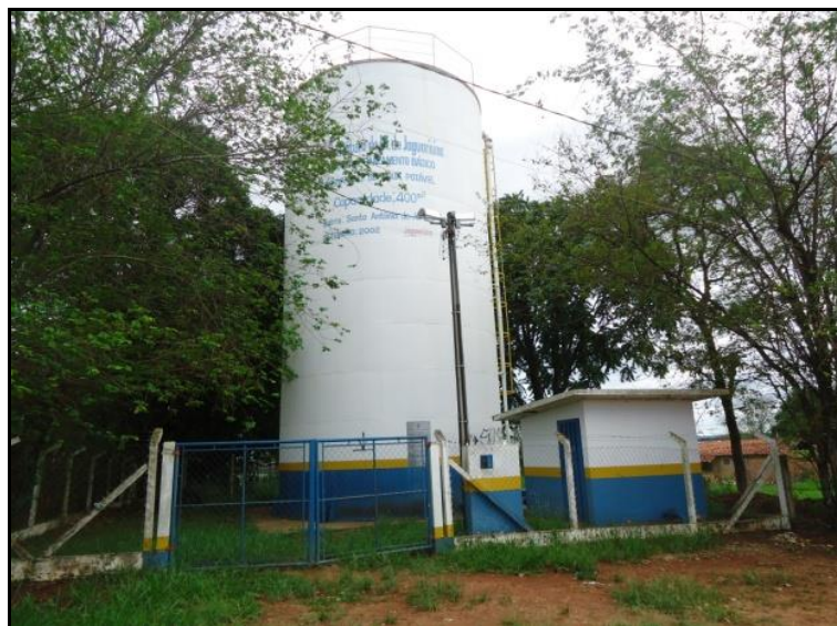
Figura 38 - Reservatório Santo Antônio do Jardim (400 m³).
