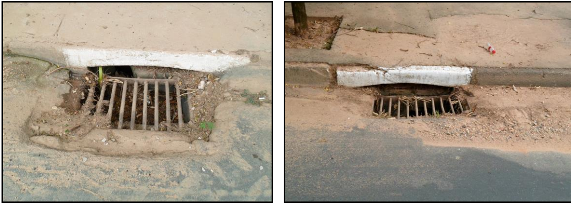
Figura 72 – Estrutura de microdrenagem (bocas de lobo) de Jaguariúna, com acúmulo de detritos nas guias e sarjetas.
