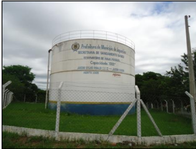
Figura 31 - Reservatório Sylvio Rinaldi (1.000 m 3 ).
