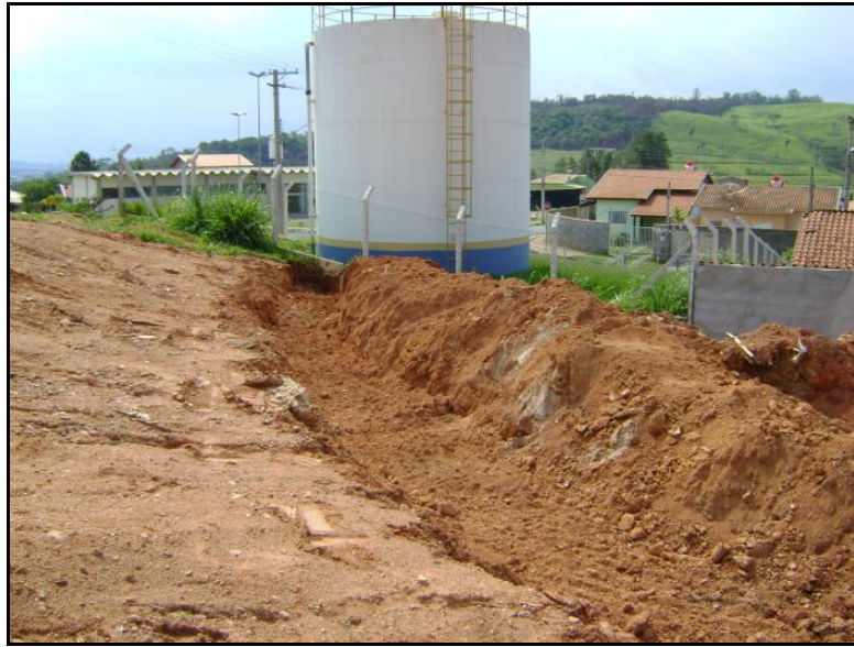
Figura 35 - Reservatório Elevado Pinheiros (200 m³).
