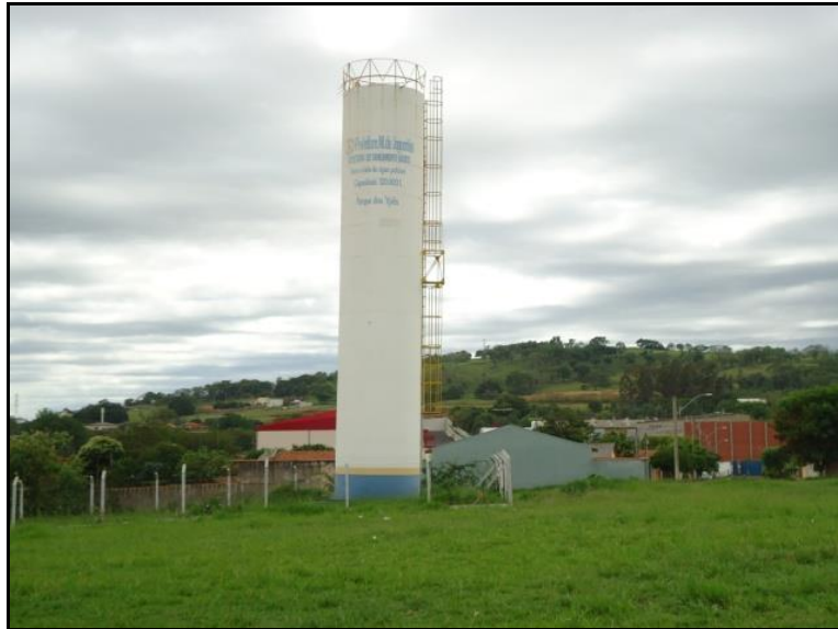
Figura 33 - Reservatório Parque dos Ipês (120 m³).
