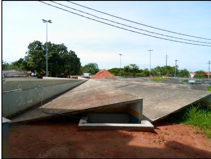
Figura 23 - Reservatório Semi-enterrado R1 - ETA Central.
