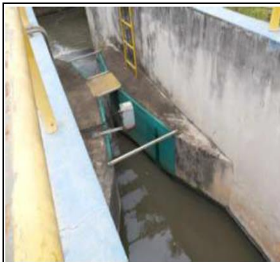
Figura 48 - Entrada do efluente com medidor Parshall e dispositivo ultrassônico.
