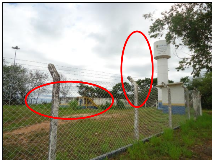
Figura 28 - Reservatórios Enterrado Florianópolis (1.000 m 3 ); Reservatório Elevado Florianópolis (30 m 3 ) - Terras do Capela.
