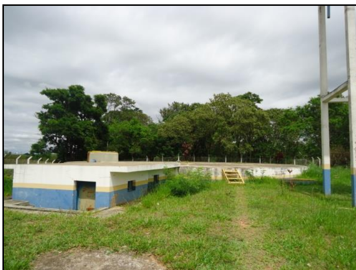
Figura 30 - Reservatório Nova Jaguariúna (600 m 3 ).
