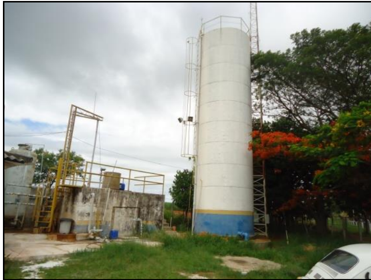
Figura 37 - Reservatório Elevado Ana Helena (100 m³).
