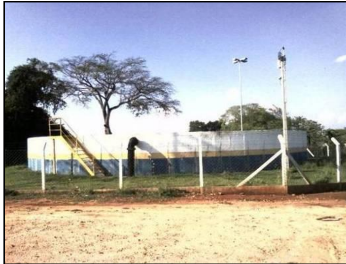
Figura 27 - Reservatório Capotuna (1.200 m 3 ).
