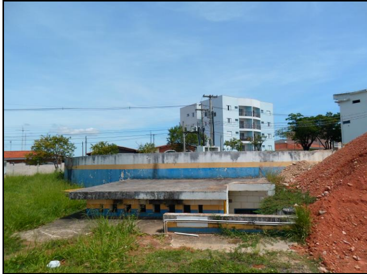
Figura 25 - Reservatório Semi-enterrado R3 - ETA Central.
