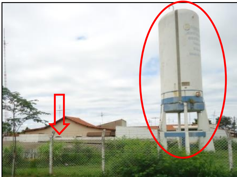
Figura 34 – Reservatório Enterrado Nassif (1.200 m³); Reservatório Elevado Nassif – 100m³ (Nassif e Chácaras Primavera).
