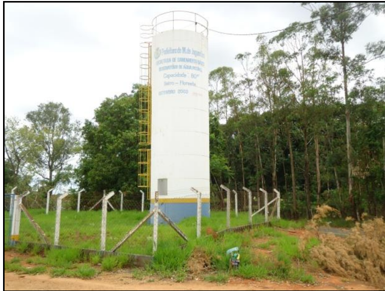
Figura 39 - Reservatório Floresta (80 m³).
