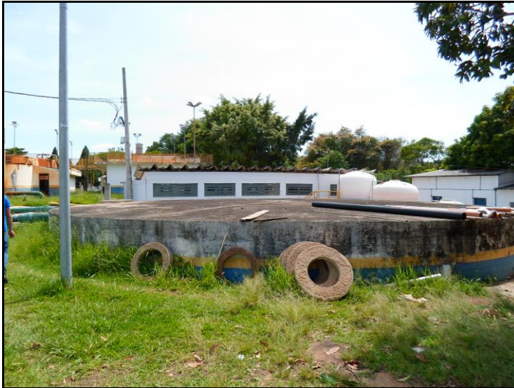
Figura 24 - Reservatório Semi-enterrado R2 - ETA Central.
