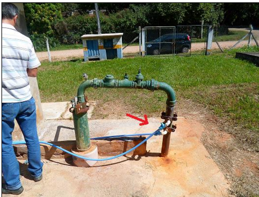
Figura 22 - Dosagem de produtos químicos do Sistema Poço Santo Antônio.
