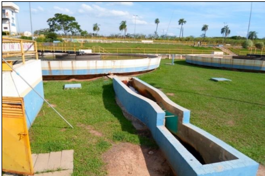
Figura 52 - Detalhe da Calha Parshall na Saída dos decantadores.
