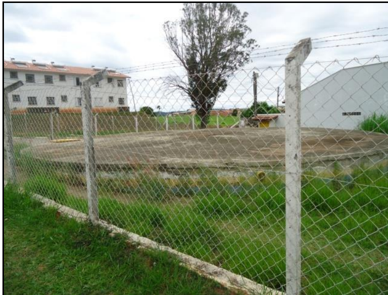
Figura 32 - Reservatório Cruzeiro do Sul (600 m 3 ).
