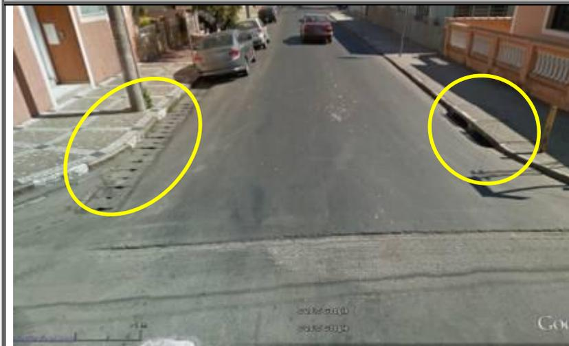
**Figura 155 - Vista à direita da imagem, uma Boca de lobo sem grelha e à esquerda**
