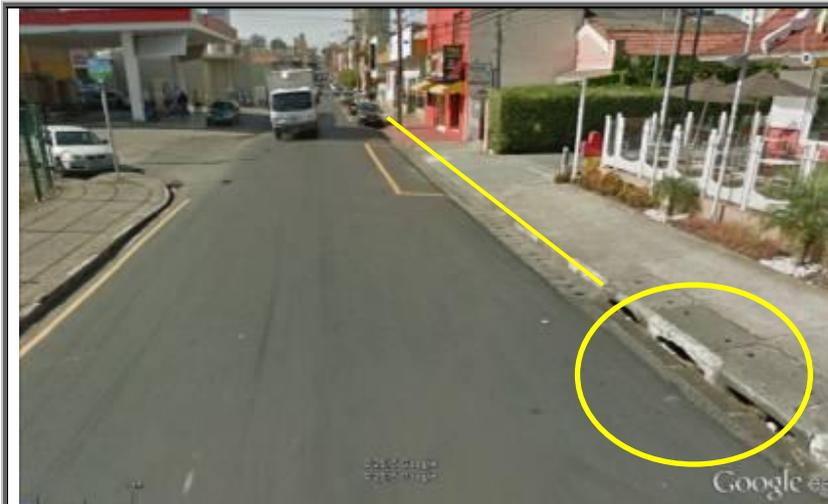
**Figura 154 - Nota-se a existência de Boca de lobo tripla sem grelha**
