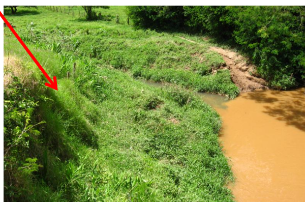
Figura 63 - Entroncamento do Córrego Divinéia, com o Rio Camanducaia, 90° causando remanso à montante e consequentemente o alagamento
