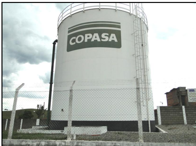
Figura 42 - Reservatório Central – 500 m 3
