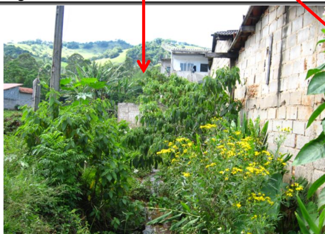
Figura 54 - Ocupação das margens do córrego e também da área de inundação
