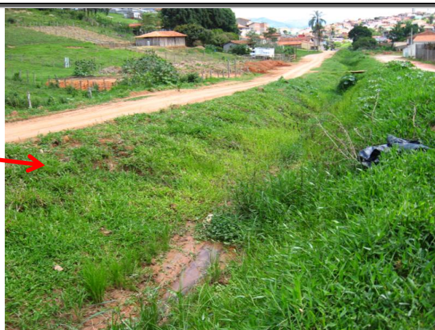
Figura 53 - Vista do Canal do Córrego Divinéia, com revestimento natural do terreno
