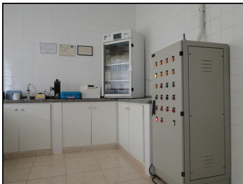
Figura 41 - Laboratório de Controle de Qualidade da ETA
