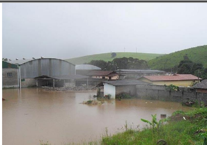
Figura 70 - Alagamentos da área de Várzea do Rio Camanducaia (Foto: Portal Terra, 2011)
