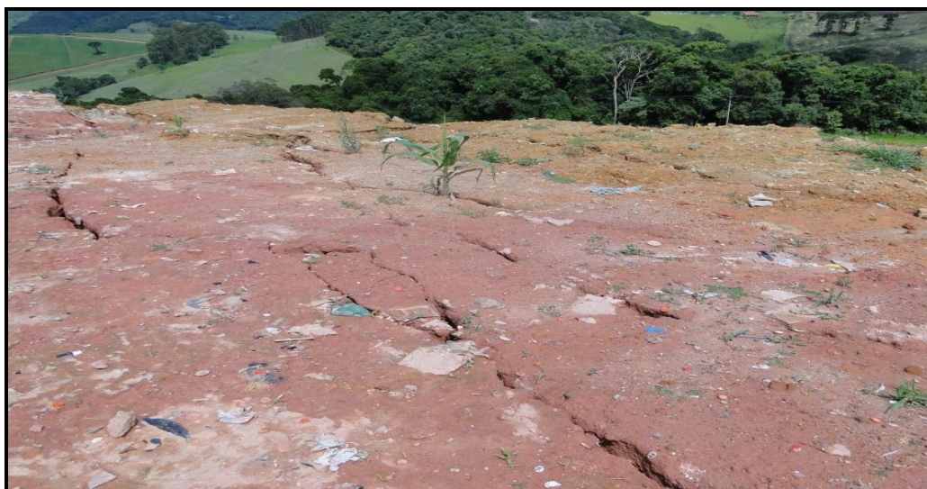
Figura 47 - Rachaduras na ultima celula do aterro evidenciando futuro desmoronamento
