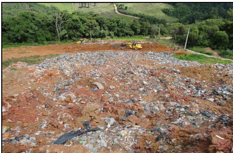
Figura 46 - Máquinas criando uma barreira para conter o eminente deslizamento do talude
