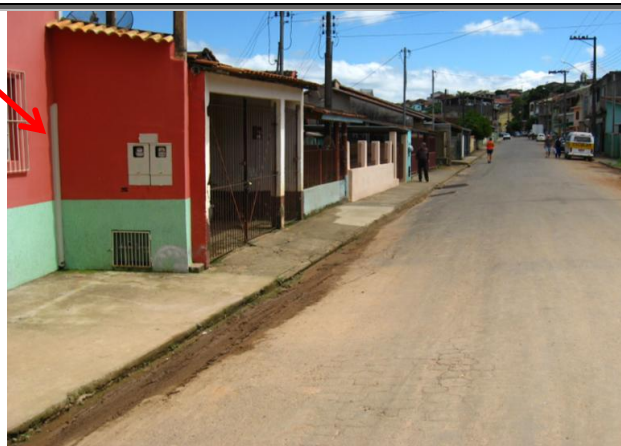
Figura 55 - Vista da Rua Assis Monteiro, onde há histórico de alagamentos da via
