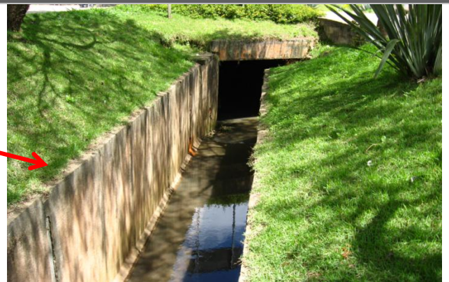
Figura 57 - Vista da canalização do Córrego Divinéia e aduela da travessia sob a Rodovia Fernão Dias
