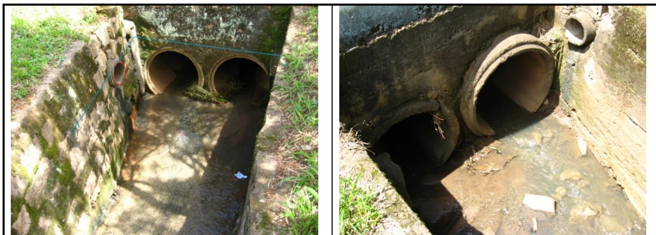
Figura 80 - Córrego Canalizado em seção aberta com rede de microdrenagem
