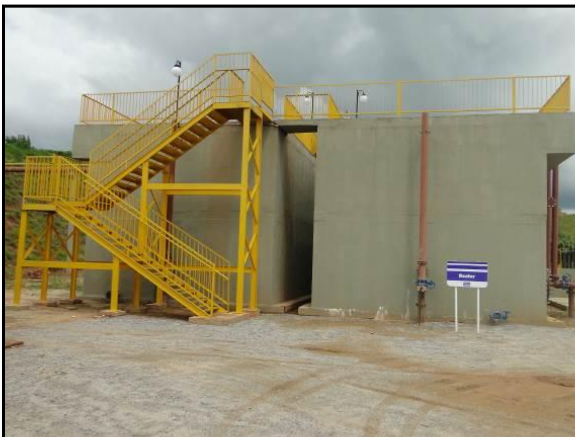
Figura 62 - Reator anaeróbio
