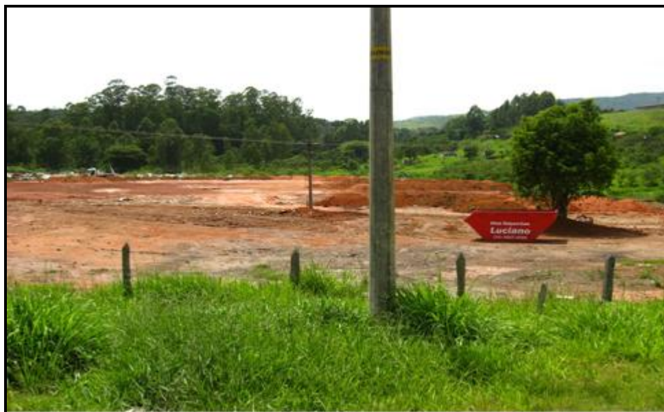
Figura 77 - Área de recebimento de resíduos de construção civil
