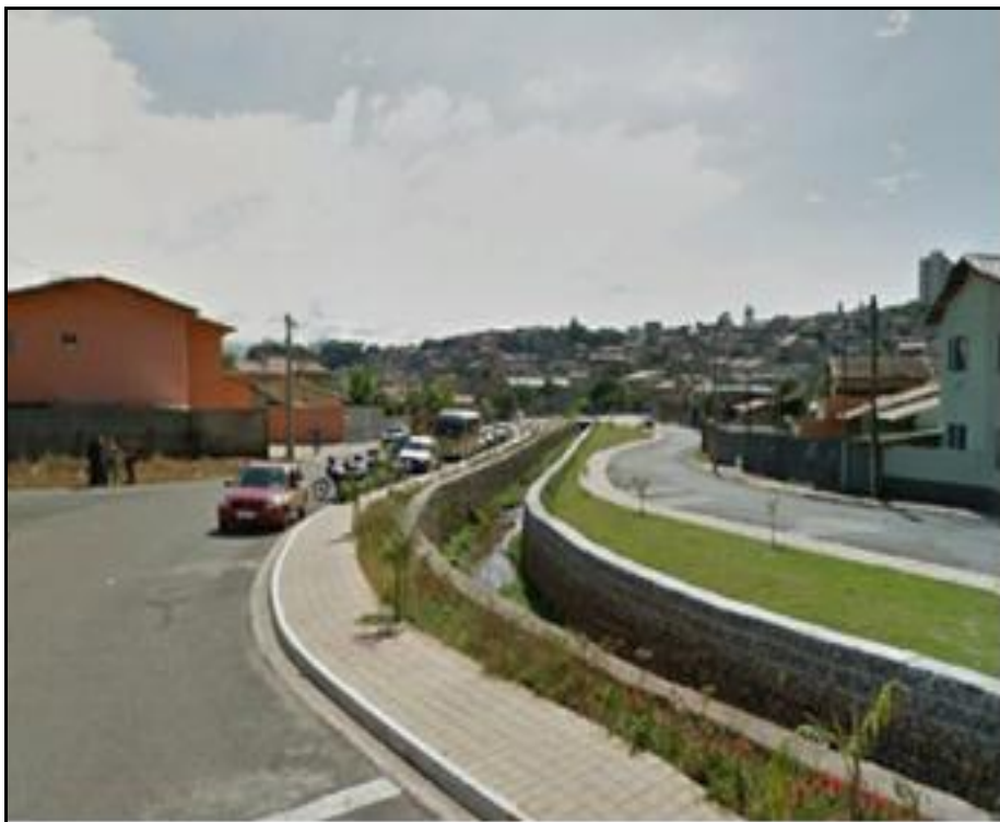
Figura 81 - Vista da Canalização do Córrego localizado na Avenida Alcebíades Gilli.
