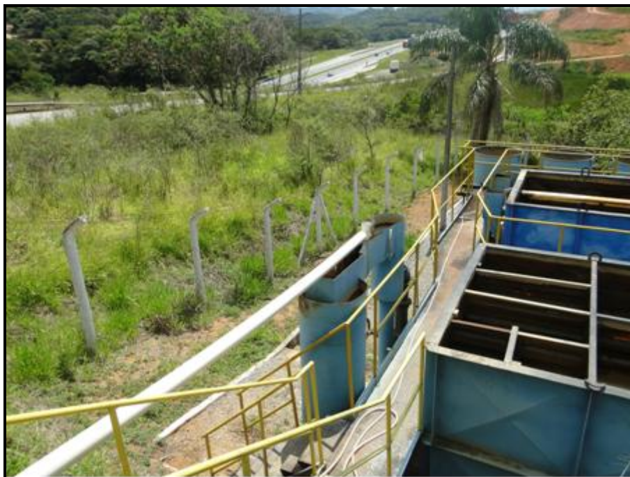
Figura 49 - Chegada da água bruta na ETA CDI
