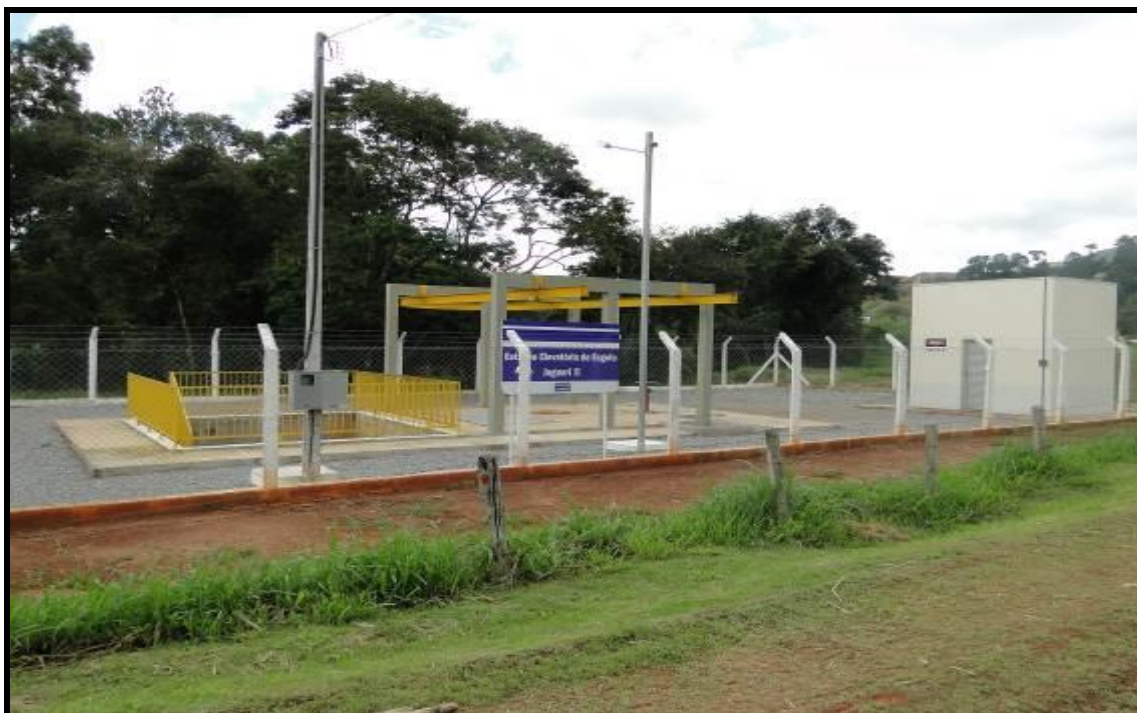
Figura 59 - Estação Elevatória de Esgotos II
