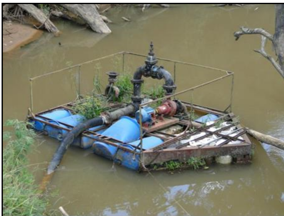
Figura 48 - Balsa Flutuante Sistema CDI
