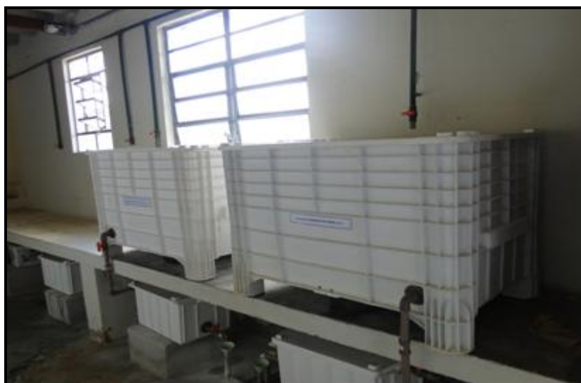
Figura 53 - Sistema de preparação e dosagem de produtos químicos ETA CDI
