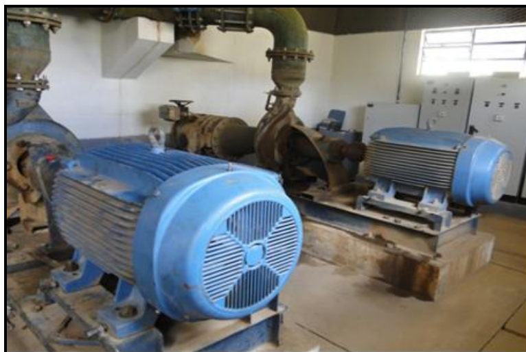
Figura 36 - Estação Elevatória Sistema Jaguari
