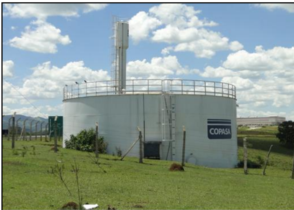
Figura 55 - Principal sistema de reservação – Reservatório Três Poderes – 1.000 m 3
