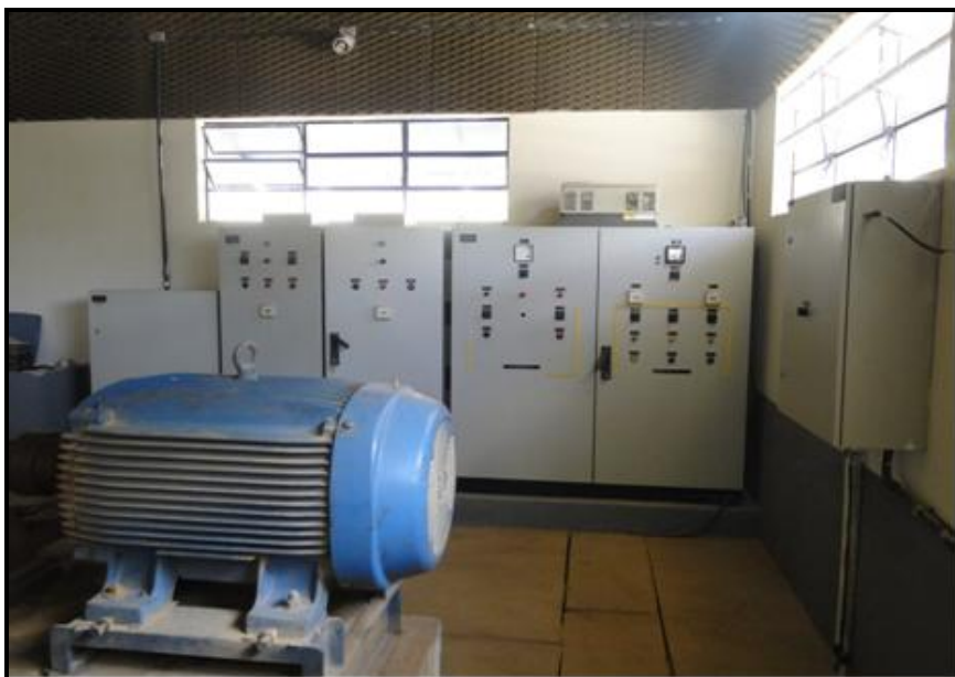
Figura 37 - Painéis Elétricos da Elevatória do Sistema Jaguari
