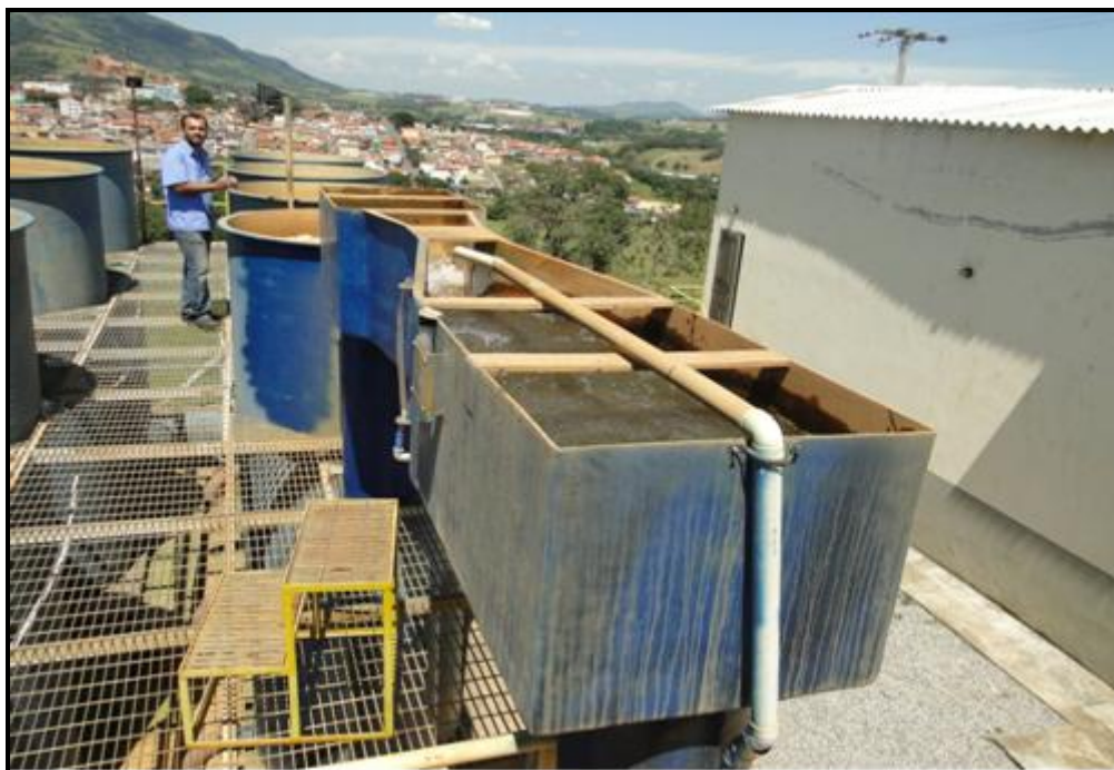
Figura 38 - Mistura Rápida - Calha Parshall na chegada da ETA Jaguari e Floculadores
