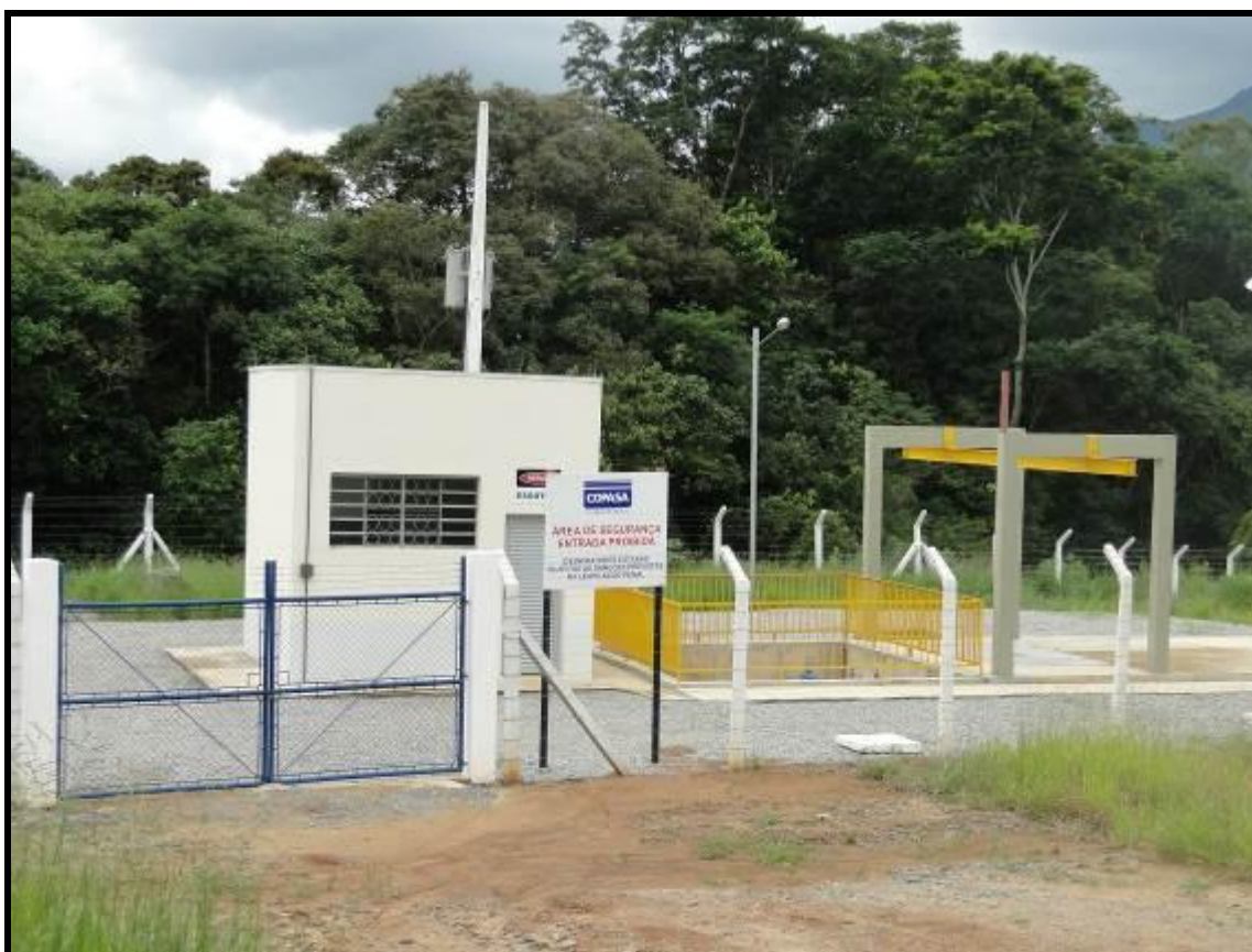
Figura 60 - Estação Elevatória de Esgotos III
