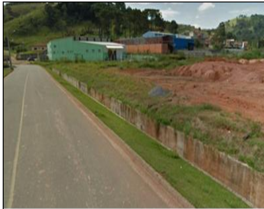
Figura 84 - Vista de outro ponto da canalização existente do Córrego localizado na Avenida Vereador José Ferreira.
