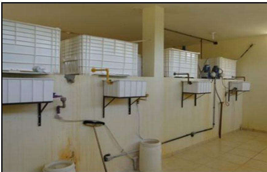
Figura 44 - Sala de dosagem de produtos químicos da ETA Jaguari
