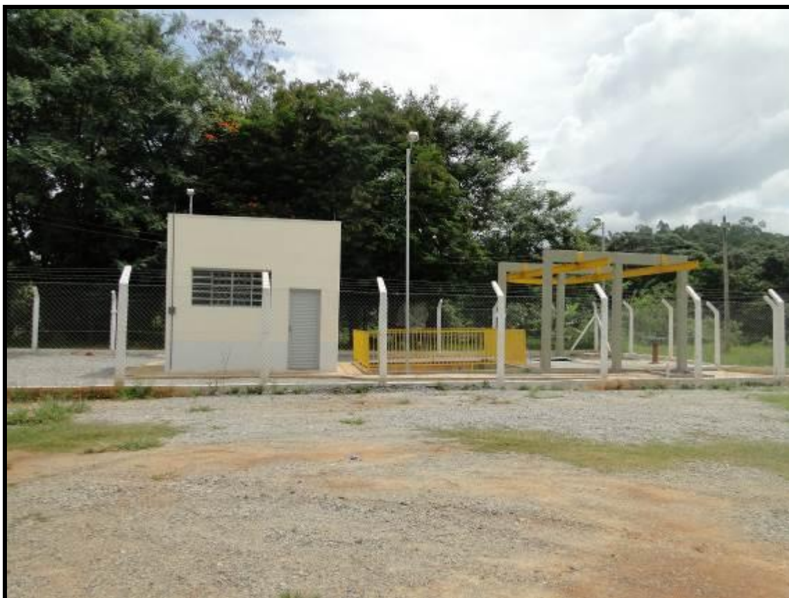
Figura 58 - Estação Elevatória de Esgotos I
