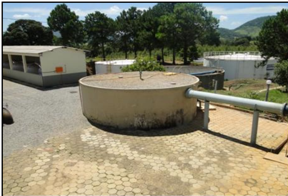
Figura 41 - Tanque de contato
