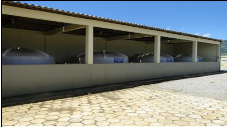
Figura 42 - Armazenamento de Produtos Químicos
