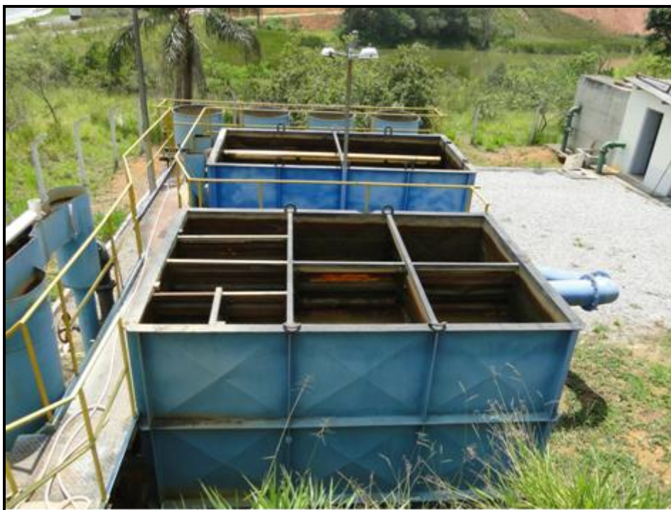
Figura 50 - Floculador e decantador da ETA CDI
