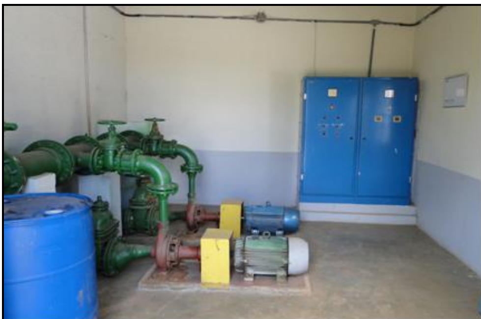
Figura 52 - Elevatória de água tratada da ETA CDI
