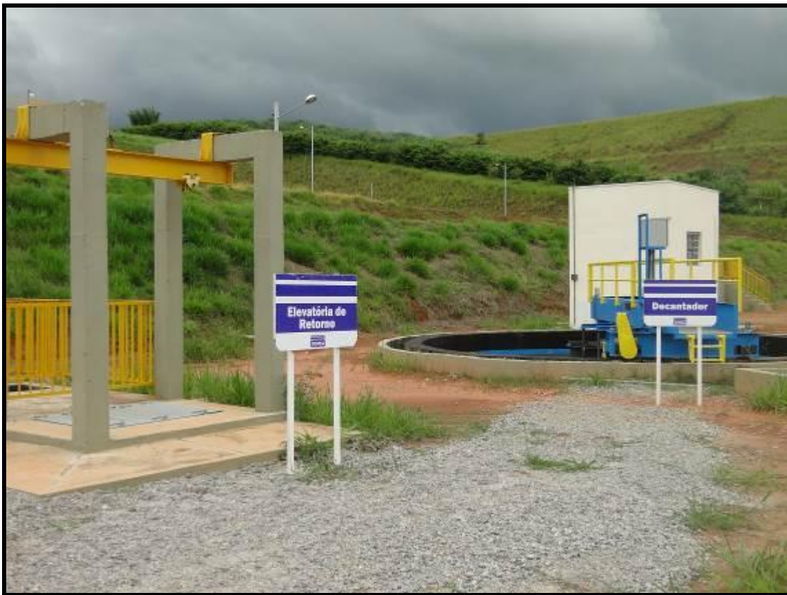
Figura 65 - Decantador e Elevatória de retorno
