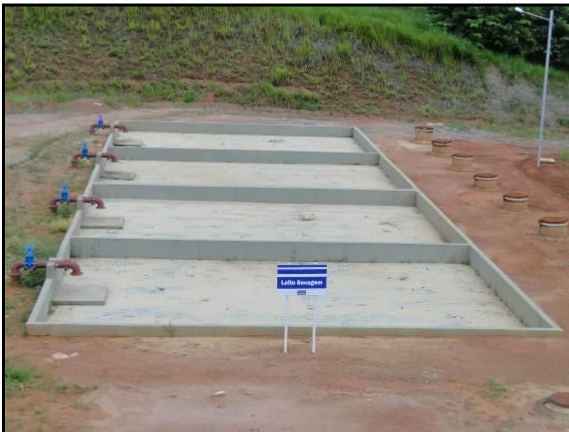
Figura 63 - Leitões de secagem
