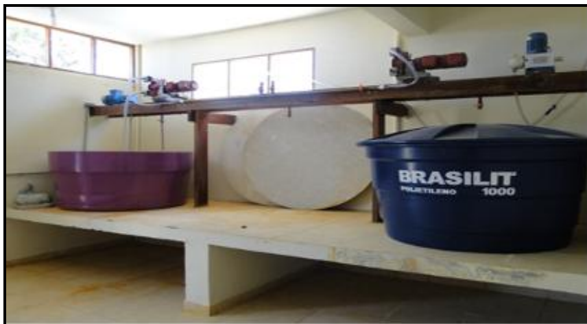
Figura 43 - Sala de preparação de soluções da ETA Jaguari
