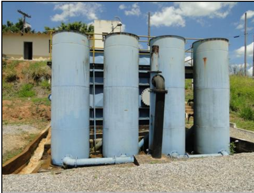
Figura 51 - Filtros da ETA CDI
