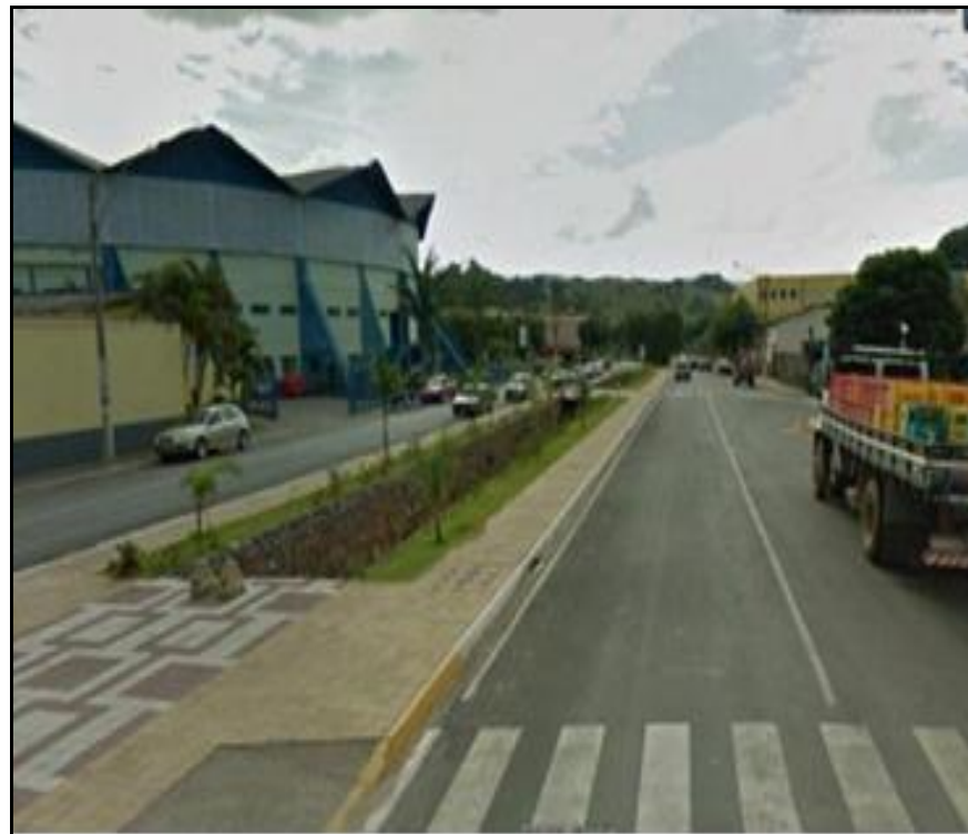
Figura 82 - Vista de outro ponto da canalização existente do Córrego localizado na Avenida Alcebíades Gilli
