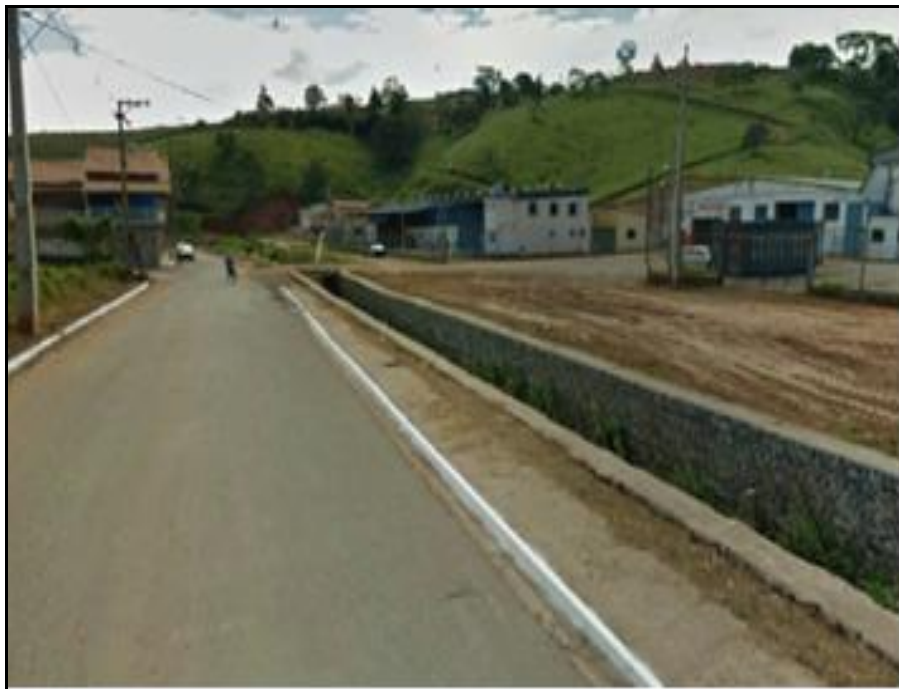
Figura 83 - Vista da Canalização do Córrego localizado na Avenida Vereador José Ferreira.
