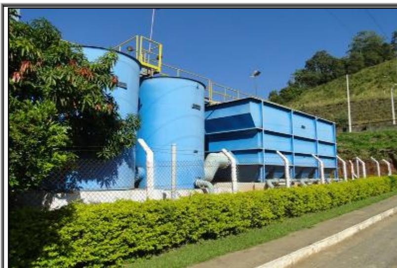
**Figura 41 - Floculadores e decantador da ETA**
