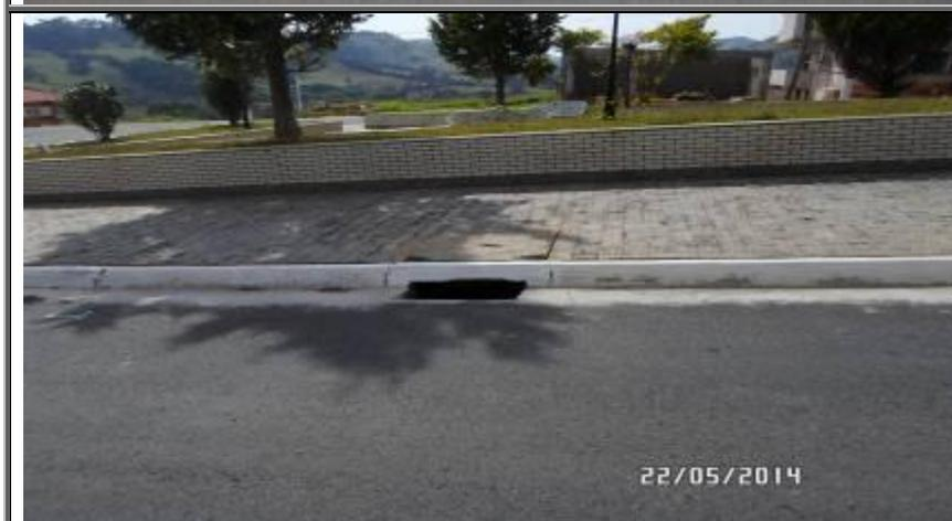
**Figura 110 - Vista de uma boca de lobo, porém sem grelha**
