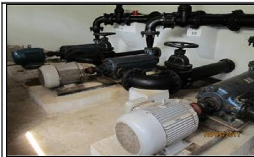
**Figura 64 - Recalque de água tratada da ETA R1**
