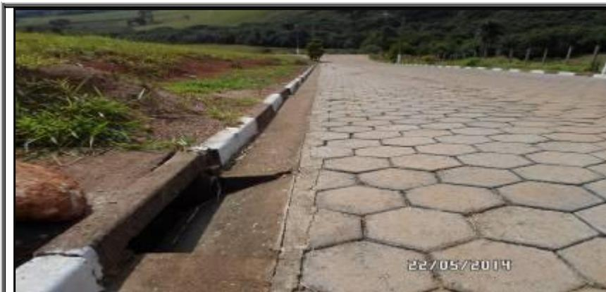
**Figura 112 - Pavimento de bloquete e dispositivos de micro drenagem**
