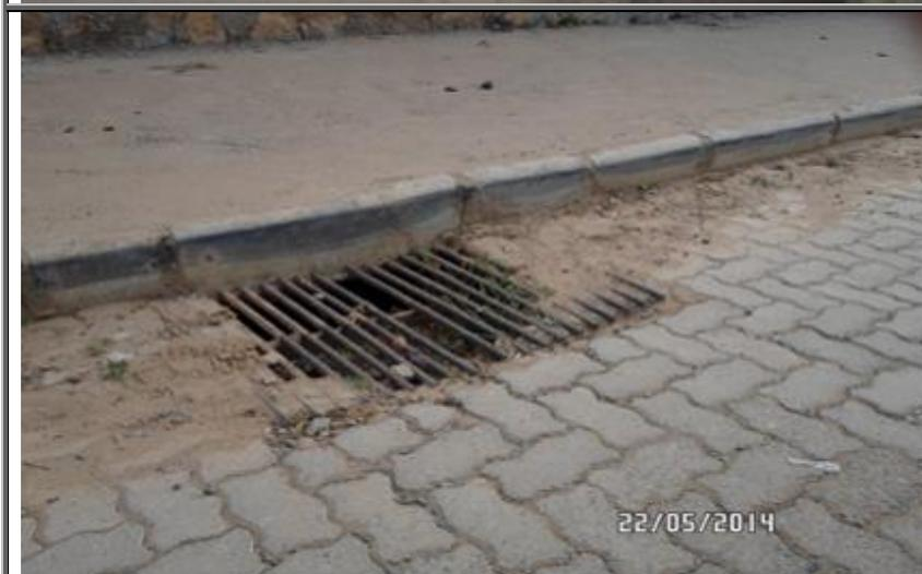
**Figura 126 - Vista de uma boca de lobo obstruída por sedimentos**
