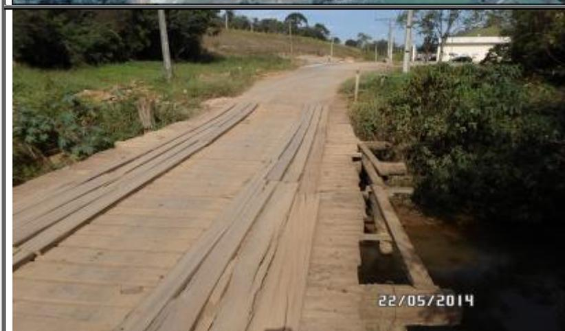
**Figura 90 - A Ponte sobre o Rio Camanducaia em condições precárias**
