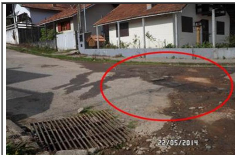
**Figura 128 - Vista do espraio das águas pluviais nas vias**
