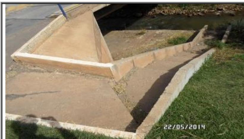
**Figura 88 - Vista de outro ângulo da escada hidráulica**
