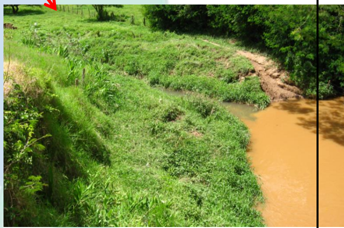
Figura 15 - - Entroncamento do Córrego Divinéia, com o Rio Camanducaia, 90° causando remanso à montante e consequentemente o alagamento. Trecho a ser retificado
