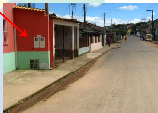
Figura 24 - Vista da Rua Assis Monteiro, onde há histórico de alagamentos da via.
