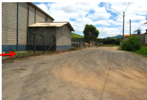
Figura 13 - Vista da Rua João Egídio, localizada no bairro Jardim Monte Alegre. Área sujeita a inundações, devido a proximidade com o Rio Camanducaia. Remoção de edificações em áreas de risco.
