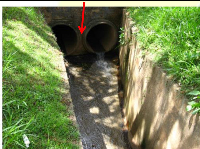
Figura 19 - Vista das aduelas . Ampliação da canalização e aduelas existentes;
