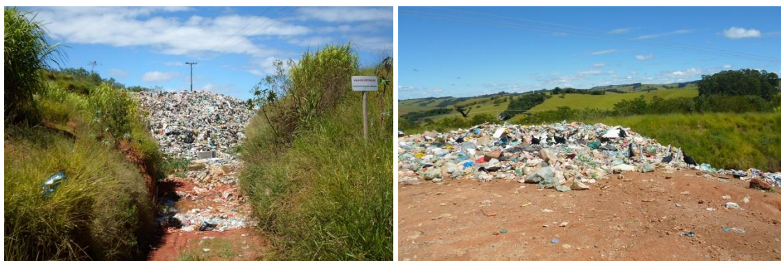
Figura 36 - Disposição dos resíduos na vala em operação.
