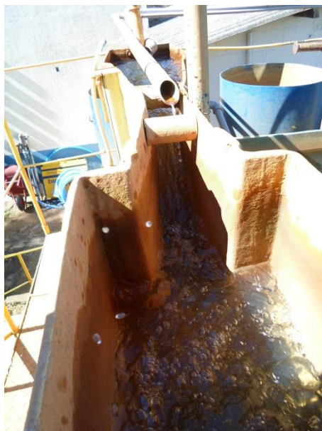
Figura 17 - Passagem na água bruta na calha Parshall .
