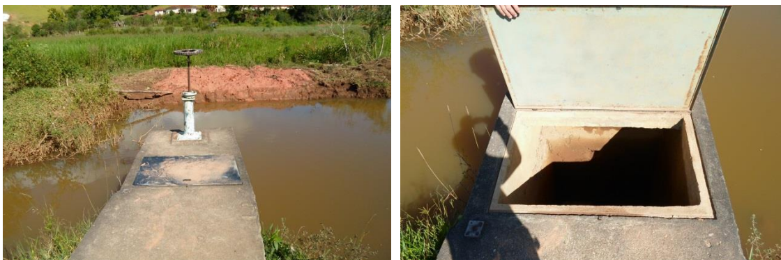
Figura 13 – Captação por pressurização no Córrego do Campestre.
