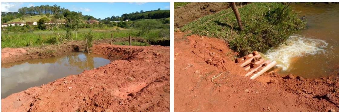
Figura 12 - Barragem de regularização de vazão no Córrego Campestre.
