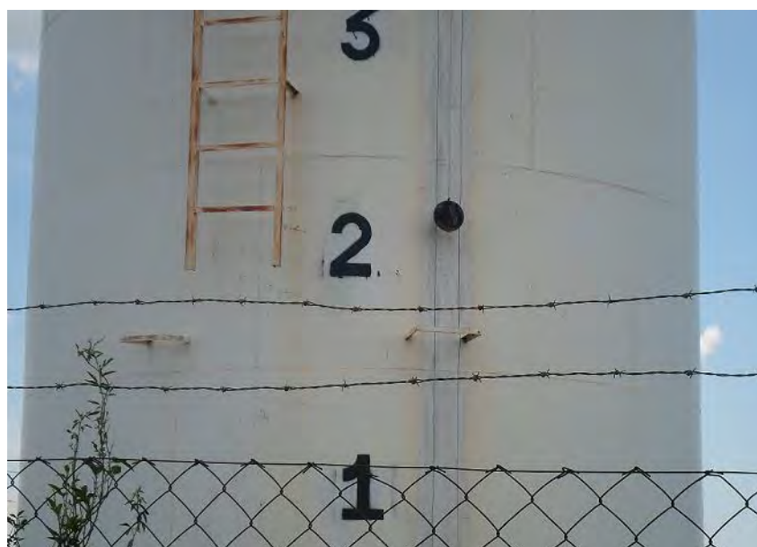
Figura 32 - Régua de medição de nível do reservatório.
