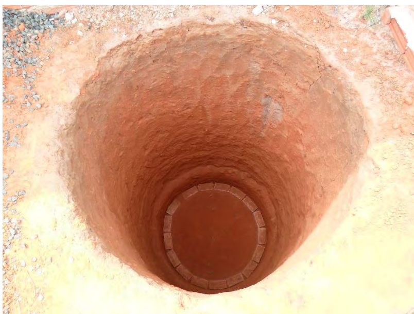
Figura 49 – Fossa em construção.
