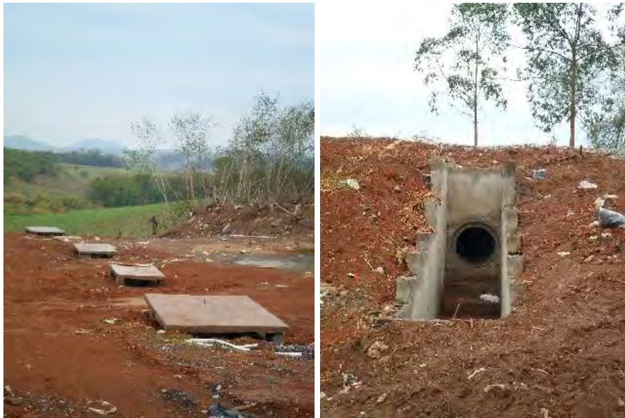
Figura 62 - Galerias para escoamento de águas pluviais.
