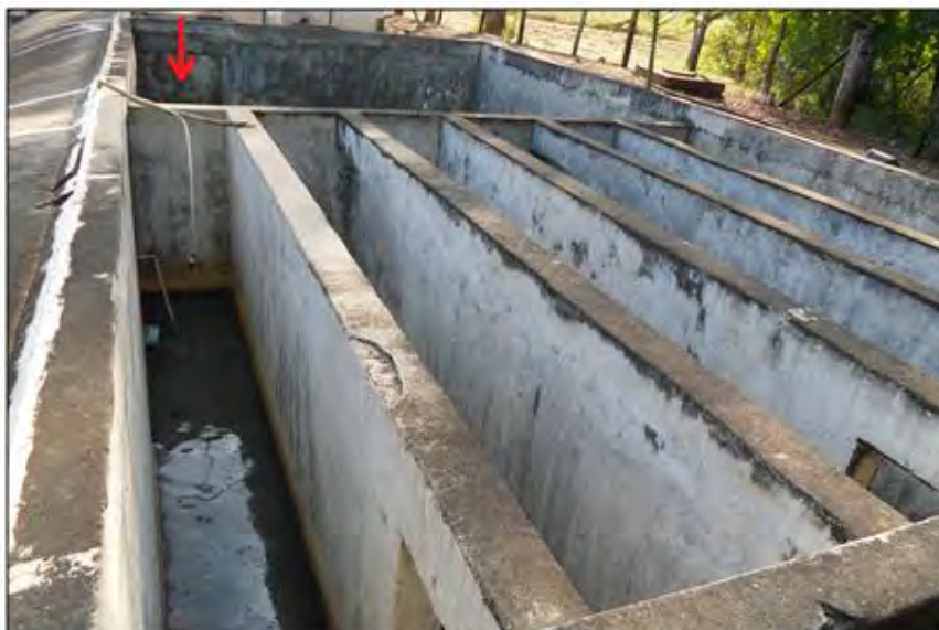
Figura 46 - Adição de cloro e tanque de contato.
