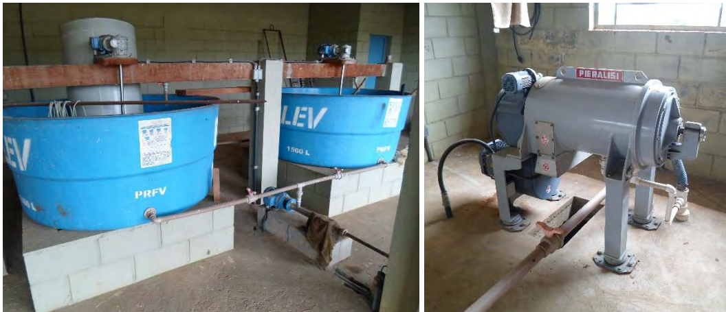
Figura 48 – Equipamento para dragagem do lodo da ETE.
