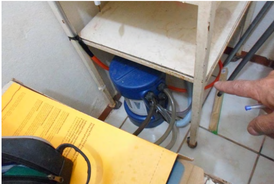
Figura 53 - Equipamento para tratamento de resíduo de radiografia.
