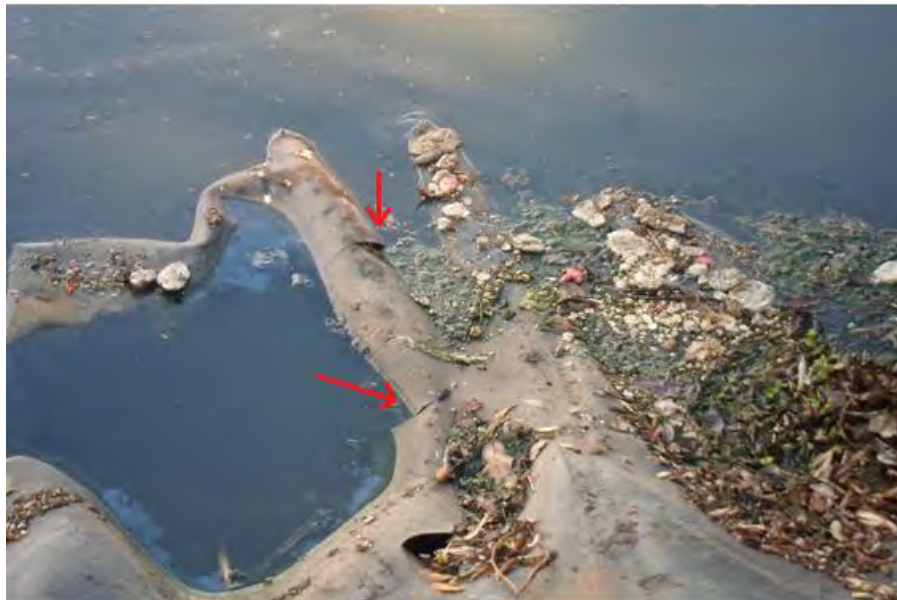
Figura 43 - Fissuras na manta de impermeabilização da lagoa de aeração.
