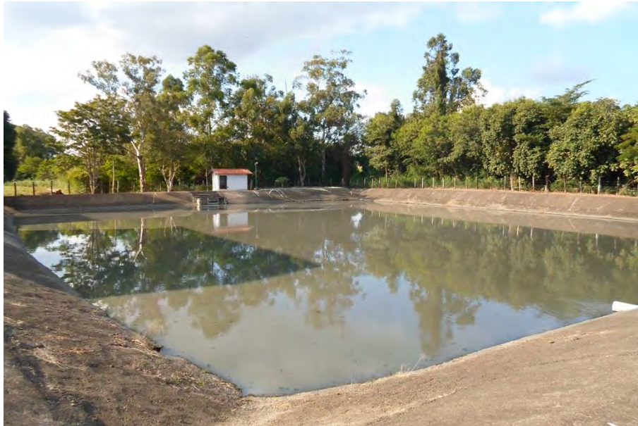
Figura 44 - Decantador da ETE.
