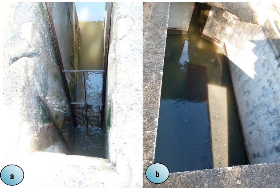
Figura 40 - (a) Gradeamento; (b) Caixa de areia.
