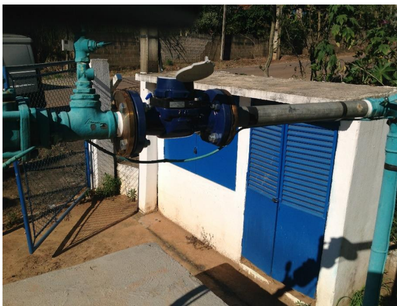
Figura 24 - Macromedidor do P32.
