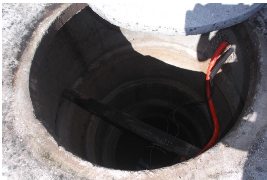
Figura 21 - Captação subterrânea para abastecimento de água na área rural do município de Pedra Bela.
