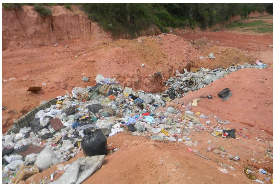
Figura 36 - Aterramento em Vala no Município de Pedra Bela.
