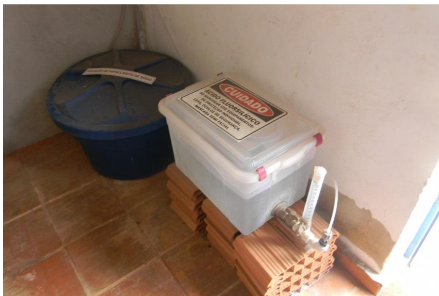
Figura 19 - Sistema de adição de ácido fluorsilícico.
