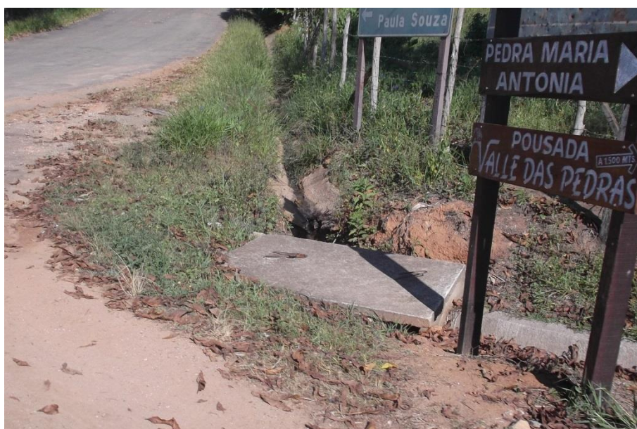
Figura 38 - Sistema de valeta para escoamento superficial de águas pluviais na área rural.
