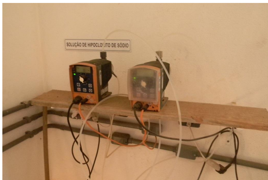
Figura 18 - Sistema de adição de hipoclorito de sódio.
