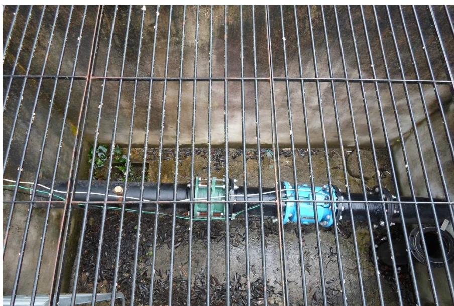
Figura 38 - Macromedidor de saída da ETA Kachel.
