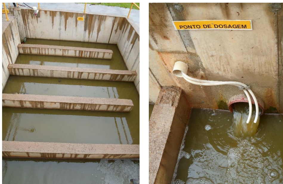
Figura 48 – Dosagem no Tanque de contato.
