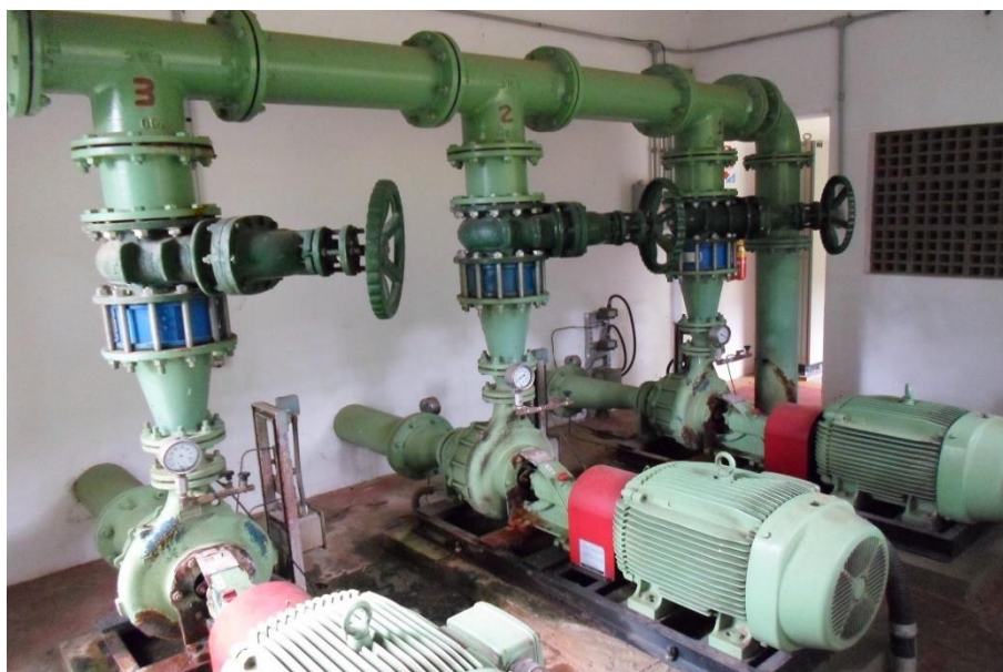
Figura 30- EEAT ETA: Conjunto moto bomba.
