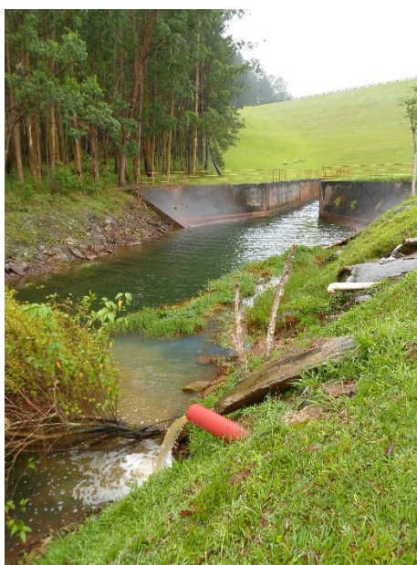
Figura 49 - Lançamento do Esgoto tratado na ETE no Rio Atibainha.
