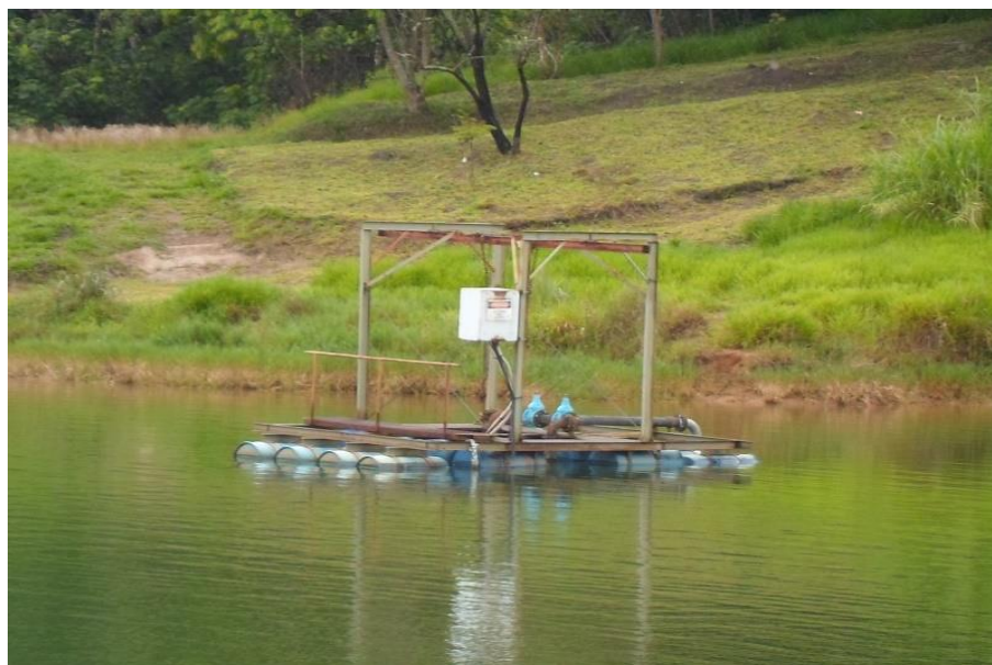
Figura 16 – Balsa de captação na represa do Atibainha.
