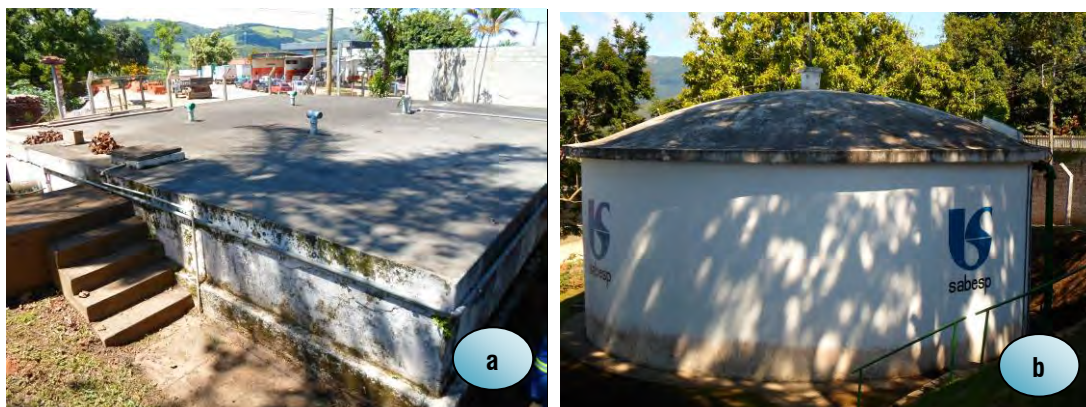
Figura 20 – Reservatórios: a) R1 semi enterrado 110m 3 ; b) R2 apoiado 300m 3 .
