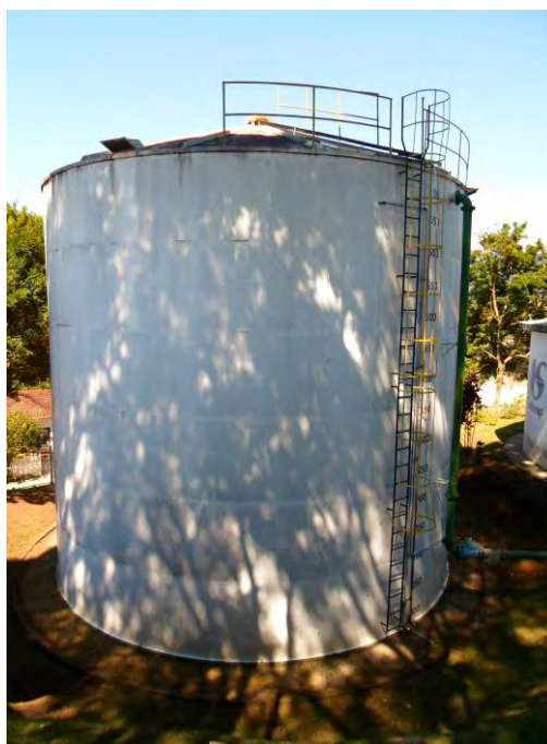
Figura 21 - Reservatório 3, apoiado 700 m 3 .
