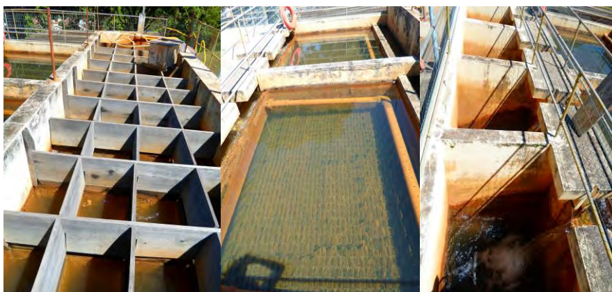
Figura 17 - ETA Compacta Torrezan: floculador, decantadores de fluxo ascendente e filtros de fluxo descendente.
