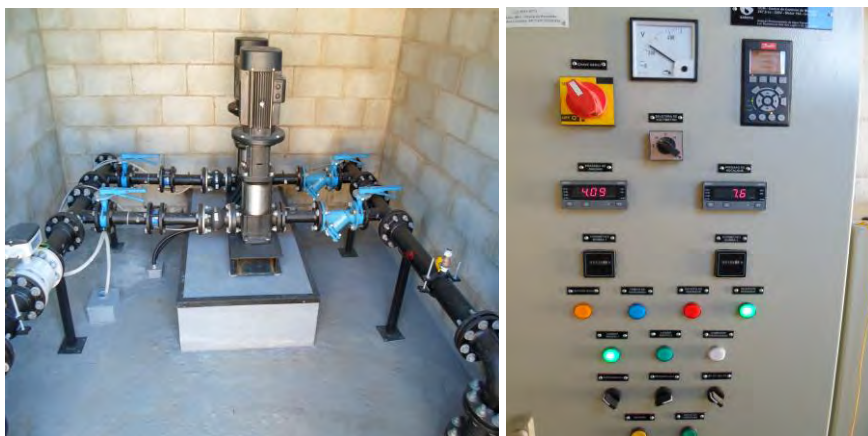
Figura 24 – Bomba do booster Santo Amaro e Quadro de comando Serra Azul.
