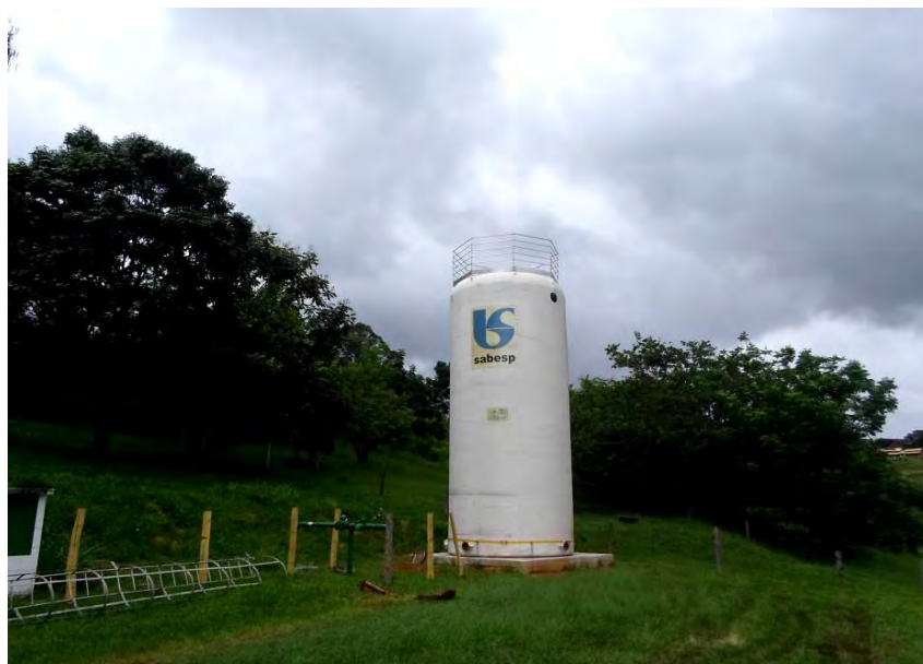
Figura 22 – Reservatório – Sistema Isolado, 100m 3 .
