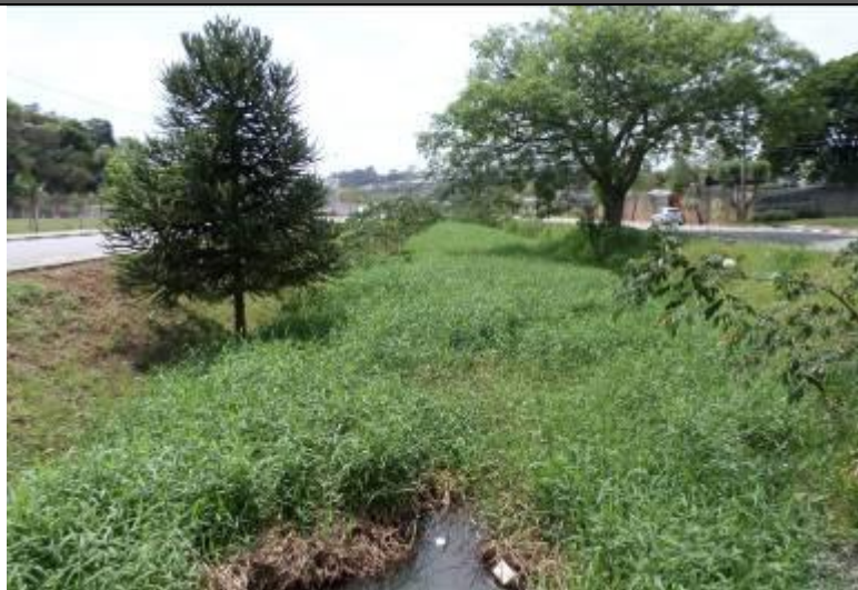
Figura 148 - Vista a jusante da lagoa. Trecho retificado, revestido com gabião.
