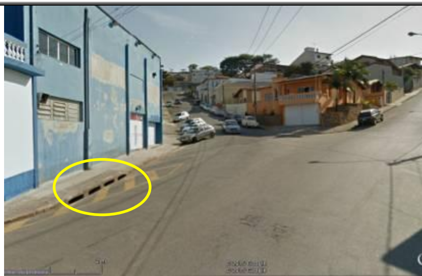
Figura 153 - Nota-se na imagem a existência de 4 bocas de lobo
