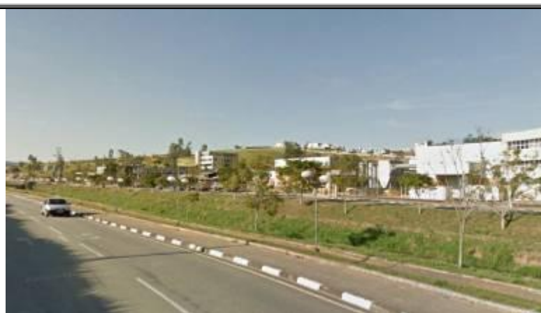
Figura 129 - Vista à jusante do Trecho T 12
