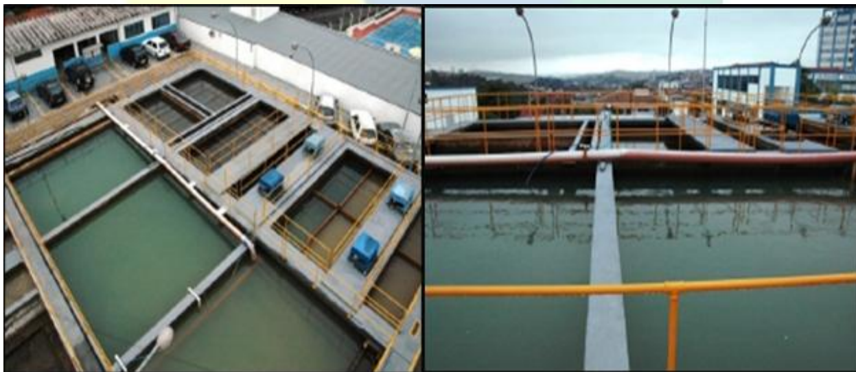
Figura 34 - Estação de Tratamento de Água – ETA
