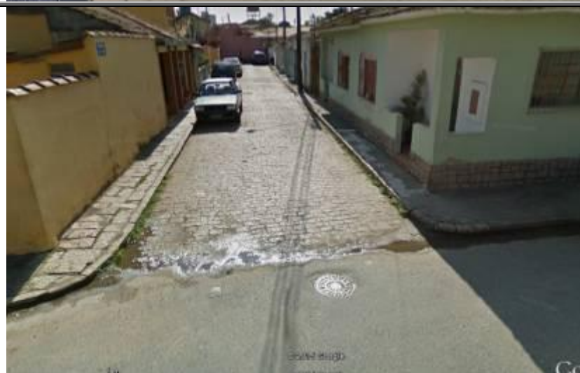
Figura 152 - Pavimento revestido com paralelepípedo
