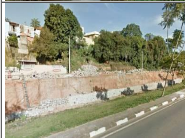
Figura 122 - Vista à jusante do Trecho T 11.
