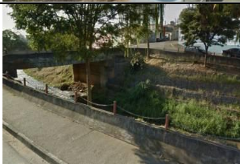
Figura 110 - T 05 – Condições da travessia sob a Rua Domingos Pretti.
