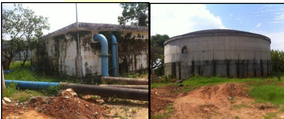
Figura 46 - Centro de reservação Santa Cruz – Reservatórios semi-enterrados
