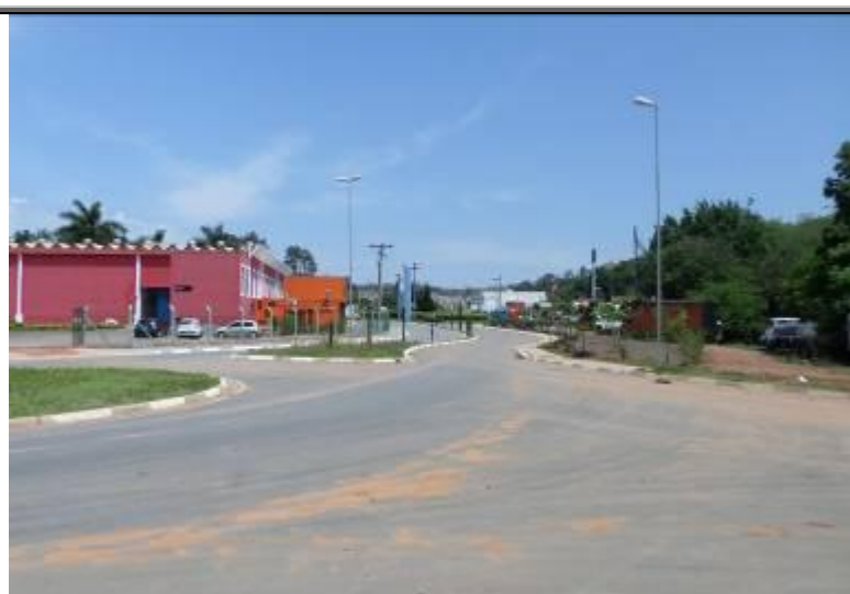
Figura 149 - Vista do trecho canalizado a montante da foz com aduelas de 4,00 x 2,00 metros.
