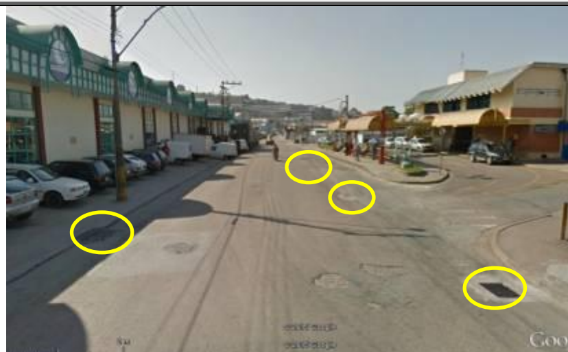
Figura 151 - Evidências de Bocas de Lobo com grelha em ponto baixo, localizadas na Rua Domingo Preti
