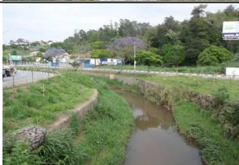
Figura 124 - Vista a Jusante da Travessia da Av. Nossa Senhora das Graças.
