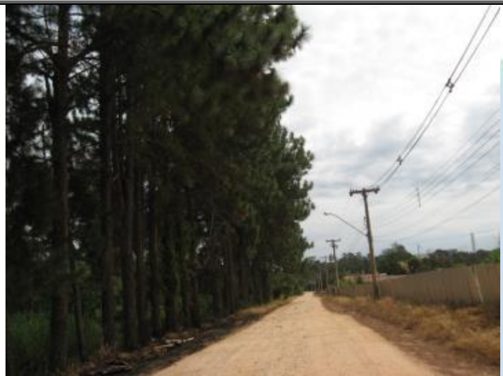
Figura 164 - Via sujeita a alagamentos
