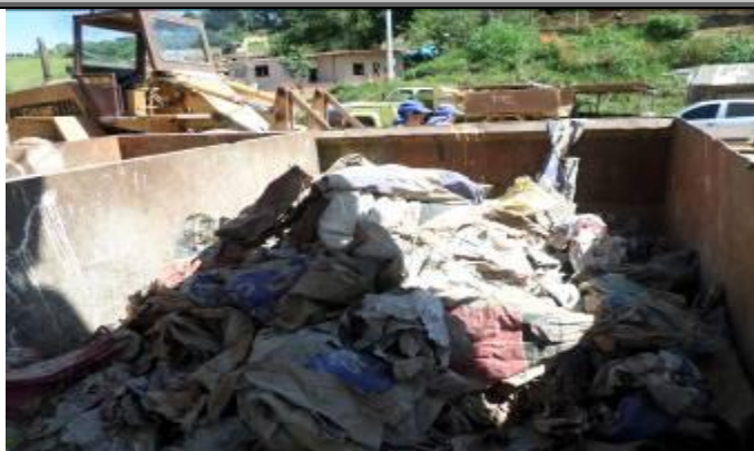
Figura 82 - Caçamba ao lado da esteira com o material (Sacos de Cimento) separado
