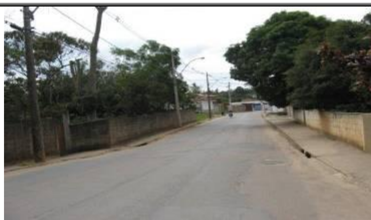
Figura 160 - Vista de um ponto baixo no Bairro da Ponte
