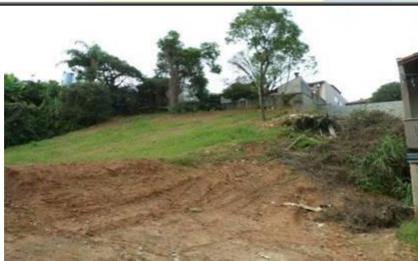
Figura 186 - Visto de um aterramento e reconstrução do talude para contenção de processos erosivos.
