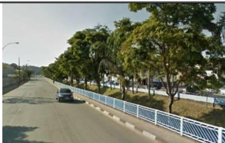
Figura 118 - Trecho à jusante da T 09.
