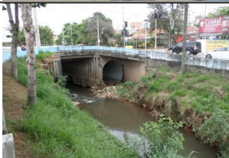
Figura 120 - Vista a Montante da Travessia T11 na Rua Joaquim B. de Campos.
