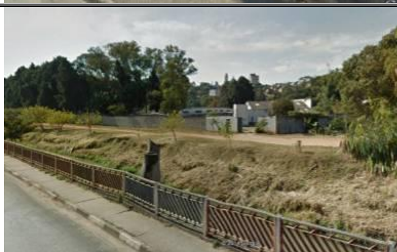
Figura 111 - Trecho à jusante do ponto T 05.
