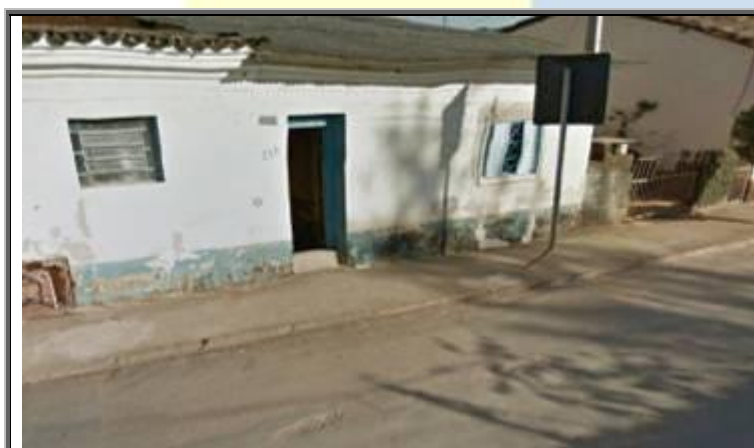
Figura 159 - Vista de uma residência com barreiras de contenção na porta para impedir entrada de água
