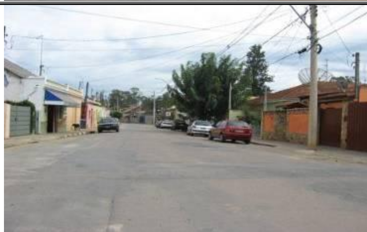
Figura 161 - Vista da rua no Bairro da Ponte. Baixa declividade longitudinal afeta o escoamento da água
