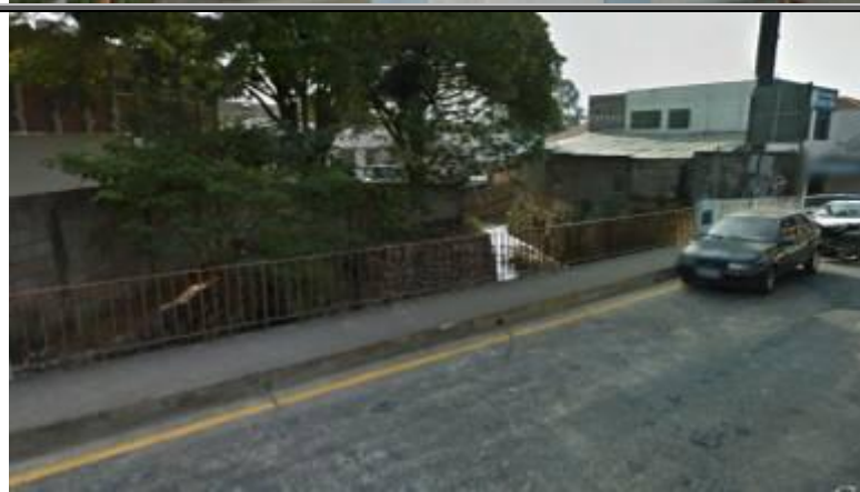
Figura 114 - Vista do trecho à jusante do T07 Avenida Marechal Deodoro.
