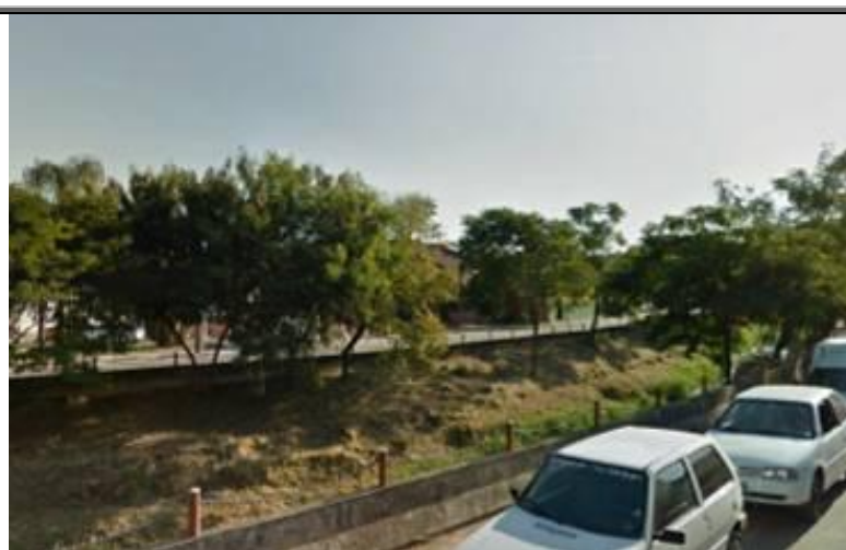
Figura 109 - Trecho à jusante do ponto T 04.
