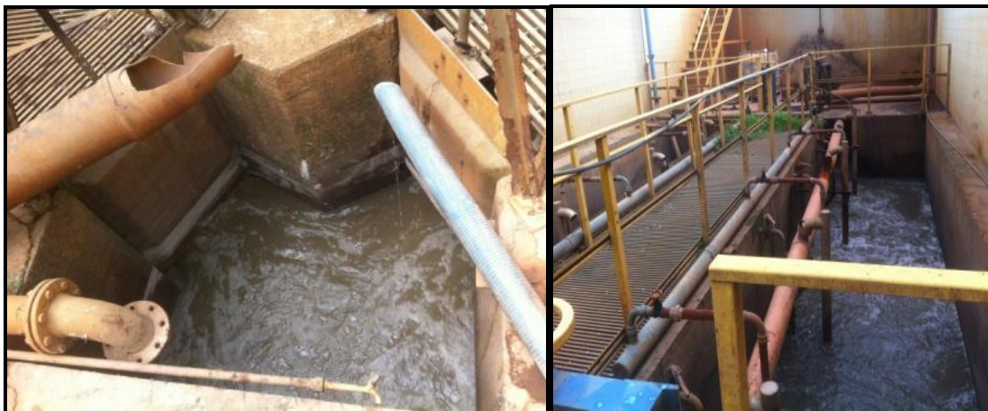
Figura 52 - Caixas de areia
