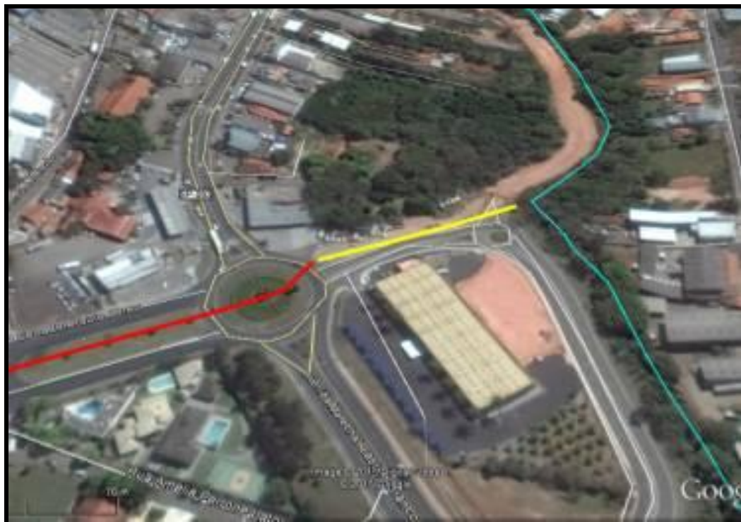
Figura 144 - Imagem de Satélite do trecho canalizado do Córrego Perpétuo
