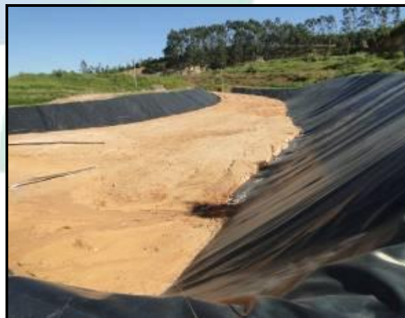
Figura 65 - Célula impermeabilizada com manta de PEAD
