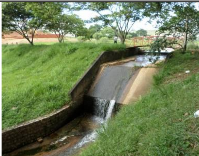
Figura 147 - Vista extravasor da lagoa do Córrego Perpétuo.
