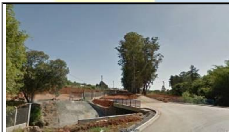
Figura 105 - T 01 – Condições da travessia no trecho T01.
