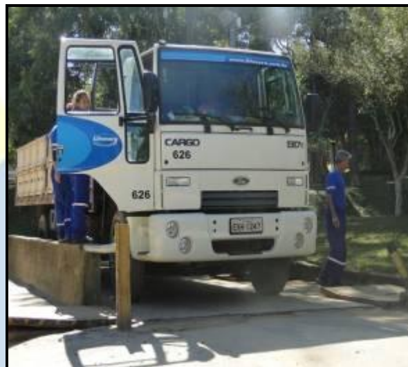
Figura 63 - Balança para controle de entrada e saída de resíduos
