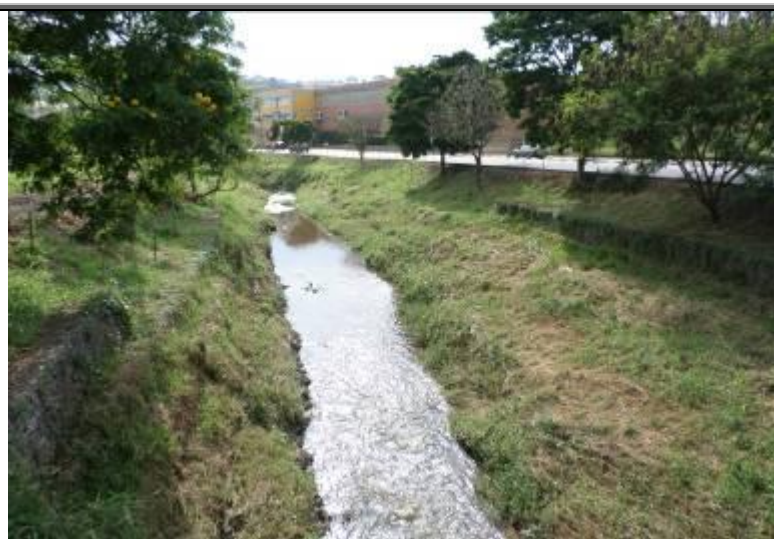
Figura 123 - Vista a Montante da travessia da Av. Nossa Senhora das Graças - Rio Jacaré.
