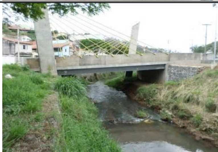
Figura 127 - Vista a montante das condições da ponte da Travessa Olivio Tegen.
