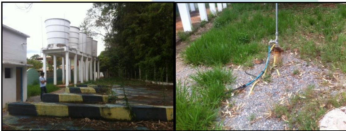
Figura 41 - Poço e reservação
