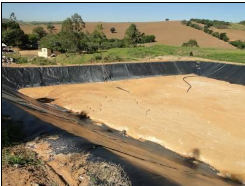
Figura 66 - Célula impermeabilizada com manta de PEAD
