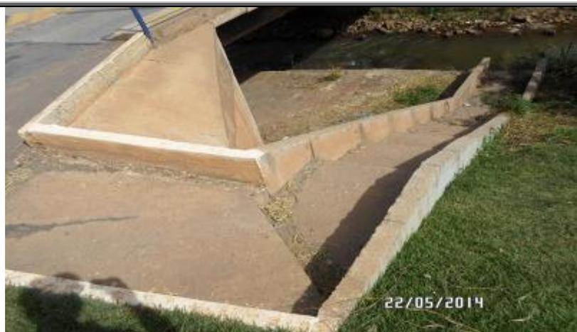
**Figura 87 - Vista de outro ângulo da escada hidráulica**
