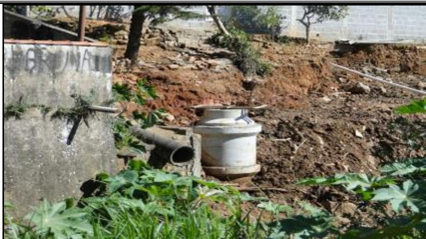
**Figura 65 - Emissário de esgotos em construção na margem direita do rio Camanducaia nas proximidades da ponte da Av. Rio Branco**
