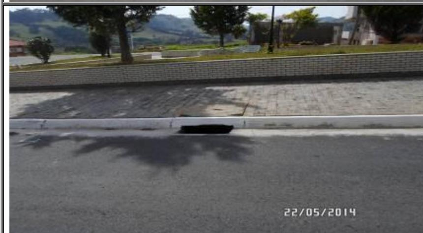
**Figura 109 - Vista de uma boca de lobo, porém sem grelha**
