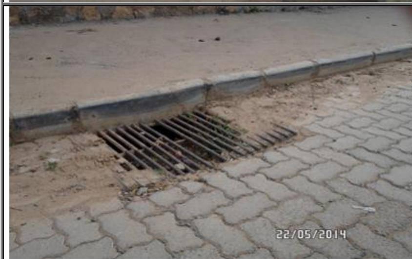
**Figura 125 - Vista de uma boca de lobo obstruída por sedimentos**
