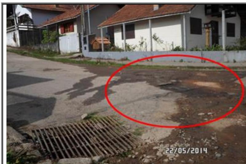
**Figura 127 - Vista do espraio das águas pluviais nas vias**
