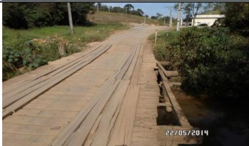
**Figura 89 - A Ponte sobre o Rio Camanducaia em condições precárias**
