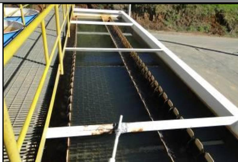
**Figura 42 - Decantador da ETA**
