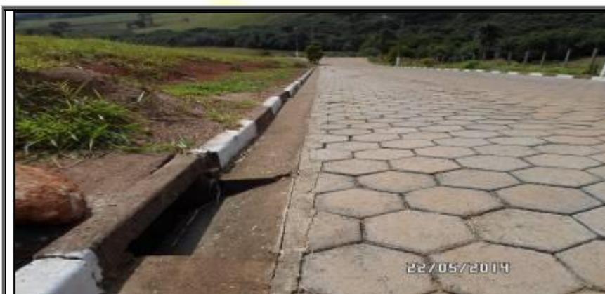
**Figura 111 - Pavimento de bloquete e dispositivos de microdrenagem**
