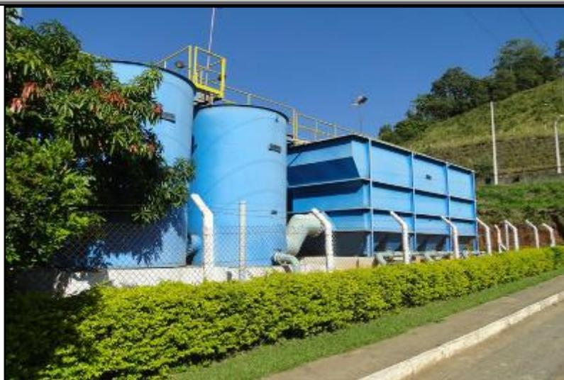
**Figura 40 - Flocculadores e decantador da ETA**
