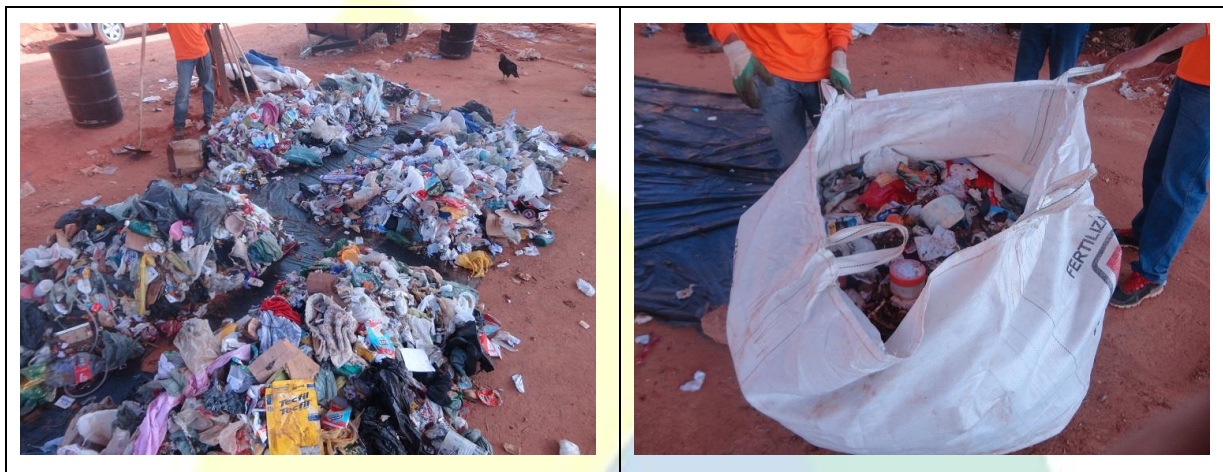
Figura 12 - Quarteamento e armazenamento da amostra final resultante de cada caminhão.
