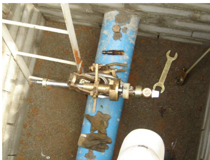
Figura 3.13. EP encaixada na base da máquina
