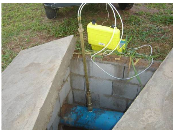
Figura 3.20. Tubo Pitot inserido em uma tubulação e conectado a um equipamento que contém um sensor de diferencial de pressão
