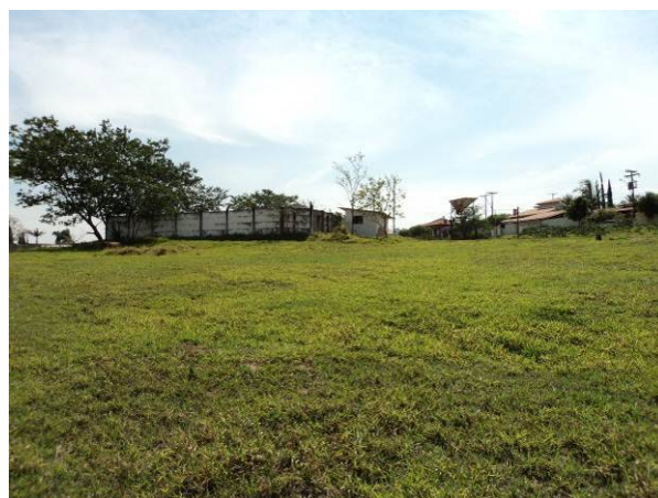
Figura 4.58. Vista externa do Reservatório - RENT 07
