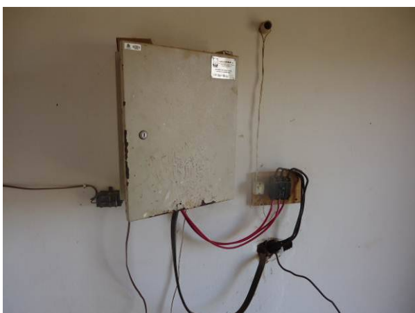
Figura 4.32. Vista do painel fechado em estado regular de conservação
