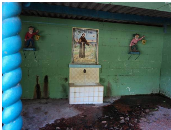
Figura 4.54. Vista da Fonte da Saúde, local que recebe água dos drenos
