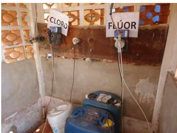
Figura 4.78. Detalhe das bombas dosadoras de cloro e flúor
