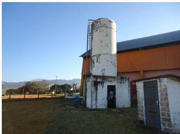
Figura 4.10 Vista geral do Reservatório REL-01
