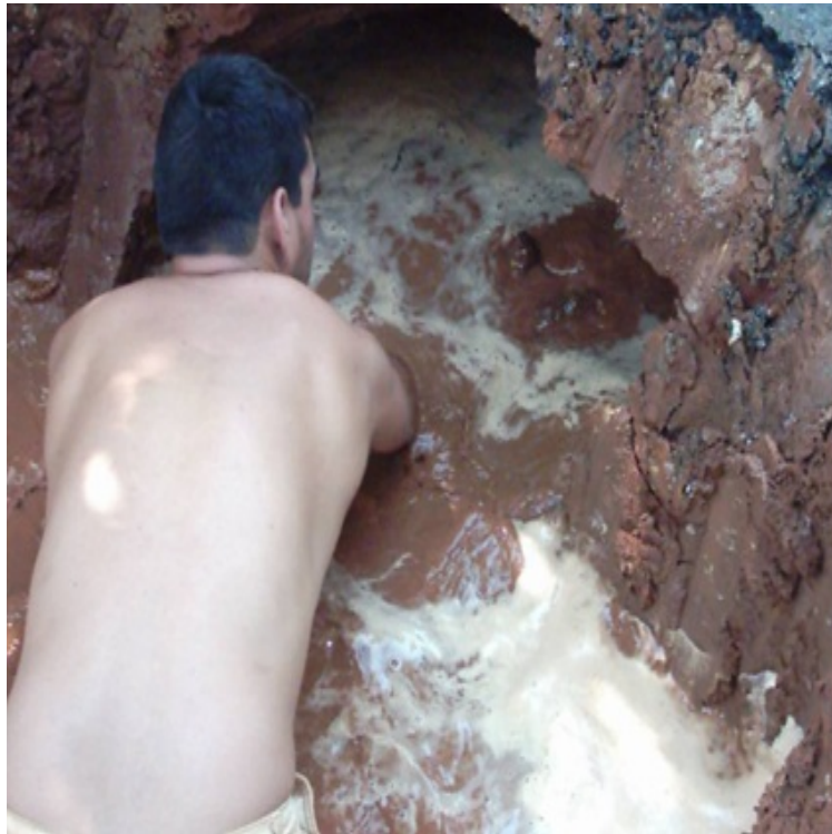
Figura 8.5. Reparo do vazamento
