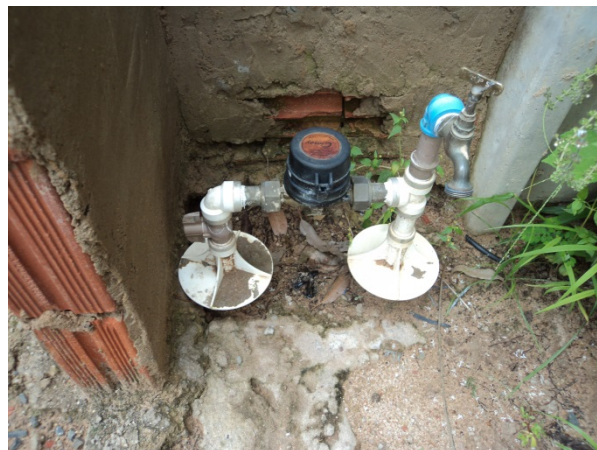
Figura 10.2. Vista do Hidrômetro na Rua C nº.184
