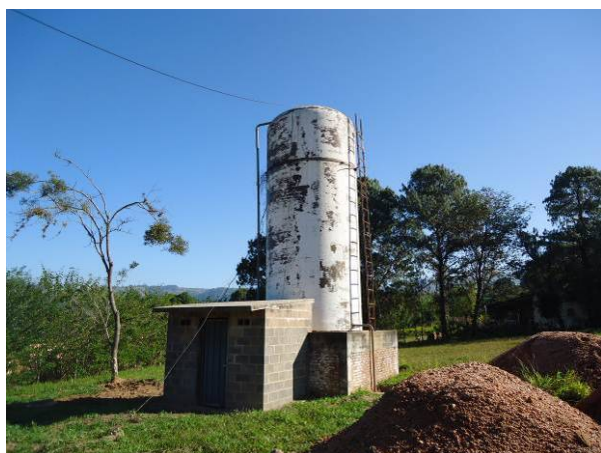
Figura 4.18. Vista geral do Reservatório REL-02
