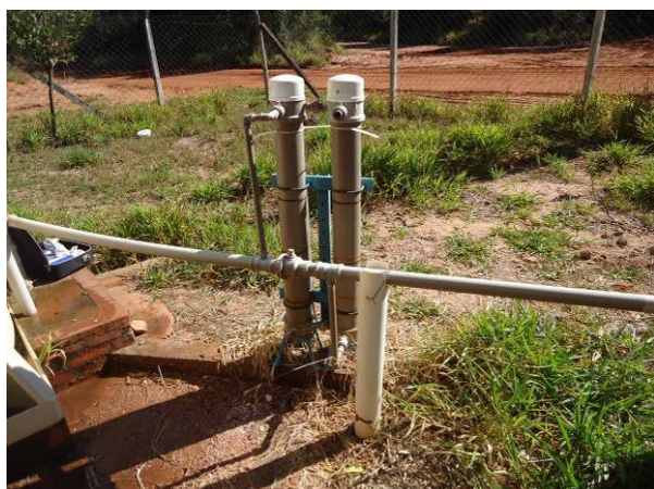
Figura 4.44. Detalhe da aplicação de cloro e flúor no Poço 06
