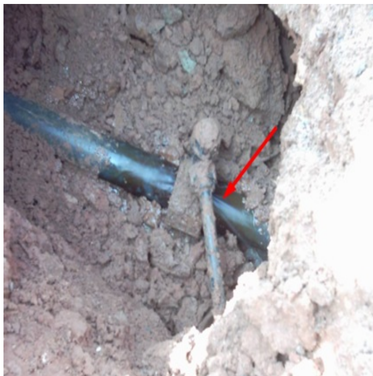
Figura 8.8. Localização do vazamento no ferrule
