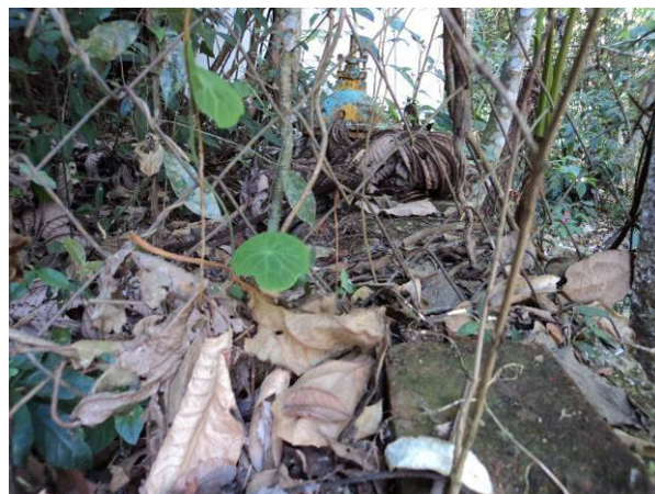
Figura 4.52. Detalhe do registro que controla o envio de água para o Reservatório Enterrado
