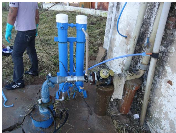
Figura 4.5 Vista geral do Poço 01
