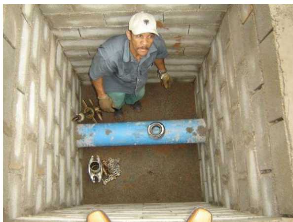
Figura 3.7. Colocação do anel de borracha
