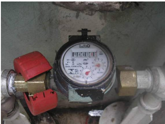
Figura 10.13. Hidrômetro com lacre violado
