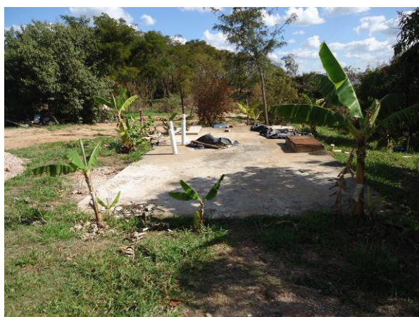
Figura 4.79. Vista geral do Reservatório Enterrado RENT 08 da ETA
