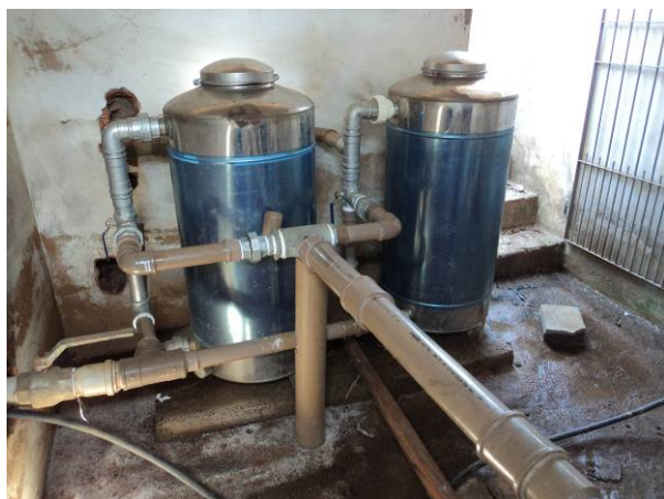
Figura 4.82. Filtros de areia na saída do Reservatório Enterrado (RENT 08)
