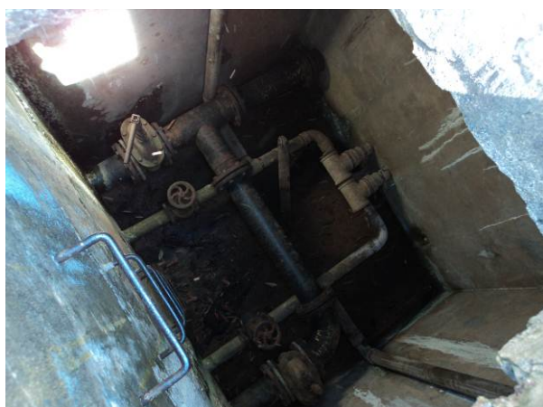
Figura 4.61. Local da tubulação de saída para a rede (150 mm FF)
