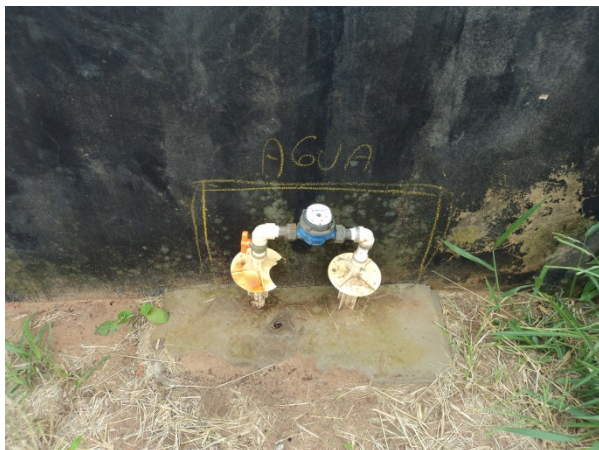
Figura 10.1. Vista do Hidrômetro na Estrada Municipal nº. 1.920
