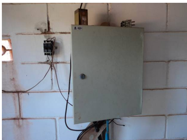
Figura 4.46. Vista do painel fechado em estado regular de conservação
