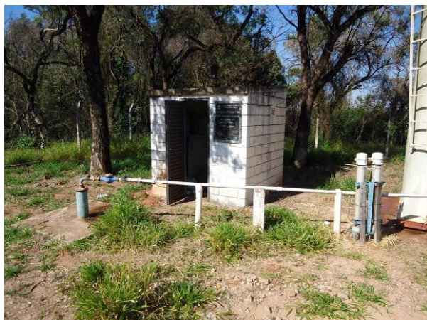
Figura 4.42. Vista geral do Poço 06
