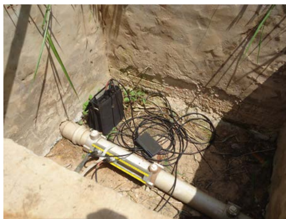
Figura 3.24. Vista durante a medição 02
