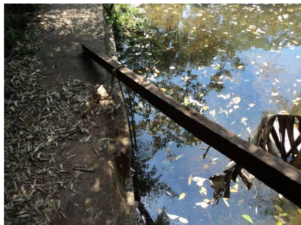
Figura 4.69. Vista do dispositivo manual para abertura da barragem
