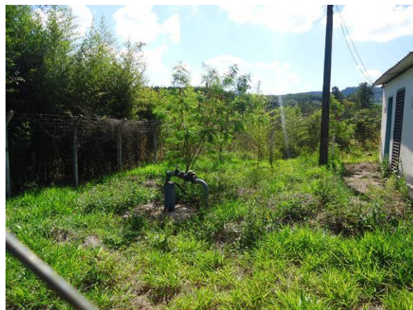
Figura 4.13. Vista geral do Poço 02.
