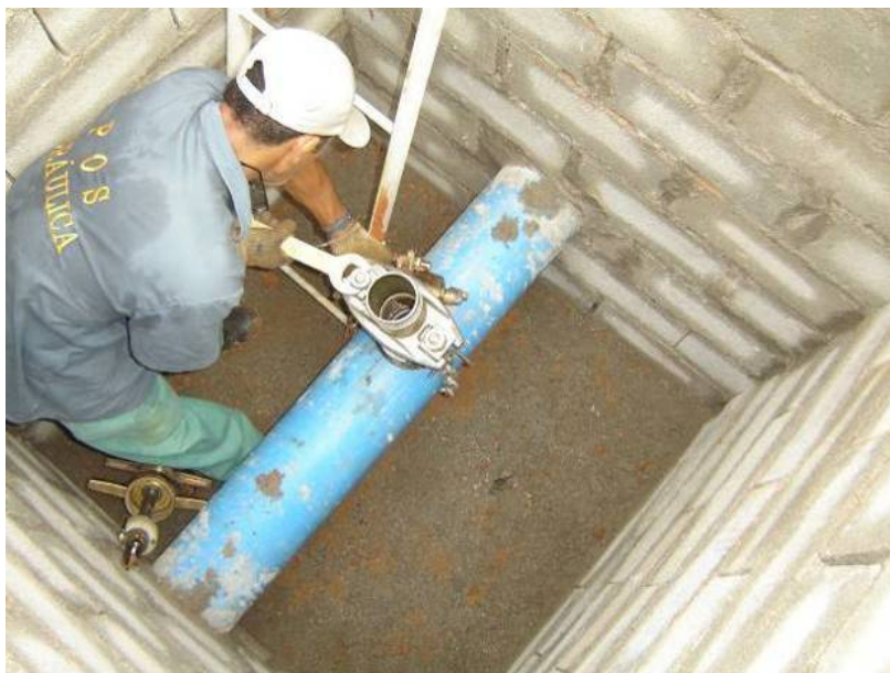
Figura 3.8. Colocação do suporte da máquina Miller
