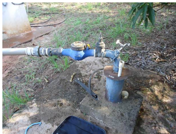
Figura 4.21 Detalhe do Poço 03.
