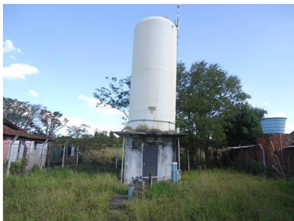
Figura 4.40. Vista geral do Reservatório REL-05
