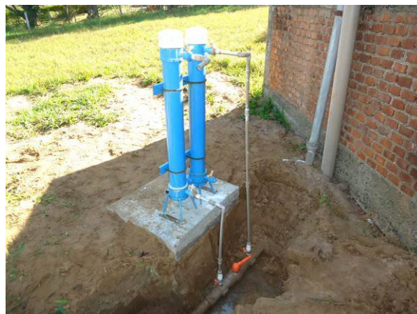
Figura 4.15. Detalhe do aplicador de cloro e flúor, instalado na entrada do reservatório.
