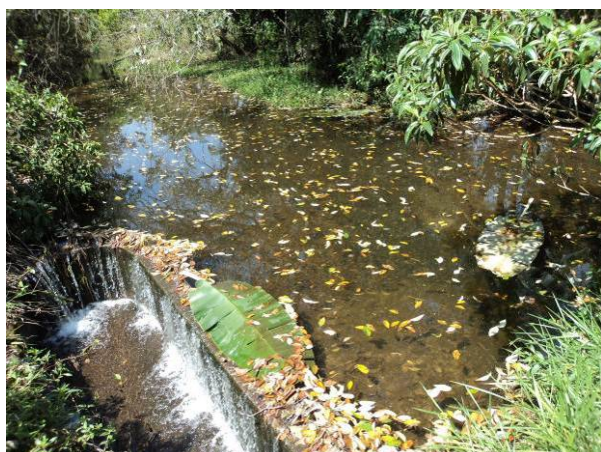
Figura 4.66. Vista da barragem de acumulação do Córrego do Retiro
