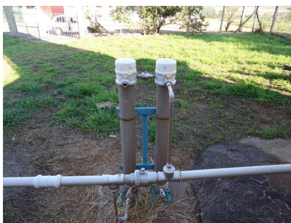
Figura 4.31. Detalhe do aplicador de cloro e flúor
