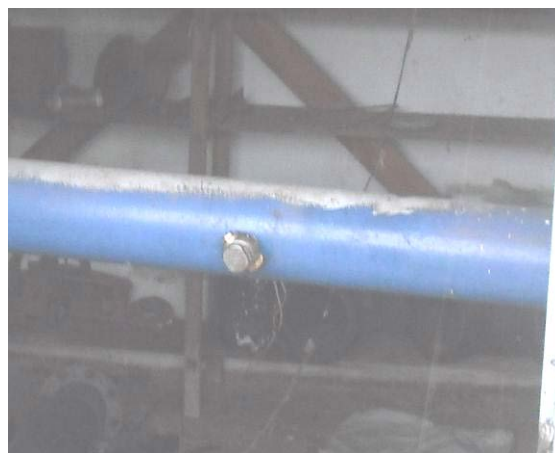
Figura 1.10. Vista do TAP instalado na tubulação
