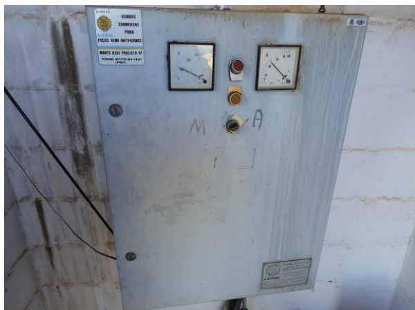
Figura 4.8. Vista do painel fechado em estado regular de conservação
