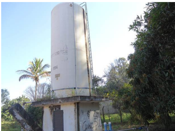
Figura 4.26. Vista geral do Reservatório REL-03.
