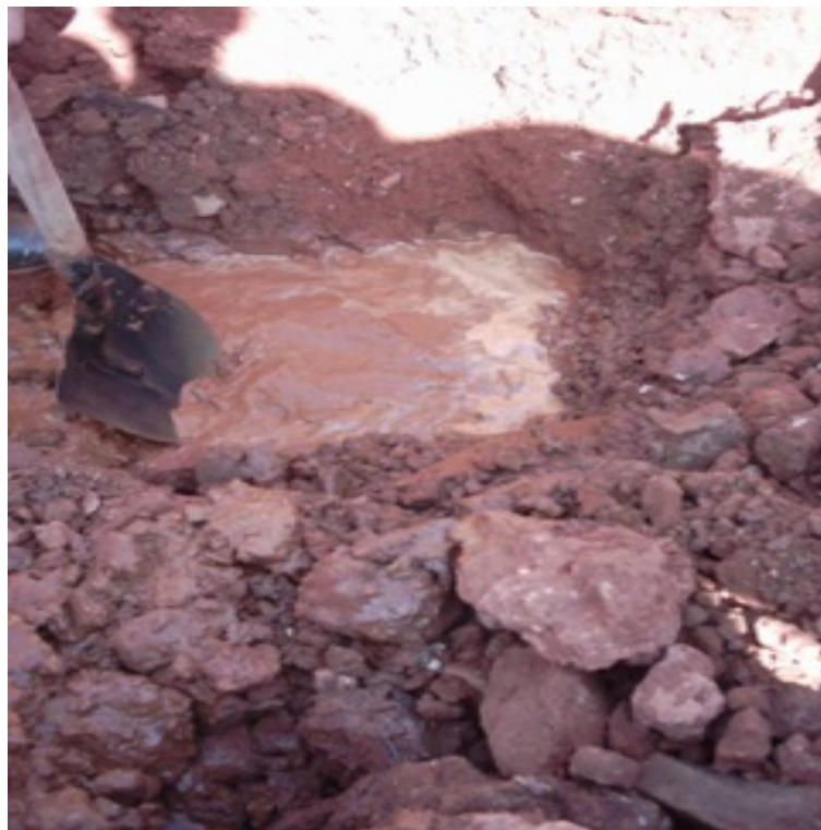
Figura 8.7. Localização do vazamento não visível
