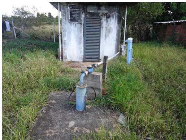
Figura 4.36. Vista geral do Poço 05
