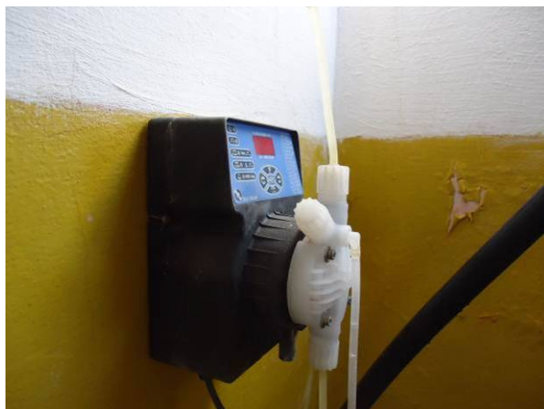
Figura 4.60. Detalhe da bomba dosadora
