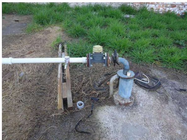
Figura 4.29. Detalhe do Poço 04
