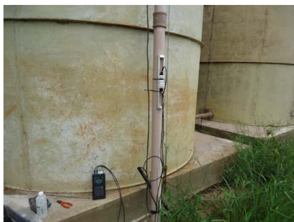
Figura 3.30. Vista durante a medição 08
