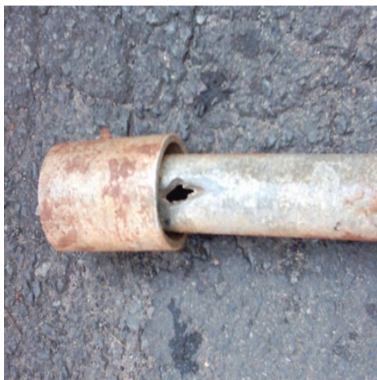
Figura 8.4. Furo na rede que causou o vazamento
