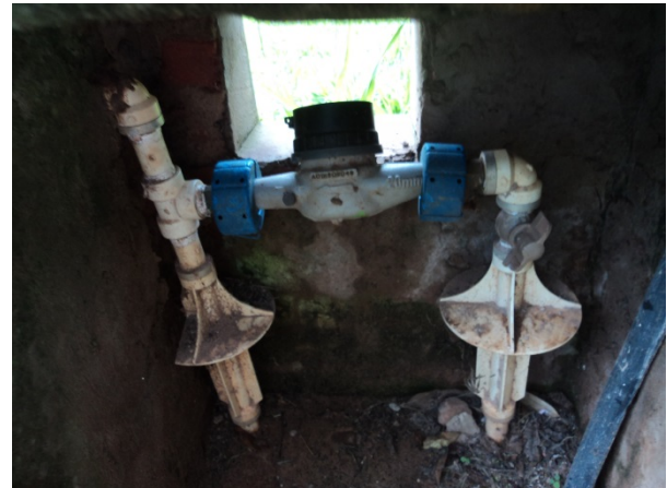
Figura 10.4. Vista do Hidrômetro na Rua H nº 108
