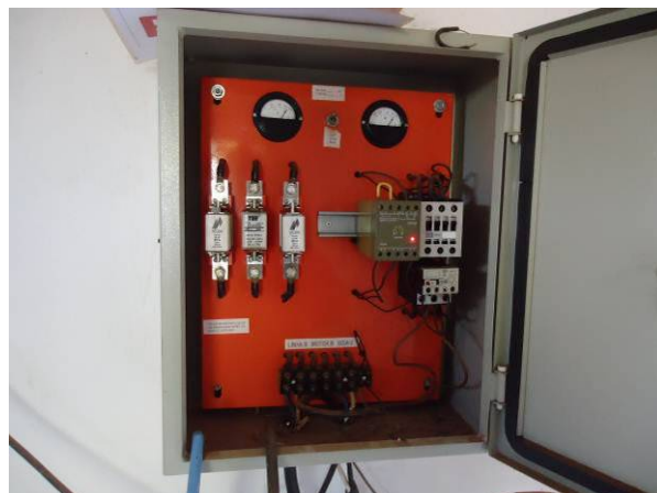
Figura 4.25. Vista do painel aberto sem software start-stop e inversor de frequência.
