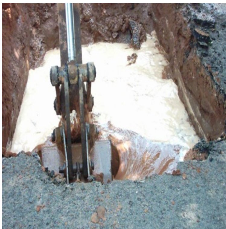
Figura 8.3. Localização do vazamento
