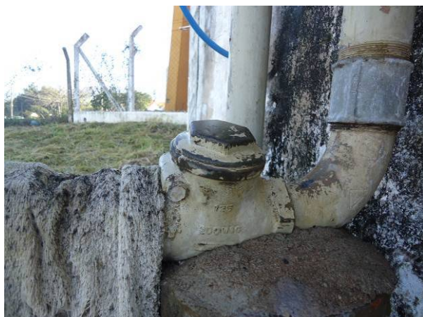
Figura 4.6. Detalhe da válvula de retenção
