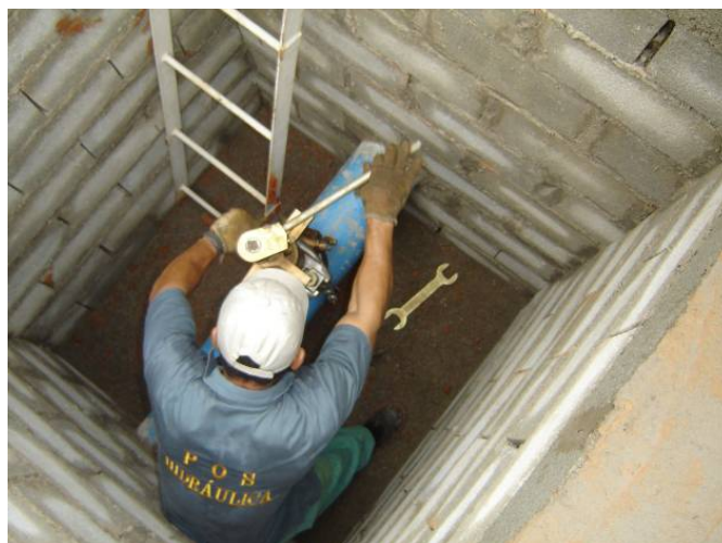
Figura 3.12. Momento em que a tubulação é furada
