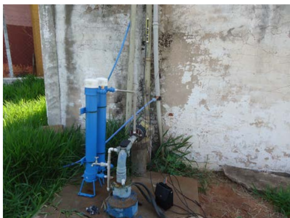
Figura 3.23. Vista durante a medição 01
