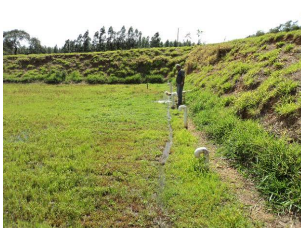
Figura 4.77. Vista geral da entrada de água na célula
