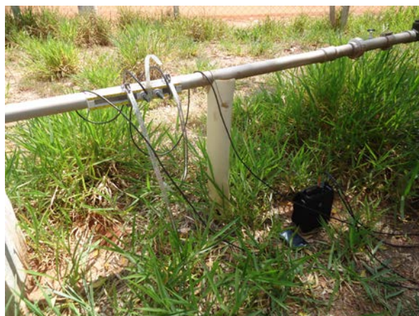
Figura 3.28. Vista durante a medição 06
