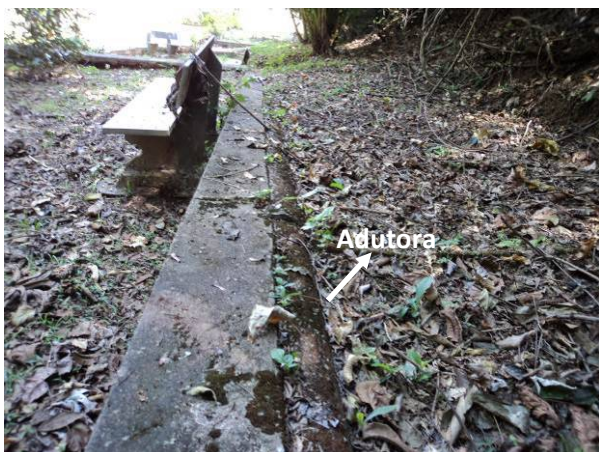
Figura 4.53. Detalhe da adutora de 150 mm de Cimento Amianto
