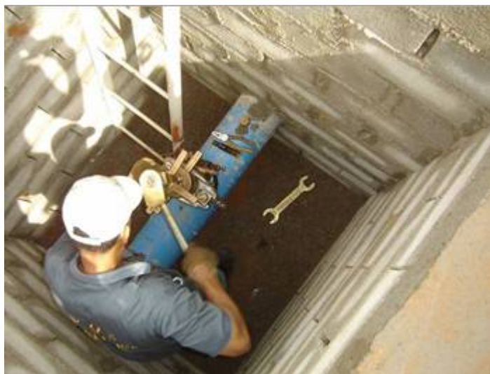
Figura 3.14. Momento em que a EP está sendo rosqueada na tubulação
