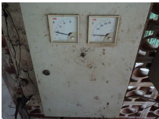
Figura 4.70 Vista do painel elétrico fechado
