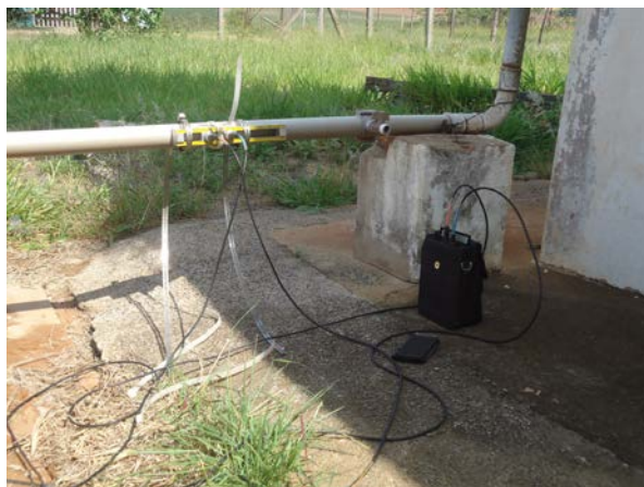
Figura 3.26. Vista durante a medição 04
