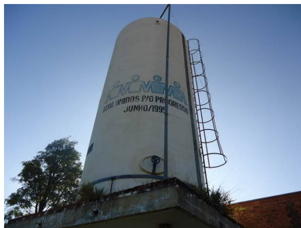
Figura 4.35. Vista geral do Reservatório REL-04
