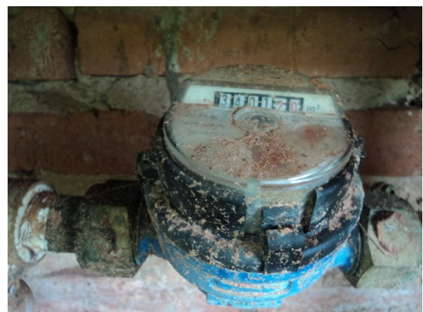
Figura 10.8. Vista do Hidrômetro na Rua D nº 492
