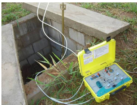
Figura 3.21. Tubo Pitot inserido em uma tubulação e conectado a um equipamento que contém um sensor de diferencial de pressão
