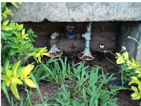
Figura 10.7. Vista do Hidrômetro na Rua D nº 492
