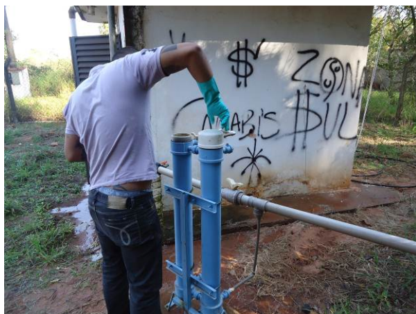
Figura 4.22. Detalhe da aplicação de cloro e flúor no Poço 03.
