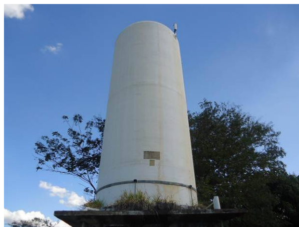
Figura 4.41. Detalhe do Reservatório REL-05
