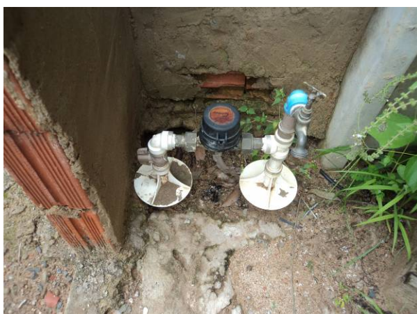
Figura 11.3. Cavalete existente em uma residência no município de Analândia.
