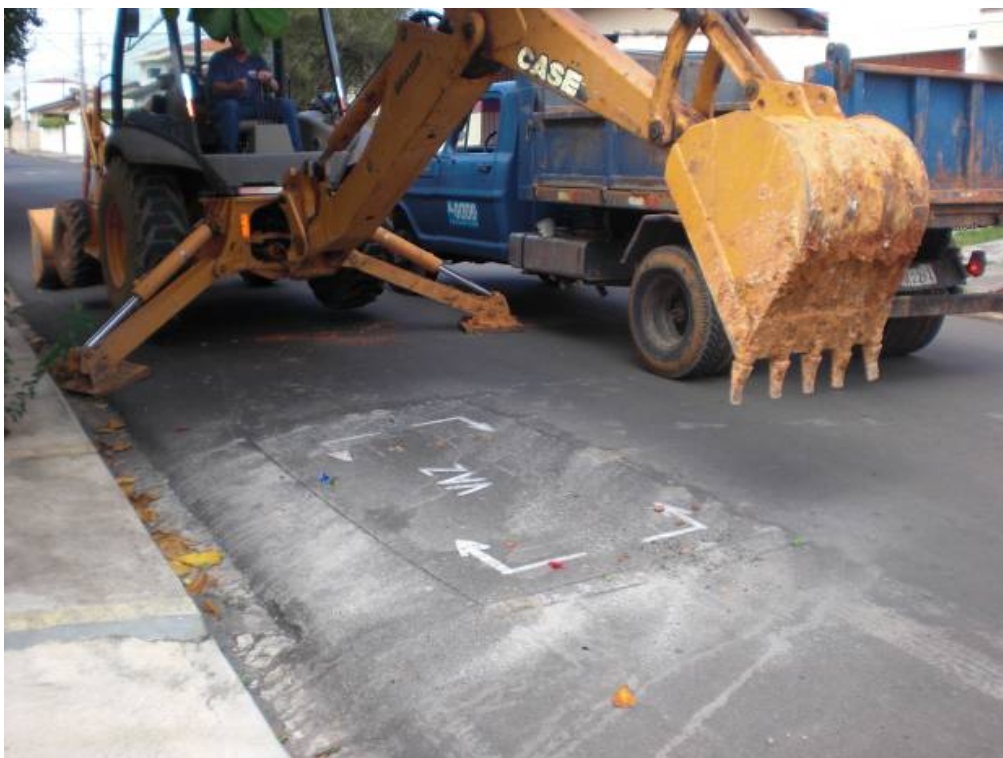
Figura 1.16. Retroescavadeira abrindo um local do vazamento não visível
