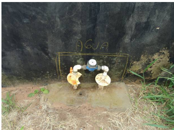
Figura 11.1. Cavalete existente em uma residência no município de Analândia.
