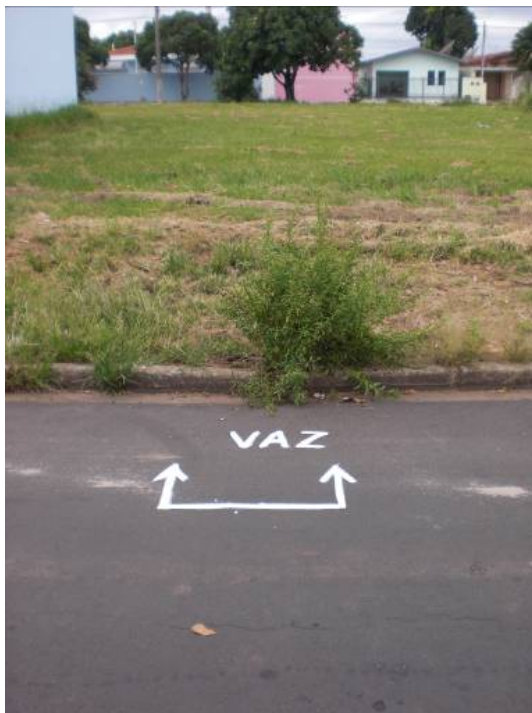
Figura 1.15. Demarcação com tinta branca no local onde foi detectado vazamento não visível
