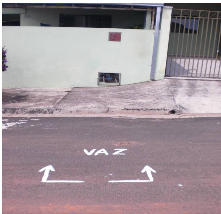
Figura 8.1. Demarcação com tinta branca no local onde foi detectado vazamento não visível
