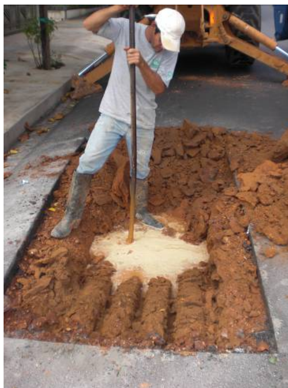
Figura 1.17. Localização do vazamento
