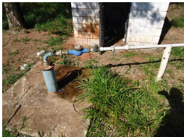
Figura 4.43. Detalhe do Poço 06
