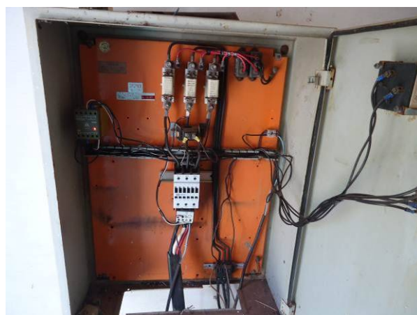
Figura 4.17. Vista do painel aberto sem software start-sotp e inversor de frequência.
