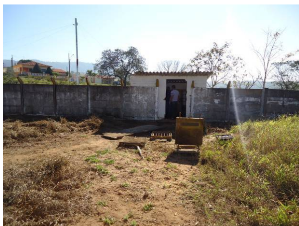
Figura 4.55. Vista geral do Reservatório Enterrado - RENT 07
