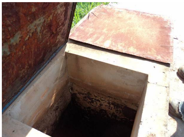
Figura 4.80. Detalhe das duas câmaras do Reservatório Enterrado
