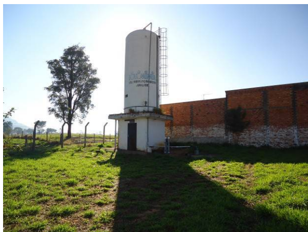
Figura 4.34. Vista geral do Reservatório REL-04
