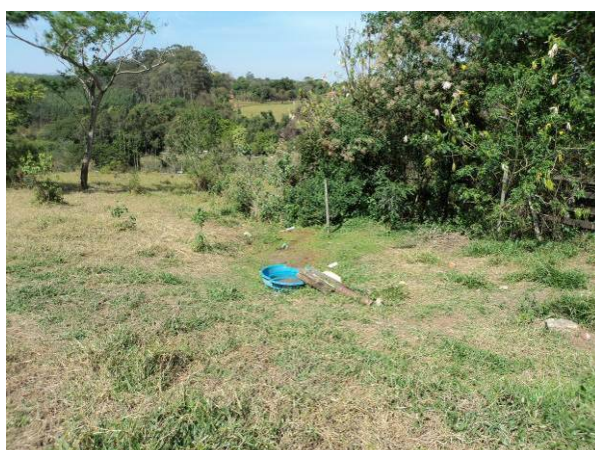
Figura 4.64. Local onde a água é extravasada e encontra com córrego à jusante
