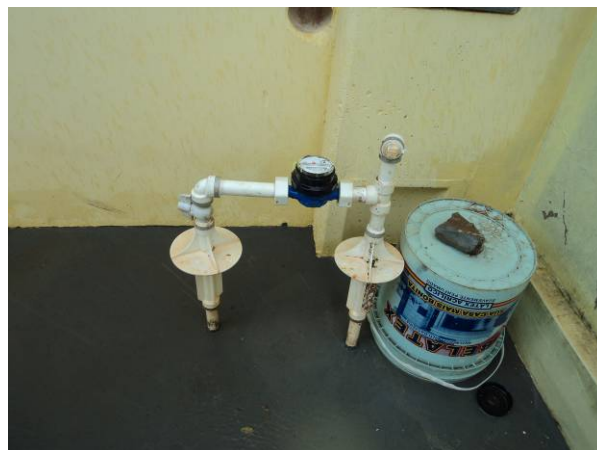
Figura 11.2. Cavalete existente em uma residência no município de Analândia.
