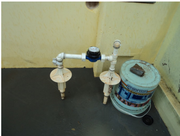
Figura 10.5. Vista do Hidrômetro na Rua H nº. 98
