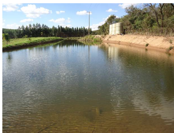
Figura 4.73. Vista geral do tanque de acumulação e decantação
