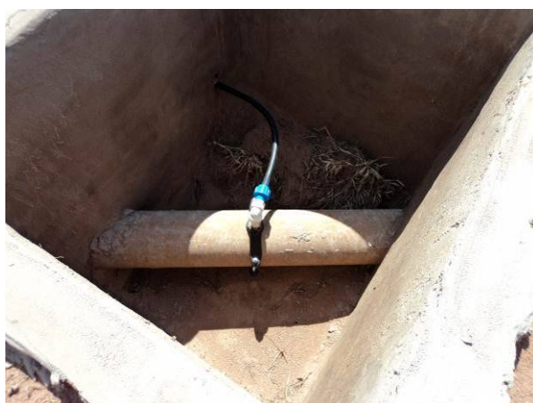
Figura 4.62. Local de aplicação de flúor à montante do reservatório
