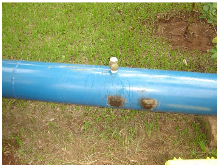
Figura 3.15. Estação Pitométrica (EP) instalada em uma tubulação de água
