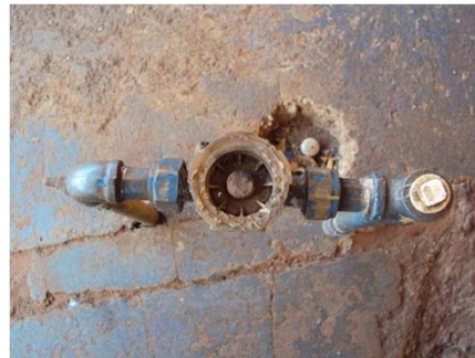
Totalmente quebrado e sem lacre
