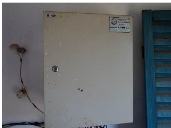
Figura 4.38. Vista do painel fechado em estado regular de conservação.
