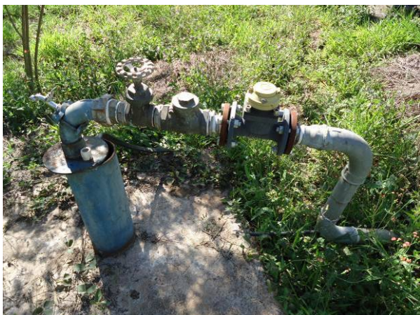
Figura 4.14. Detalhe do Poço 02.
