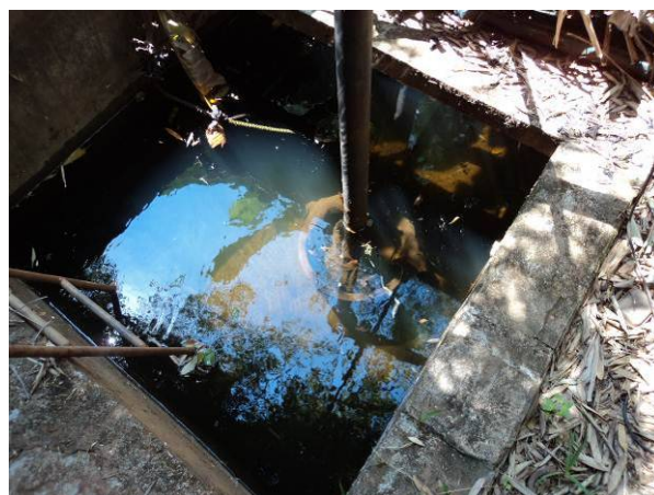
Figura 4.67. Vista do poço de sucção
