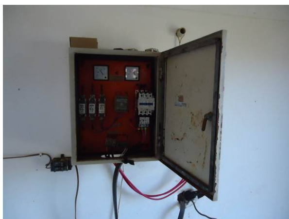
Figura 4.33. Vista do painel aberto sem software start e stop e inversor de frequência
