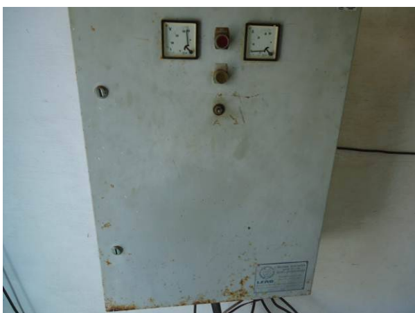
Figura 4.16. Vista do painel fechado em estado regular de conservação.
