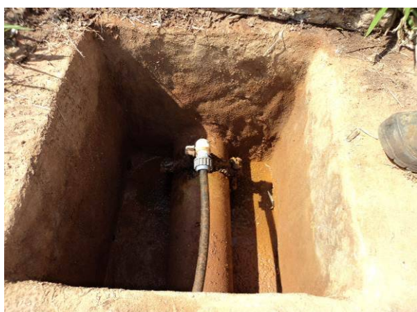
Figura 4.63. Local de aplicação de cloro à montante da entrada do reservatório
