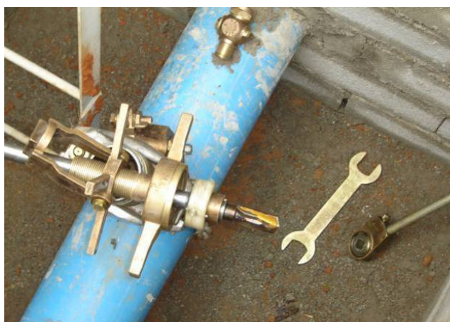
Figura 3.9. Broca encaixada na base da máquina
