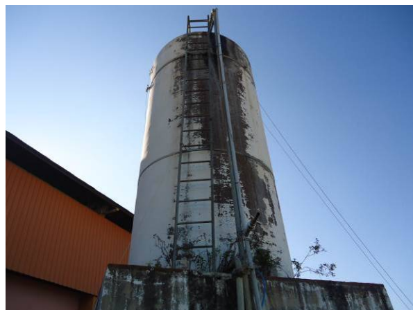
Figura 4.11. Vista geral do Reservatório REL-01.
