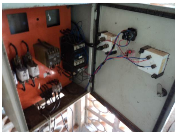
Figura 4.71. Vista do painel elétrico aberto
