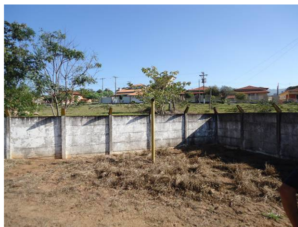
Figura 4.56. Detalhe do respiro no reservatório enterrado - RENT 07
