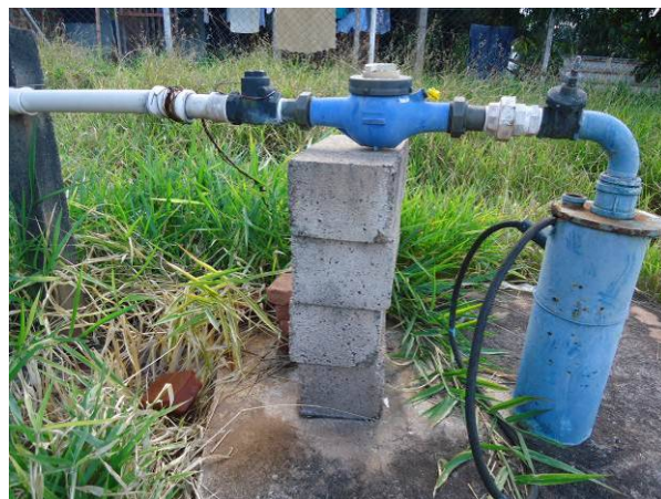
Figura 4.37. Detalhe do Poço 05 com apoio improvisado para o macromedidor
