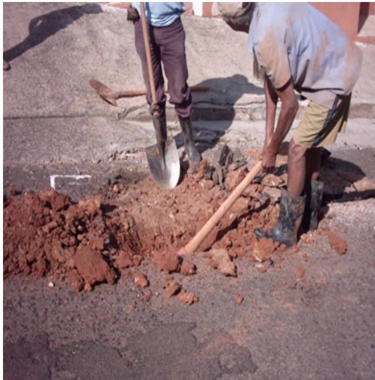
Figura 8.6. Abertura de vala no local indicado de vazamento
