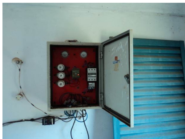
Figura 4.39. Vista do painel aberto sem software start stop e inversor de frequência.
