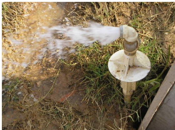
Figura 10.9. Cavalete sem hidrômetro
