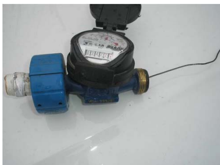
Arame no hidrômetro
