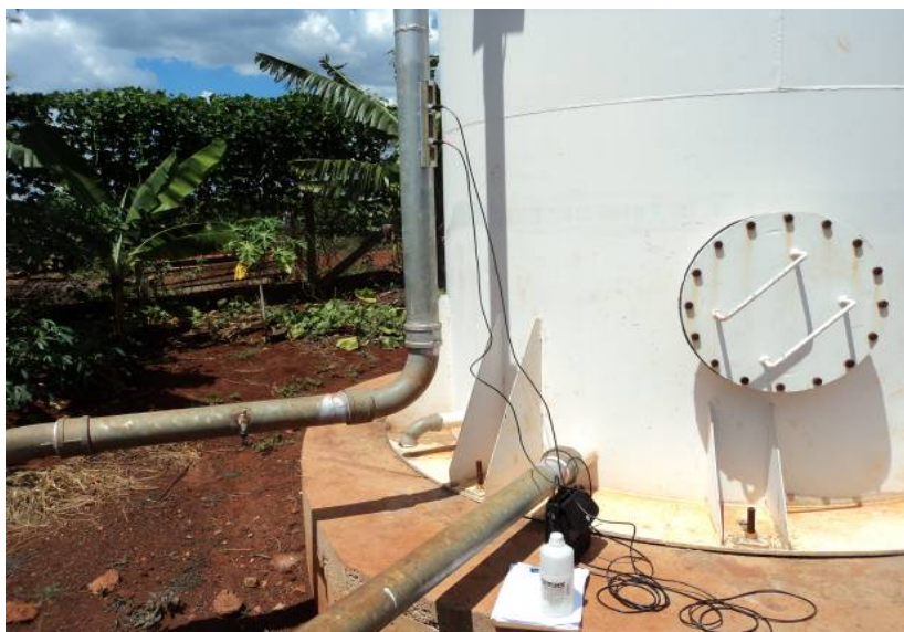
Figura 1.3. Ilustração da posição de escolha para instalação do medidor Ultrassônico (tubulação vertical)
