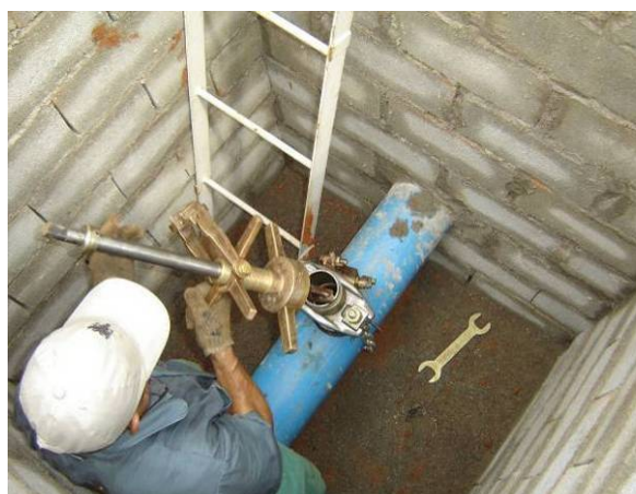
Figura 3.10. Colocação da máquina no suporte
