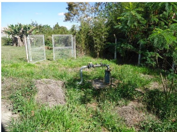
Figura 4.12. Vista geral do Poço 02.
