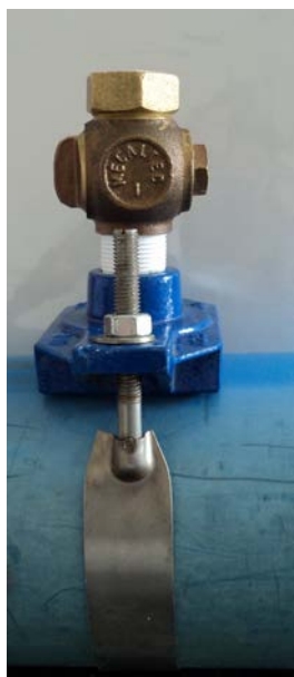
Figura 1.11. Vista do TAP Instalado na tubulação
