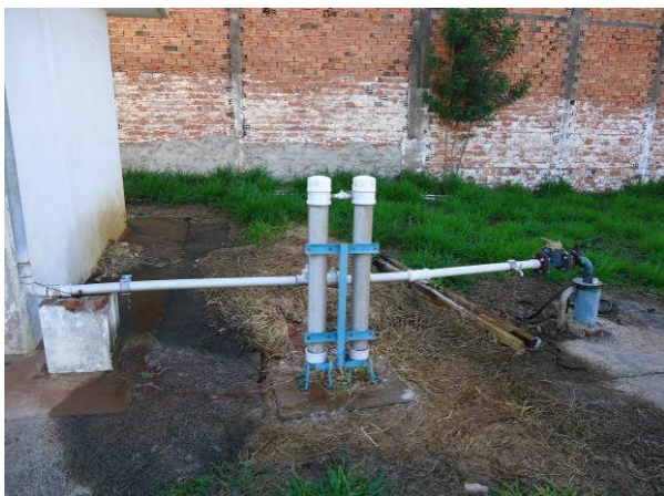
Figura 4.28. Vista geral do Poço 04
