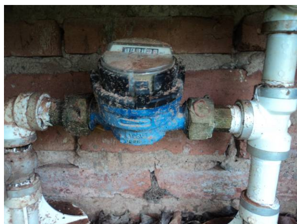
Figura 11.4. Caixas de proteção utilizadas nos cavaletes de duas residências do município de Analândia.
