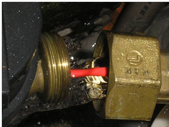
Figura 10.10. Hidrômetro com arame
