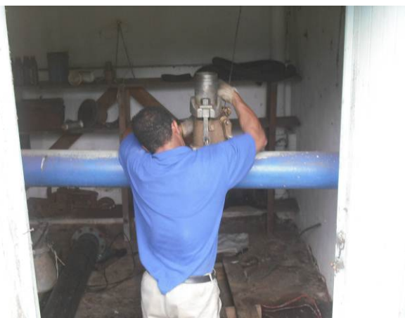
Figura 1.9. Utilização da Máquina Miller
