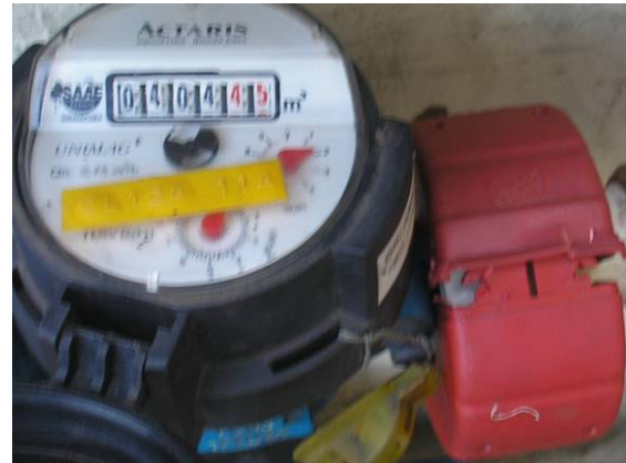
Figura 10.12. Hidrômetro com lacre violado
