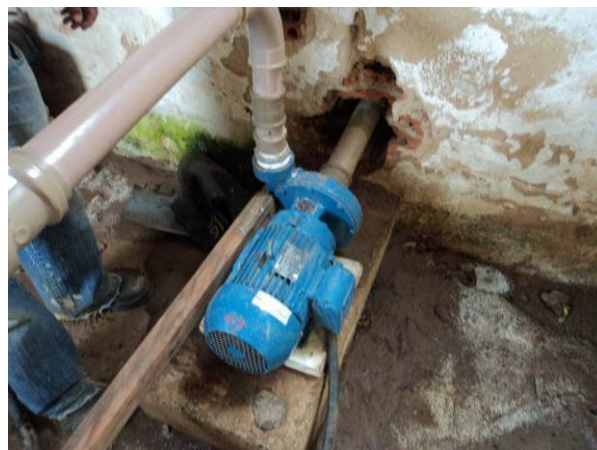
Figura 4.81. Bomba de recalque para envio de água tratada para os reservatórios de fibra de vidro
