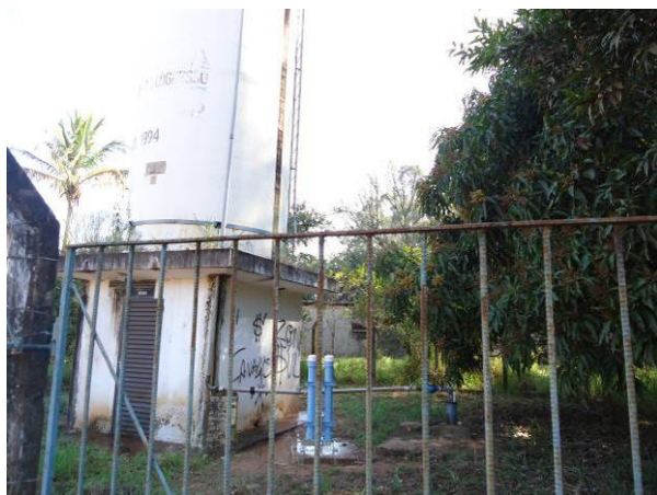
Figura 4.20. Vista geral do Poço 03.
