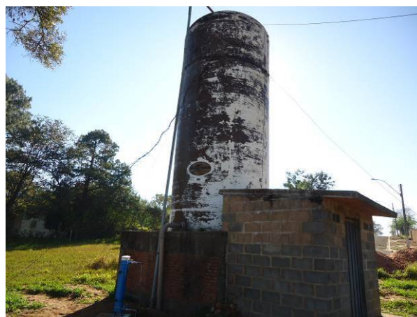
Figura 4.19. Vista geral do Reservatório REL-02
