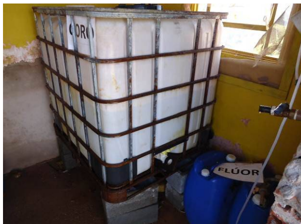
Figura 4.59. Detalhe do cloro e flúor armazenado
