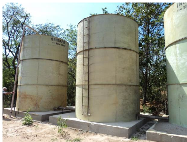
Figura 4.83. Reservatórios em série que reservam água tratada e distribuem para o Portal das Samambaias
