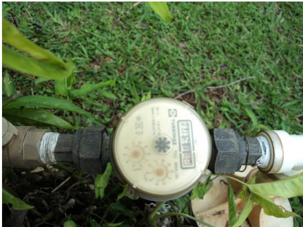
Figura 10.3. Vista do Hidrômetro na Rua H nº. 138
