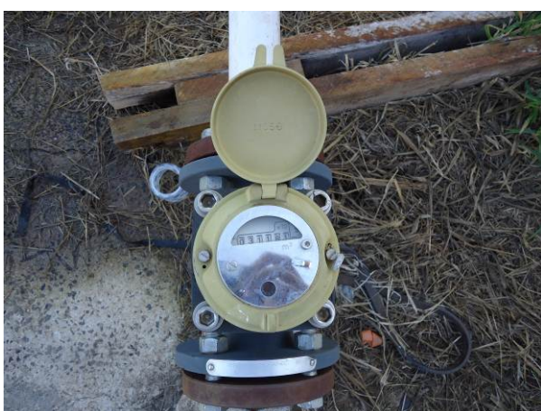
Figura 4.30. Detalhe do macromedidor quebrado
