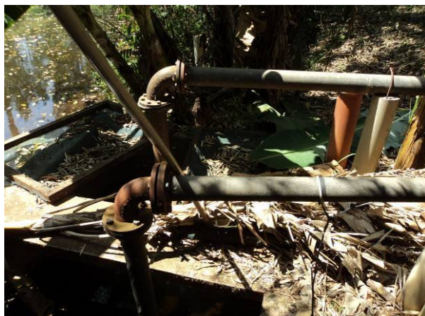
Figura 4.68. Detalhe das tubulações de sucção.
