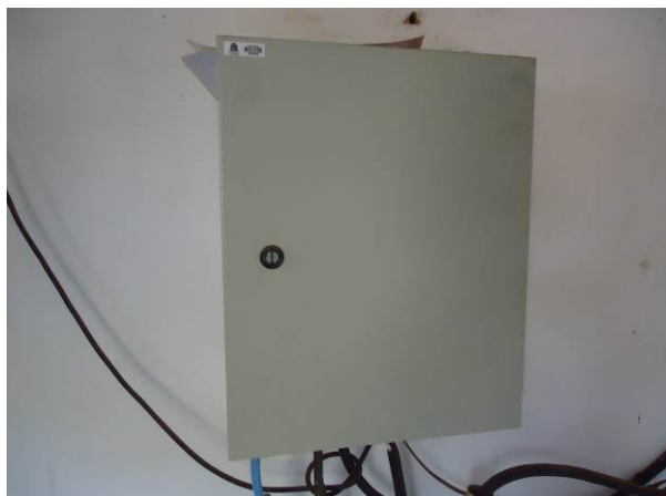
Figura 4.24. Vista do painel fechado em bom estado de conservação.
