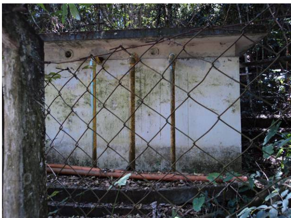
Figura 4.51. Vista da caixa de passagem que recebe água dos drenos
