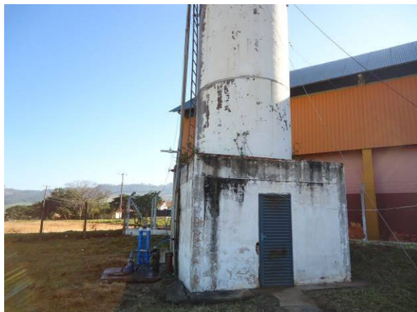
Figura 4.4. Vista geral do Poço 01 e Reservatório REL-01
