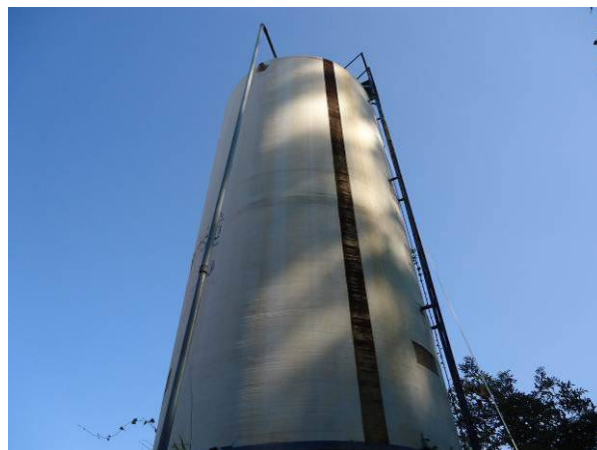
Figura 4.27. Vista geral do Reservatório REL-03.
