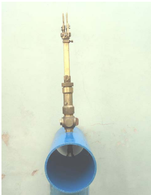
Figura 1.13. Vista de um Pitot dentro da tubulação
