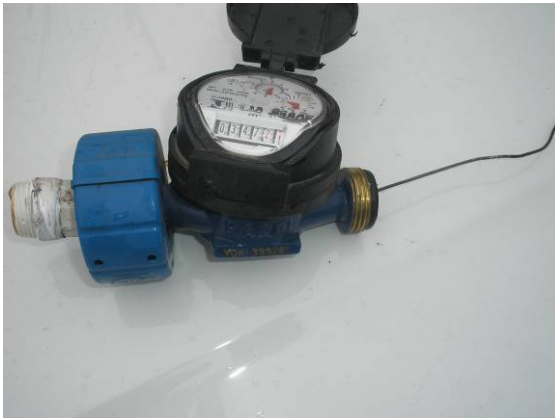
Figura 10.11. Hidrômetro com arame
