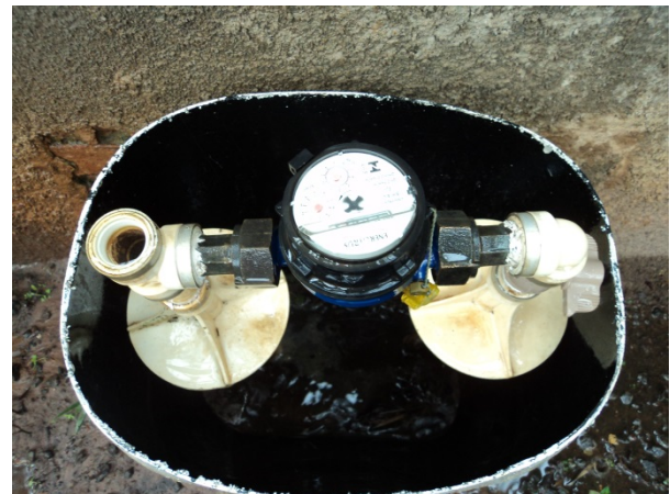
Figura 10.6. Vista do Hidrômetro na Avenida 05 nº 228
