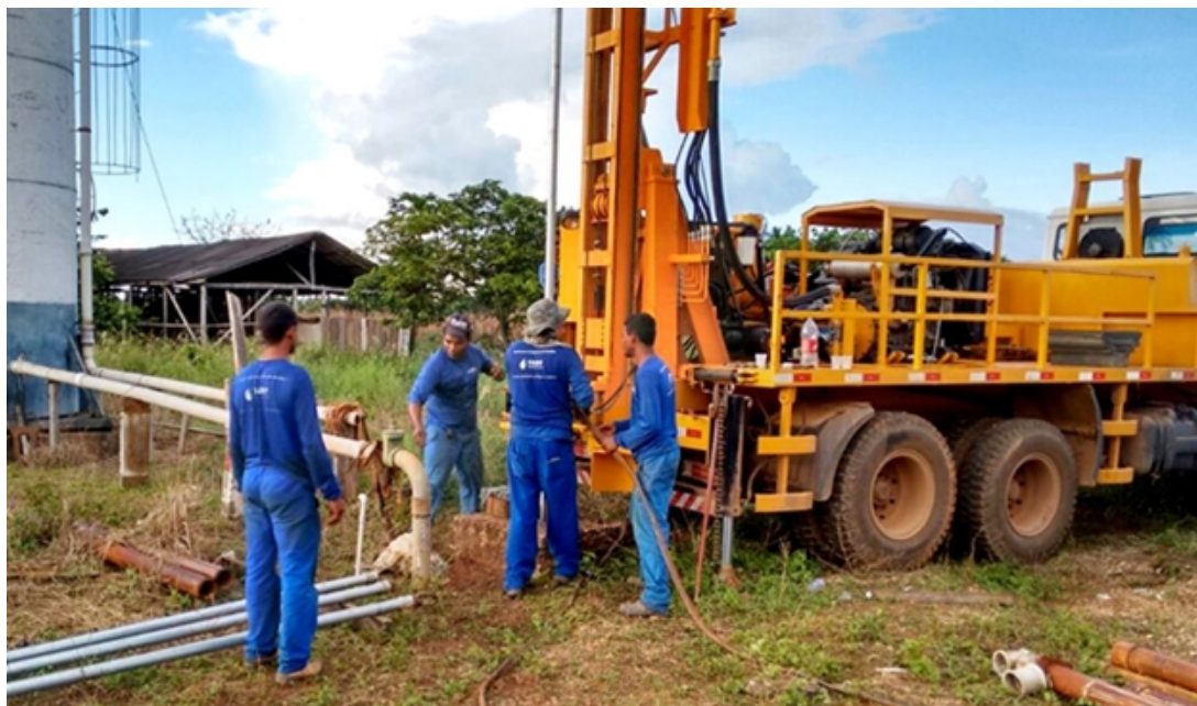
Figura 4.84. Ilustração de manutenção de poço tubular profundo
