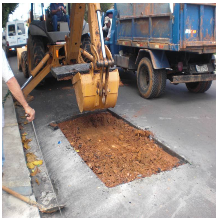
Figura 8.2. Retroescavadeira abrindo o local do vazamento não visível
