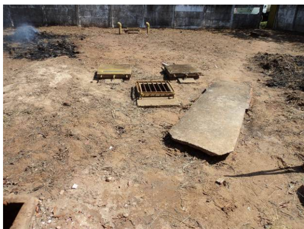
Figura 4.57. Vista geral do Reservatório Enterrado - RENT 07.
