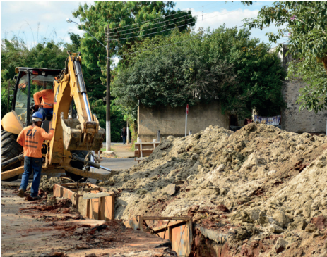
Implantação da rede de esgoto de Capivari/SP – Foto: SAAE
