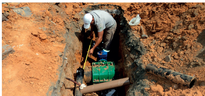
Substituição de rede de abastecimento de água em Capivari - Foto: SAAE Capivari
