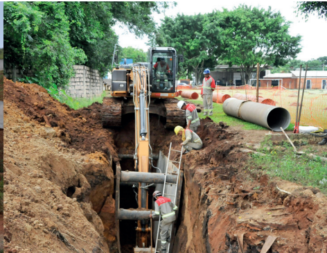
Interceptor de esgoto em Indaítuba- Foto: Giuliano Miranda/DCS SAAE
