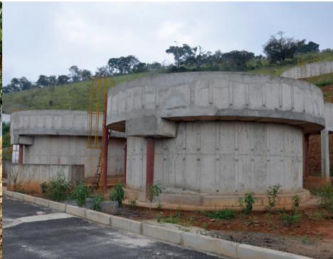
Construção da ETE de Camanducaia/MG - Foto: Josevane Victor
