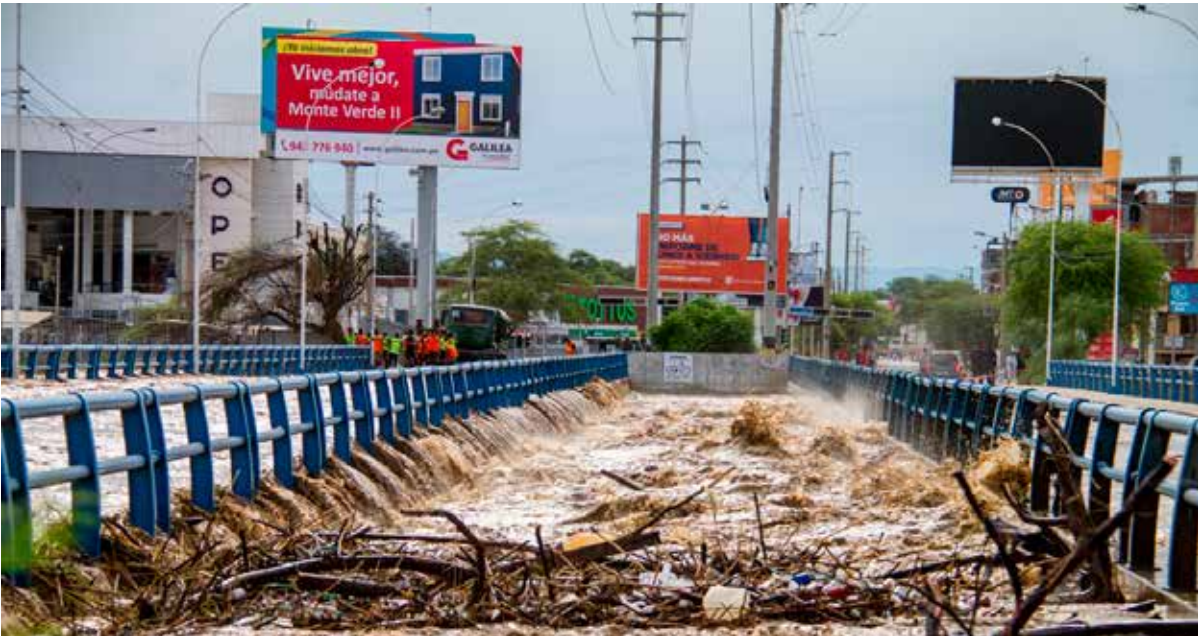
Vista frontal del desbordamiento del Río Piura, altura del puente Cáceres, con 3,425 m³/s
