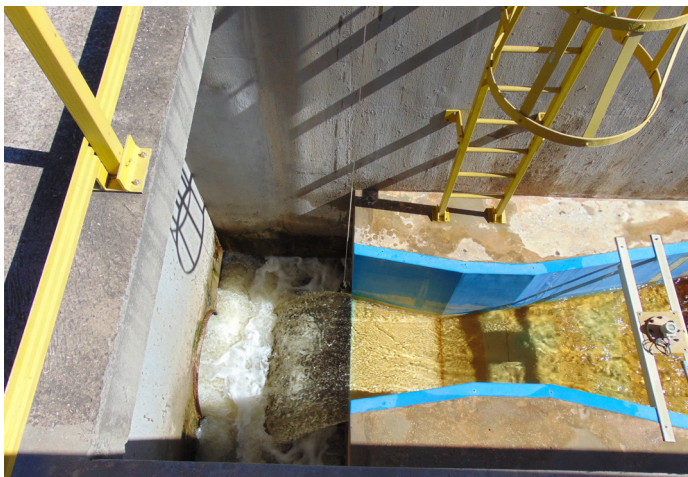
Água tratada na EPAR CAPIVARI II
